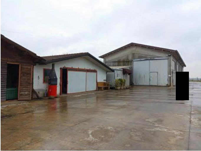
Fabbricato 1 e corpi accessori
