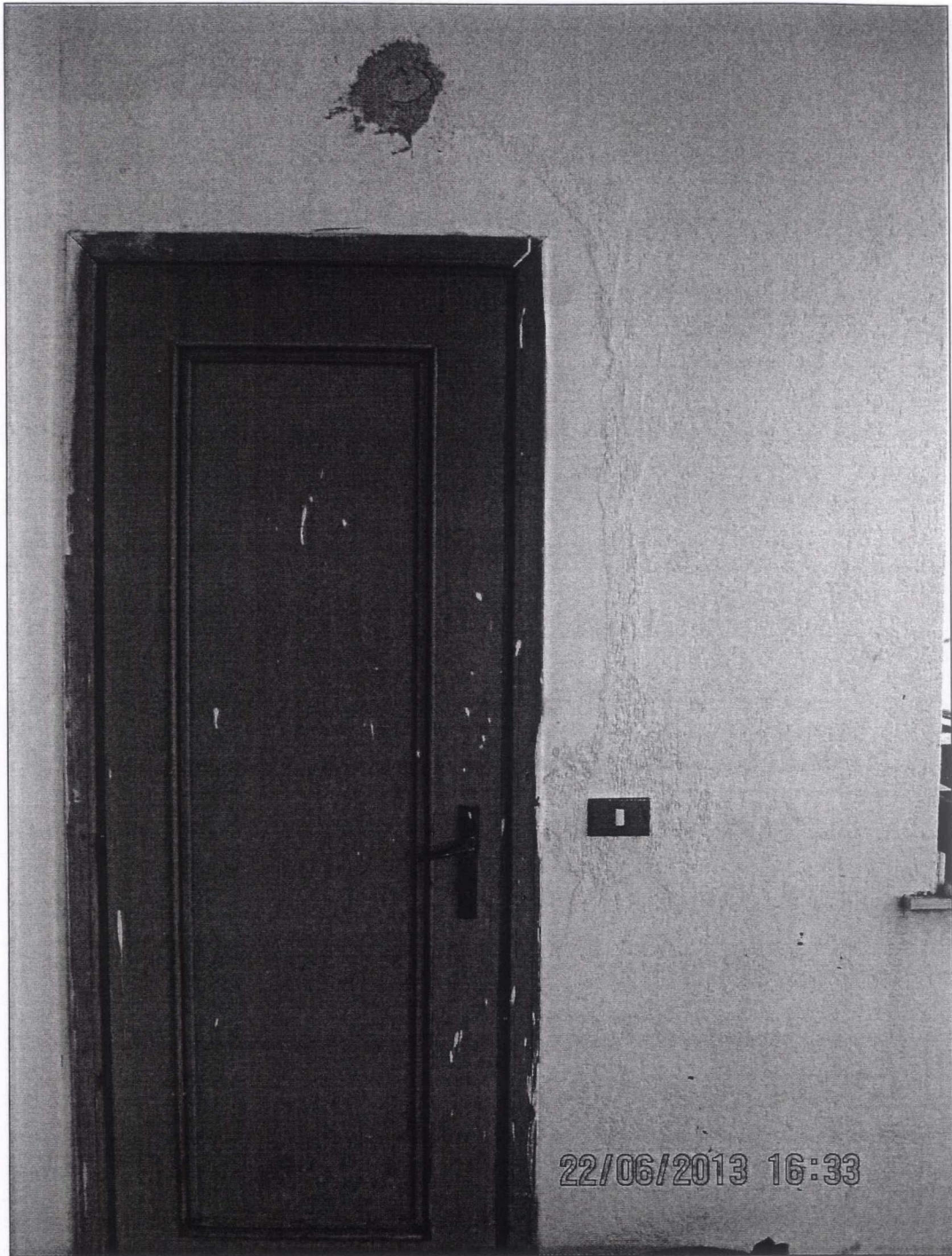
FOTO 13 - Porta del vano tecnico situato sul balcone.
