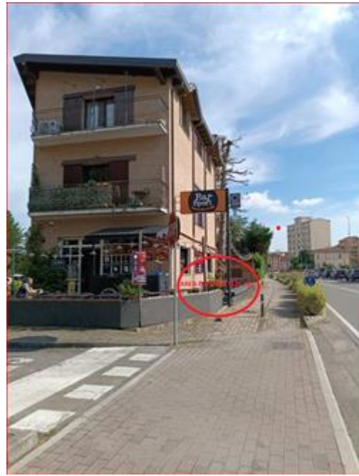
Vista Ingresso Locale Commerciale e Area sub.710
