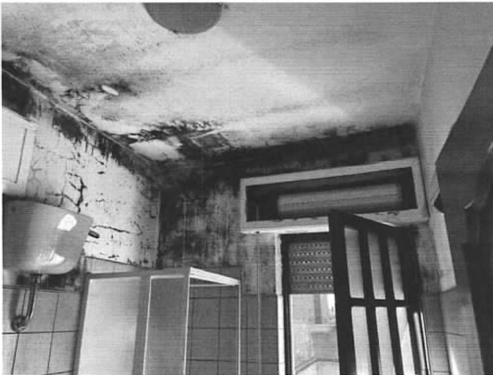
Foto 13: Presenza di muffe dovute alle infiltrazioni al piano primo (26/09/2023)
