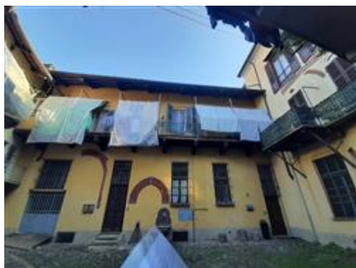
Palazzina 2B su cortile interno. L'alloggio è quello in alto a destra
