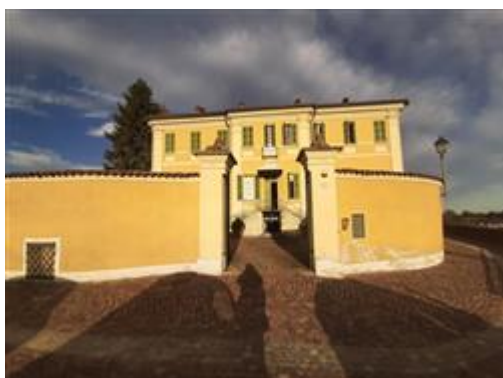
Vista del palazzo in cui è ubicata l'U.I.
