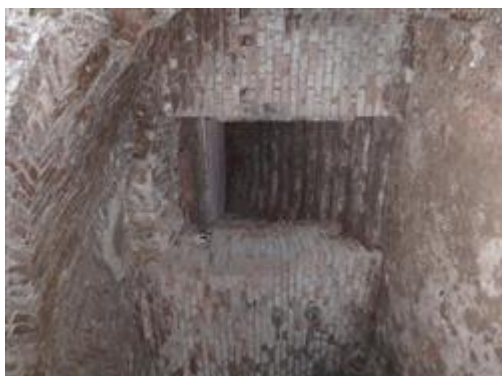
particolare della volta con l'accesso diretto, ora murato, all'alloggio. Pavimentazione in terra battuta
