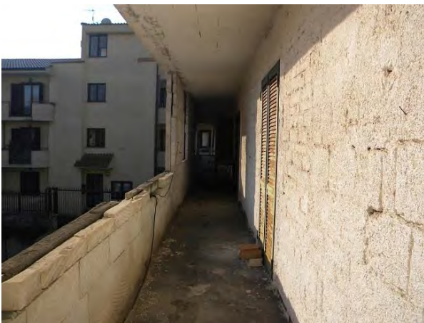
Balcone lato Est
