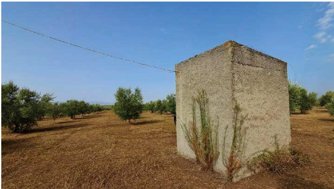
Foto 16: Catasto Terreni di Gioia Tauro, foglio 28, particella 61 – Fabbricato “f”.
