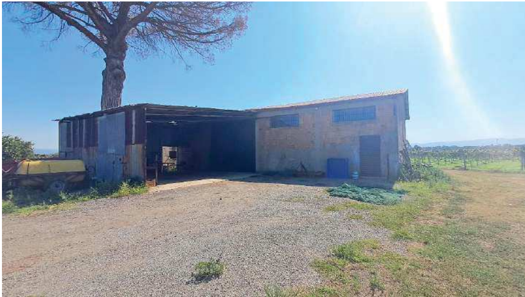
Foto 11: Catasto Terreni di Gioia Tauro, foglio 28, particella 61 – Il fabbricato “d”, si compone di un capannone destinato ad officina con annessa tettoia.
