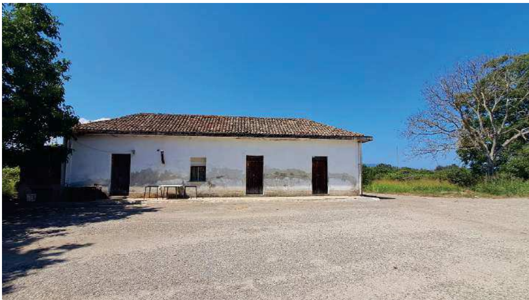
Foto 13: Catasto Terreni di Taurianova, foglio 18, particelle 12 e 13 – Fabbricato “d” – manufatto in muratura ordinaria e con tetto a falde inclinate, realizzato con struttura di legno e copertura di tegole, destinato ad abitazione.
