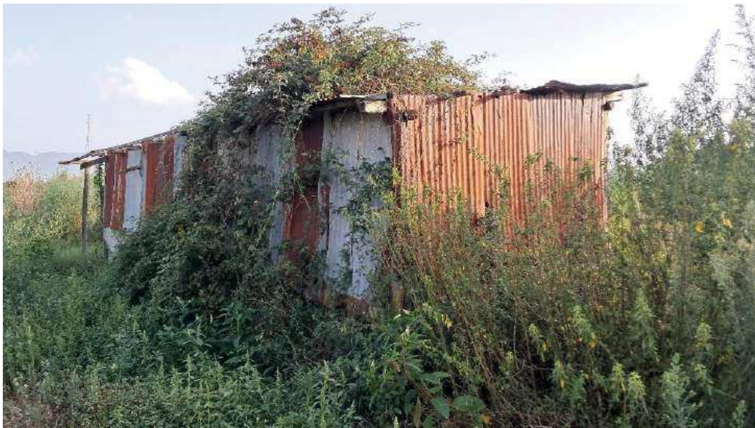
Foto 8: Catasto Terreni di Taurianova, foglio 18, particella 12 – All'interno della porzione di terreno di circa 70.00 are, al momento incolta, è stata rilevata la presenza dei resti di un manufatto ormai inutilizzabile, identificato con la lettera "g" nell'estratto di mappa riportato nell'allegato "2" alla presente relazione
