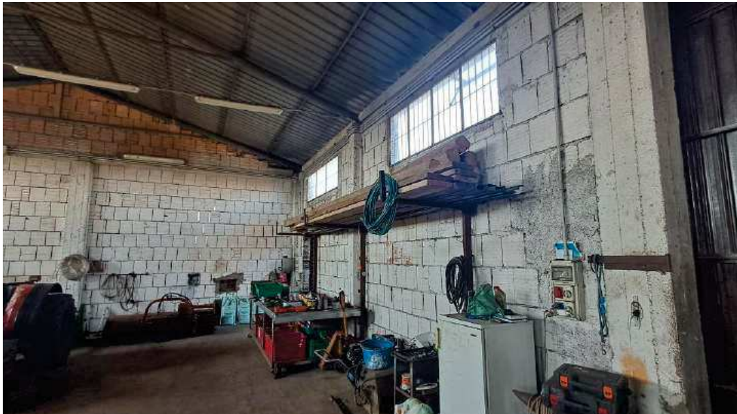
Foto 12: Catasto Terreni di Gioia Tauro, foglio 28, particella 61 – Interno del fabbricato “d”.
