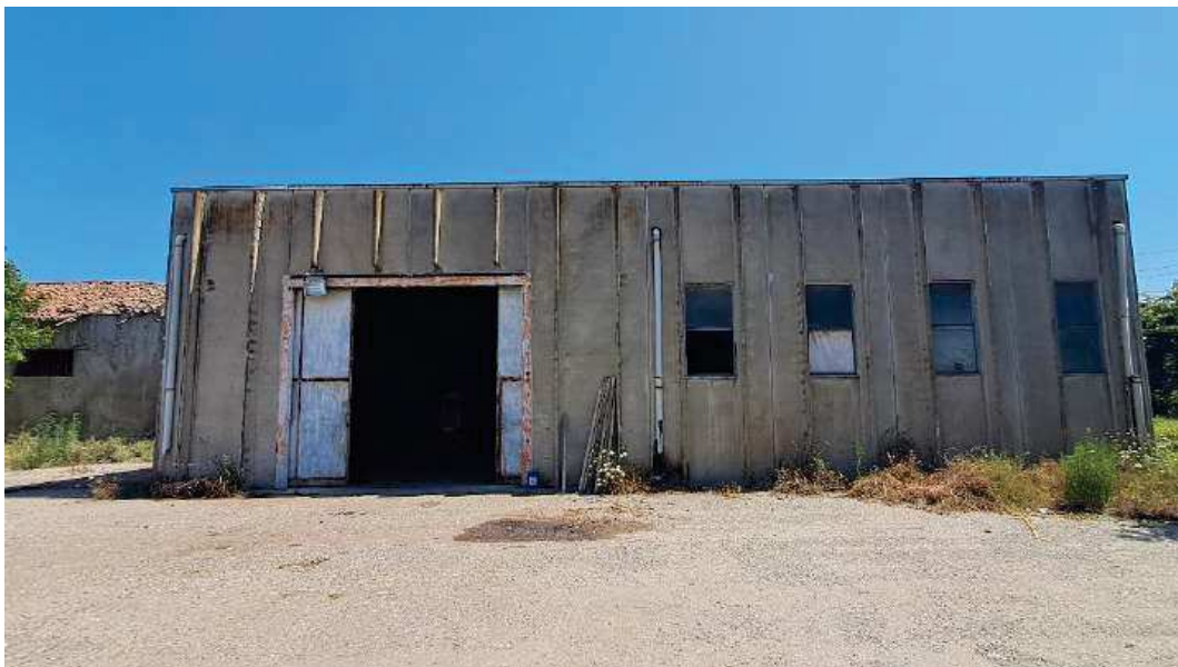
Foto 11: Catasto Terreni di Taurianova, foglio 18, particelle 12 e 13 – Fabbricato “c” – capannone in cemento armato precompresso a un piano fuori terra. La struttura, con pianta di forma rettangolare, misura circa metri 15,50 per metri 20,00, occupa una superficie lorda complessiva di circa 310,00 mq ed ha un’altezza interna utile di circa 5,00 metri. Il capannone si presenta in mediocri condizioni di manutenzione e conservazione.
