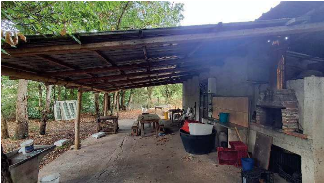
Foto 13: Catasto Terreni di Cittanova, foglio 60, particella 12 – La parte destinata a tettoia, realizzata con pali di legno e copertura di lamiera metalliche, misura circa metri 5,10 per metri 10,10.
