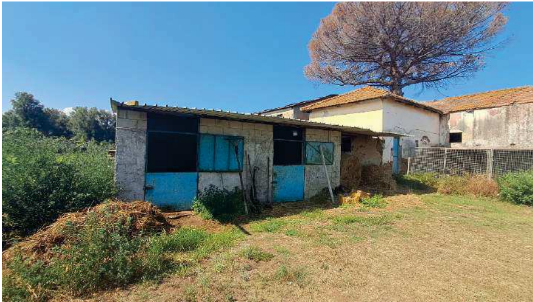
Foto 13: Catasto Terreni di Gioia Tauro, foglio 28, particella 61 – Fabbricato “e” - stalla, realizzata con struttura in muratura ordinaria con pareti in blocchi di calcestruzzo non intonacati. Il tetto, ad una falda inclinata, è stato realizzato con struttura di ferro ricoperta con lamiere grecate di metallo.
