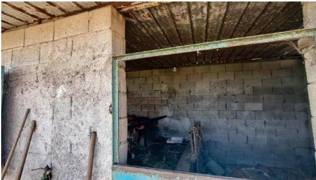
Foto 14: Catasto Terreni di Gioia Tauro, foglio 28, particella 61 – Fabbricato “e” - interno.
