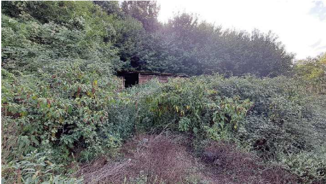
Foto 3: Catasto Terreni di Cittanova, foglio 60, particella 12 – Il fabbricato contrassegnato con la lettera “a”, quasi integralmente ricoperto dai rovi e ormai inutilizzabile, è stato realizzato con una struttura in pali di legno, pareti e tetto ricoperti da fogli di lamiera grecata di metallo.
