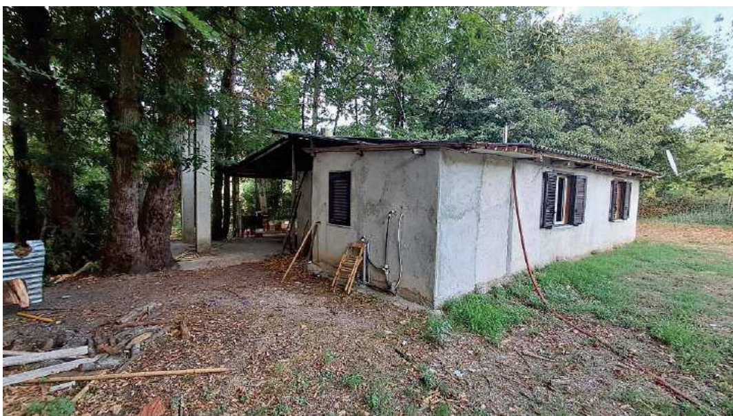
Foto 12: Catasto Terreni di Cittanova, foglio 60, particella 12 – Il fabbricato contrassegnato con la lettera “e”, in discrete condizioni di manutenzione e conservazione, consiste in un manufatto adibito ad abitazione con annessa tettoia.
