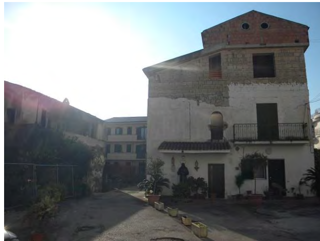
Il fabbricato di cui fa parte l'appartamento
