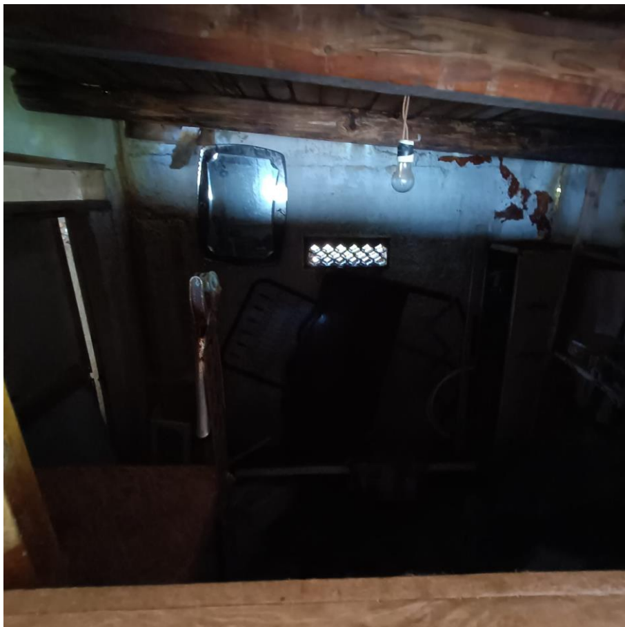
FOTO n.20 - Locale deposito da demolire
