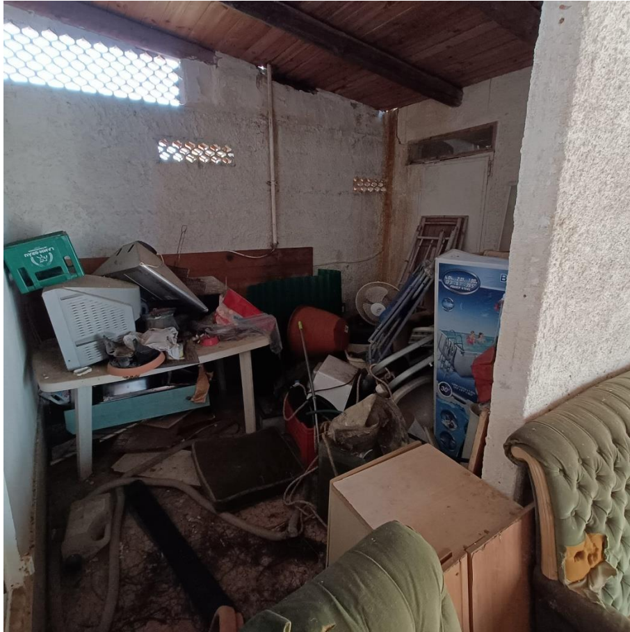
FOTO n.19 - Locale deposito da demolire
