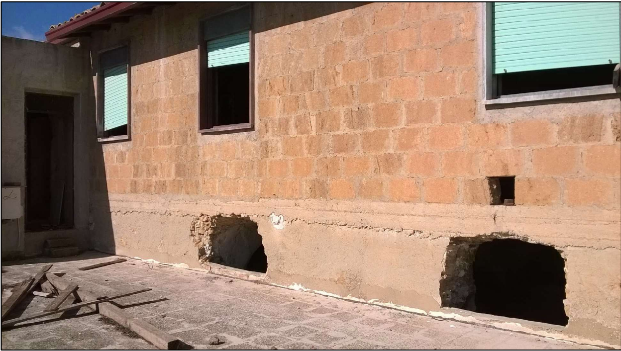
FOTO 36 - P.LLA 254 SUB 11 - VISTA ESTERNA, PROSPICIENTE IL TERRAZZO, DELLA FORZIONE DEL FABBRICATO DA RISTRUTTURARE
