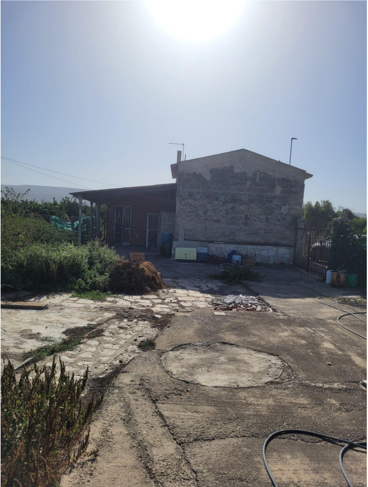
Foto n.1: foto lato sud est
