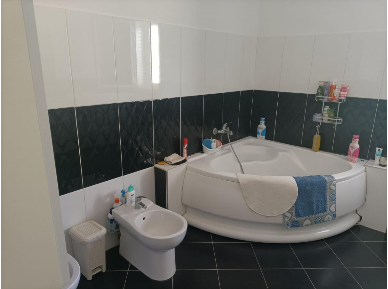
Foto n.10: interno fabbricato p.lla 979 (bagno)
