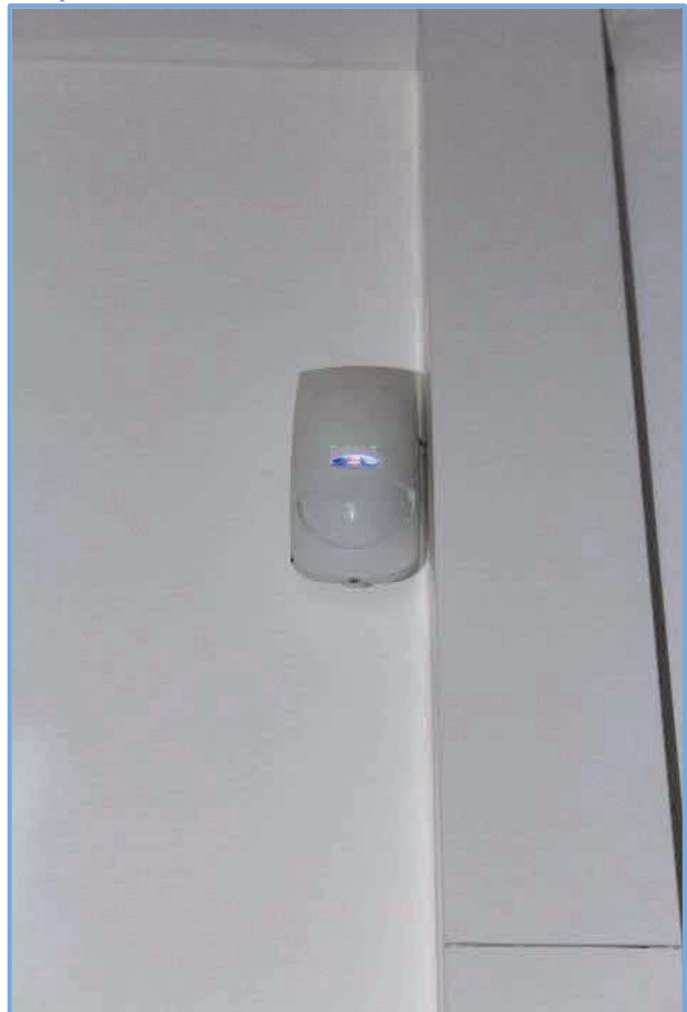
2.10, 2.11 – Locale di servizio – Vista di dettaglio sull'impianto di sicurezza antintrusione
