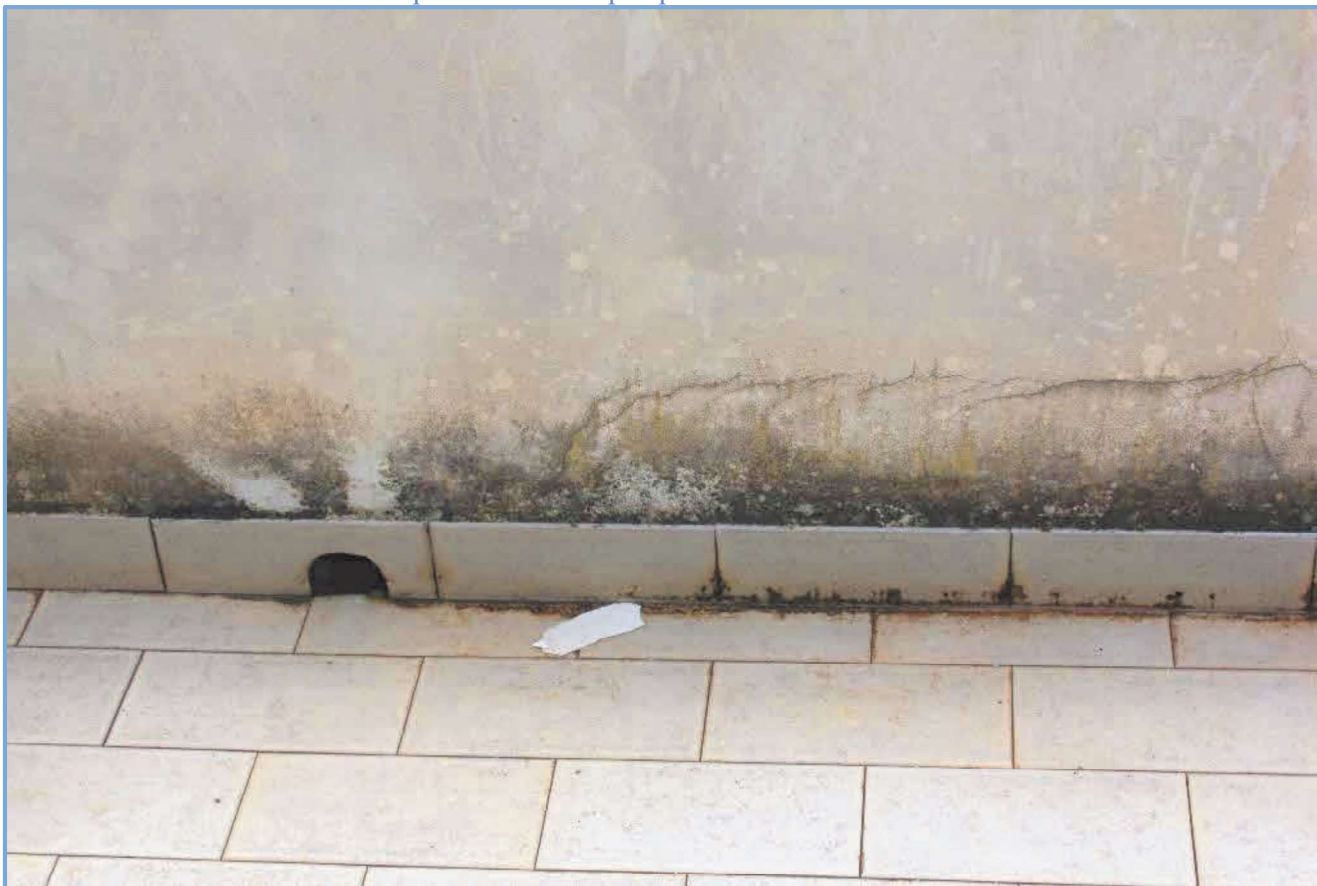
2.60 – Terrazzo lato Sud / Ovest – particolare vista parapetto murato
