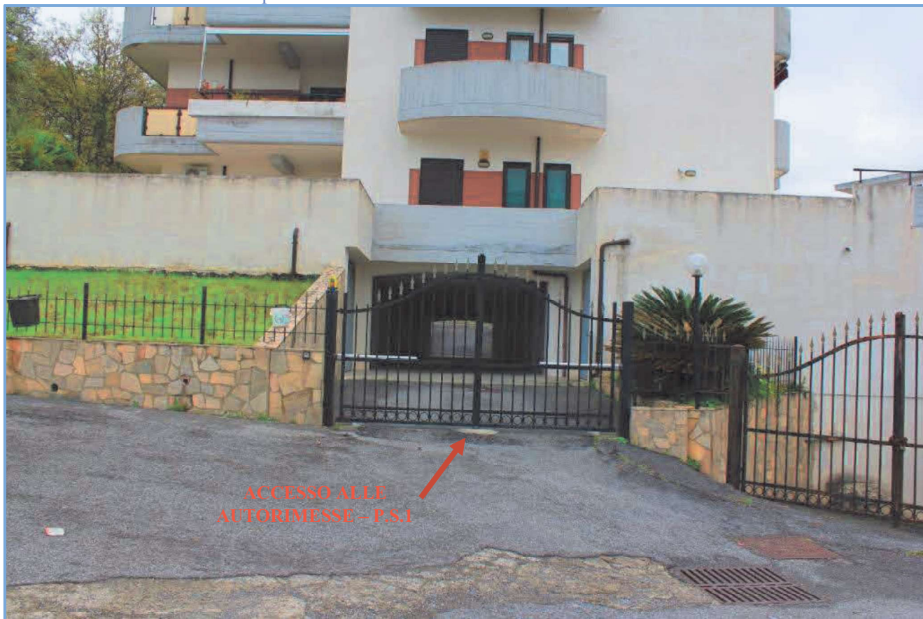
1.12 – Fabbricato – Accesso al piano Seminterrato 1
