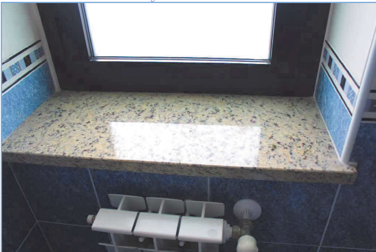
2.41 – Locale WC n° 2 – Vista avanzale in granito chiaro
