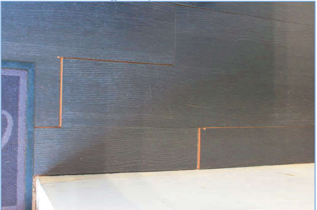
2.49 – Ufficio – Particolare vista danneggiamento al pavimento in laminato
