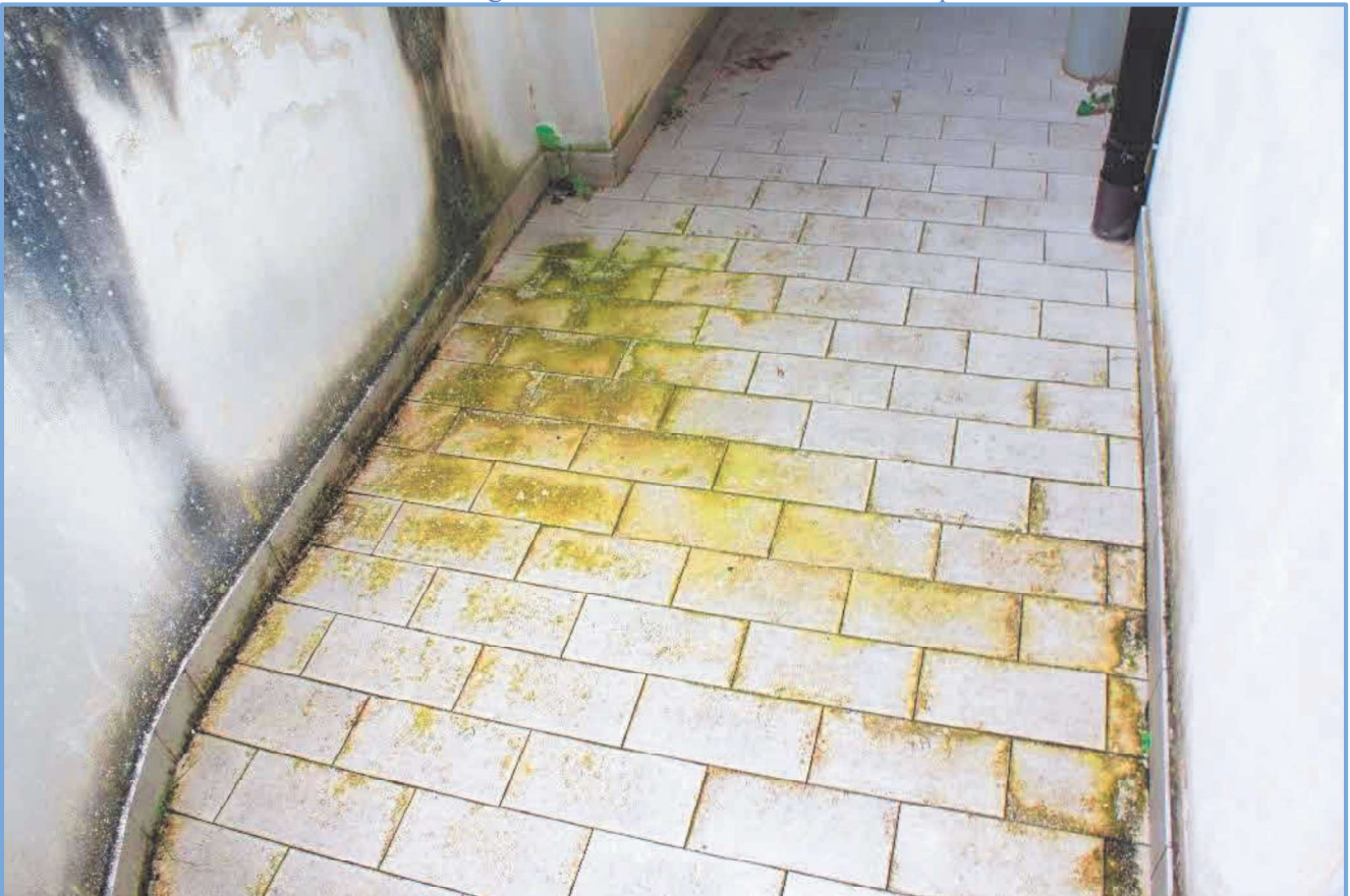
2.68 – Porzione di terrazzo retrostante il giardino n° 1 – Particolare vista sulla pavimentazione
