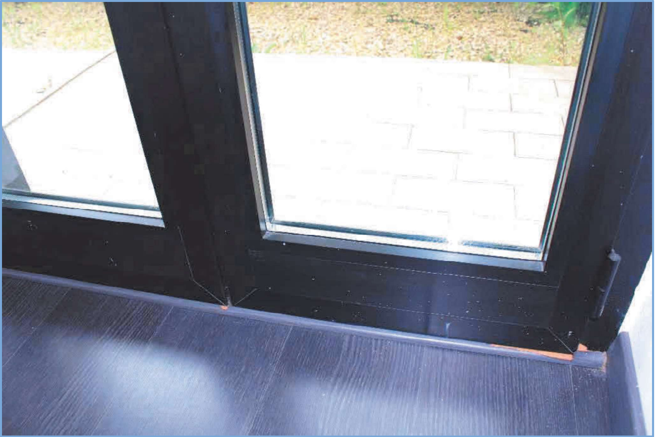
2.24 – Locale Ufficio n° 2 – Particolare infisso
