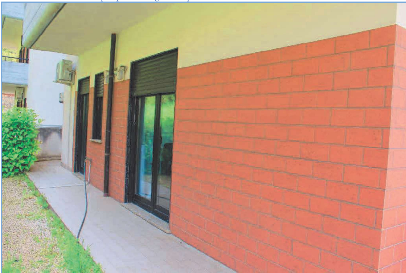
2.64 – Porzione di terrazzo prospiciente il giardino pensile n° 1
