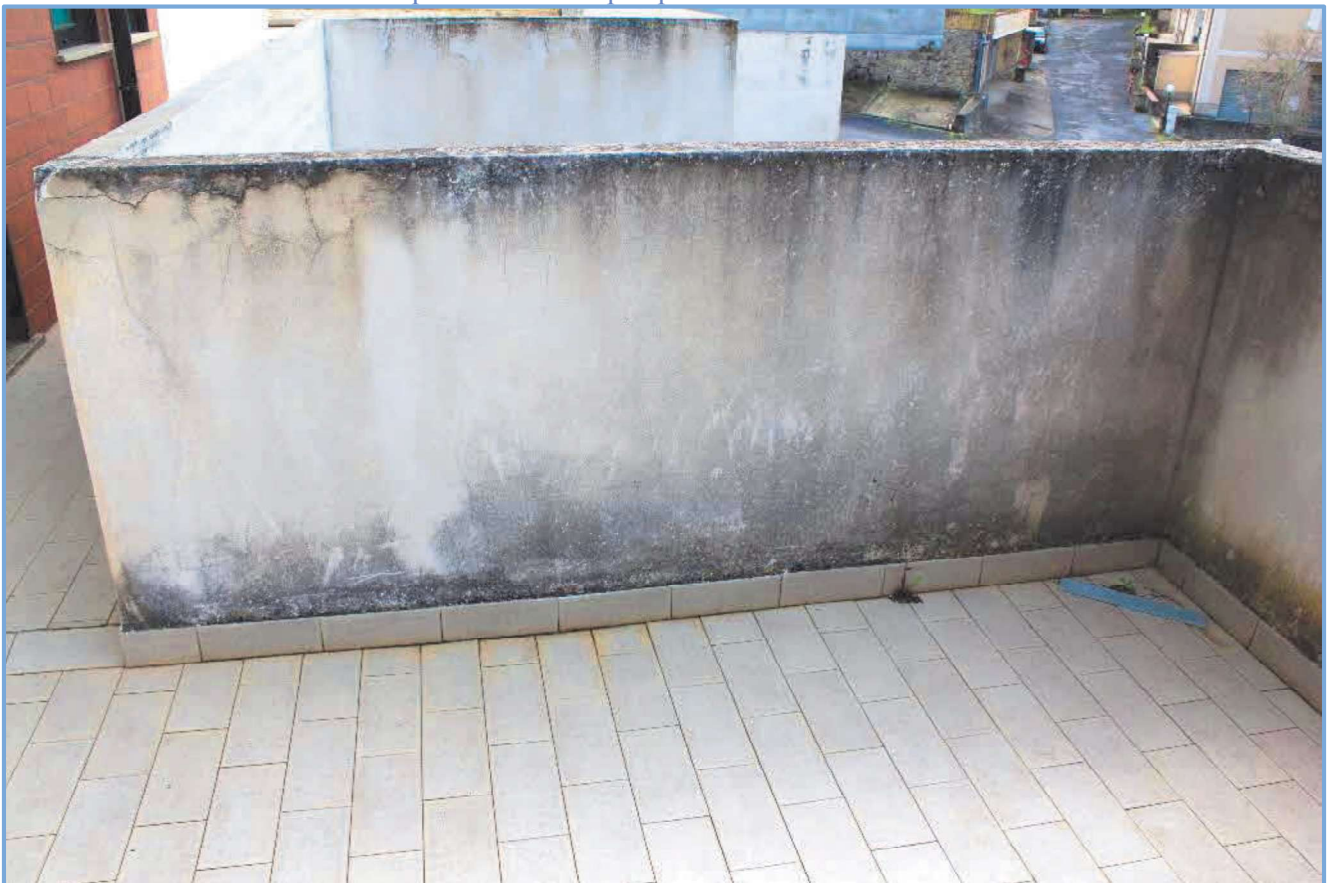
2.59 – Terrazzo lato Sud / Ovest – particolare vista parapetto murato
