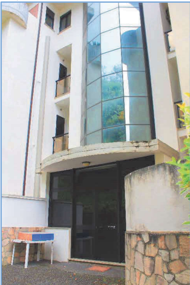
1.15, 1.16 – Portone di accesso al vano scala
