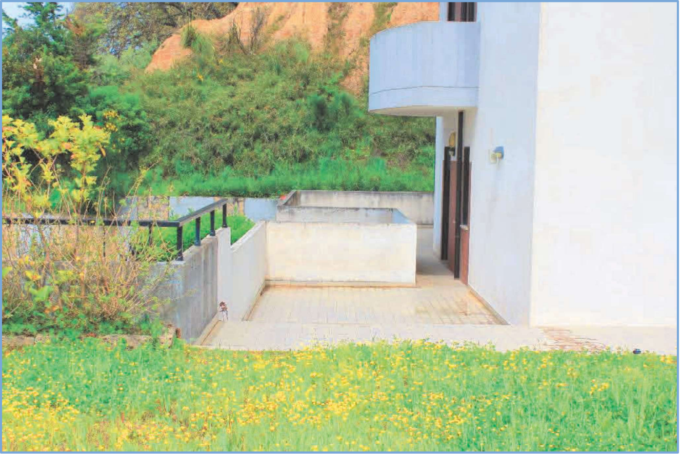
2.56 – Vista verso il terrazzo lato Sud / Ovest
