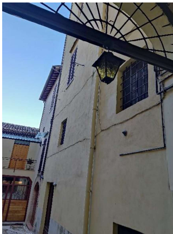
Vista da cortile interno
