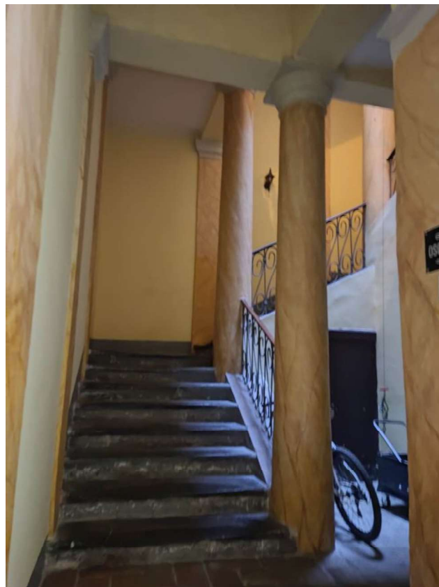
Vano scala condominiale
