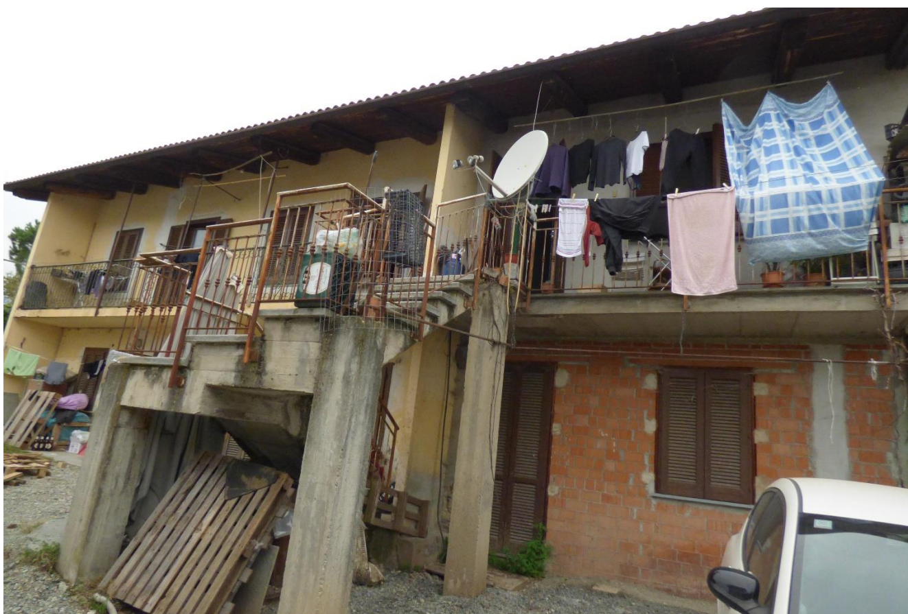
FABBRICATO Bagnolo P. – Via Busch
