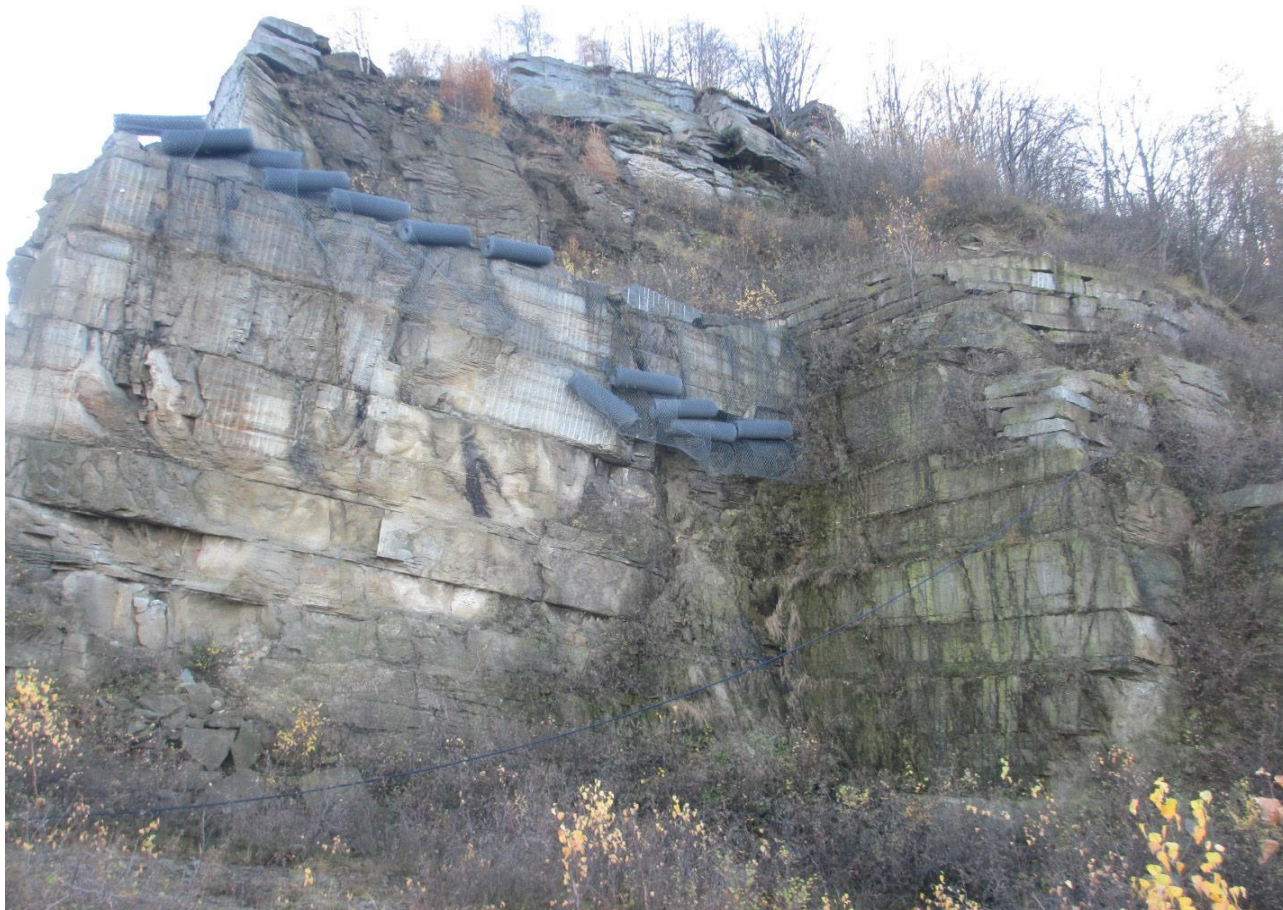
CAVA: vista cantiere superiore Lotti 17-18-19
