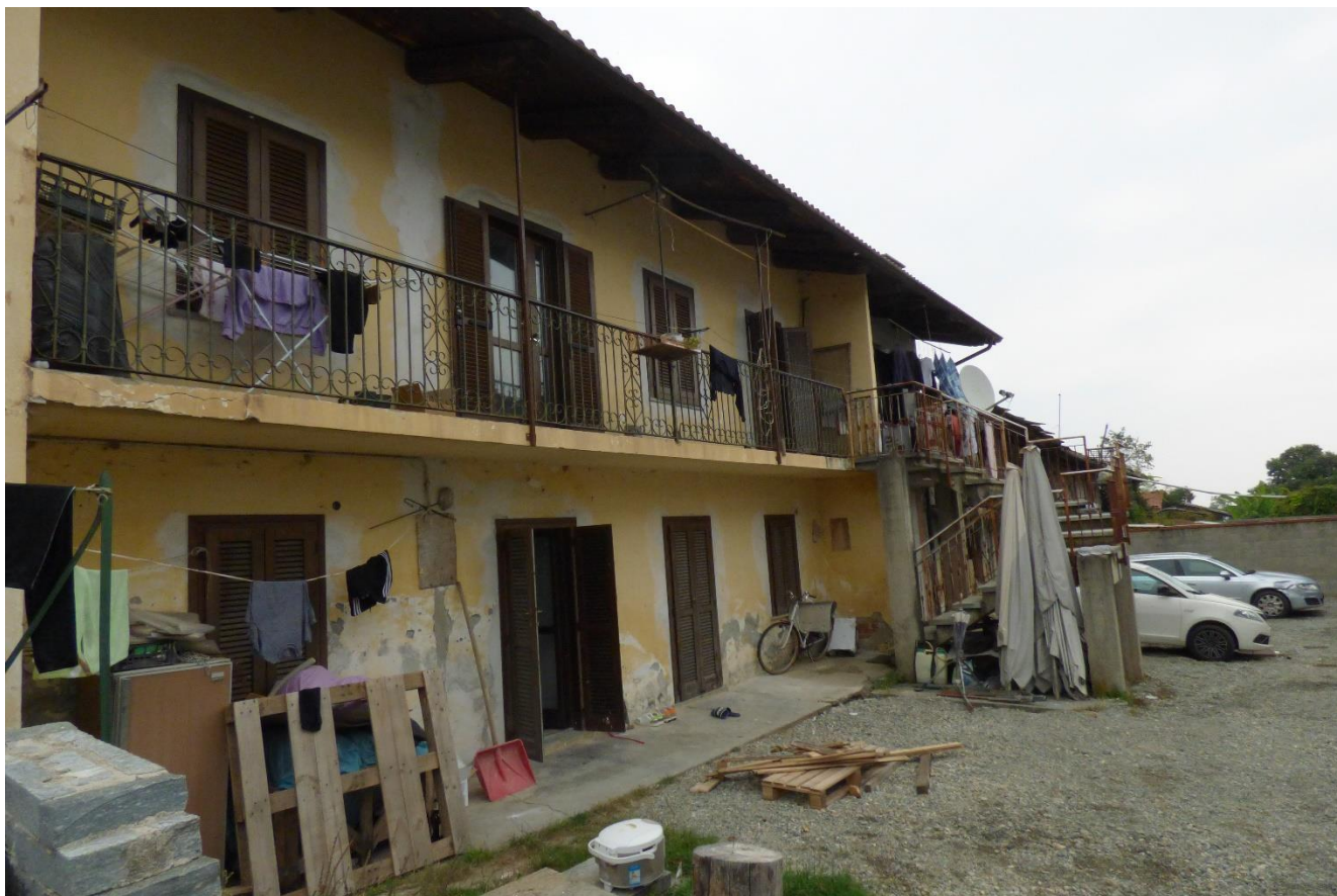
FABBRICATO Bagnolo P. – Via Busch
