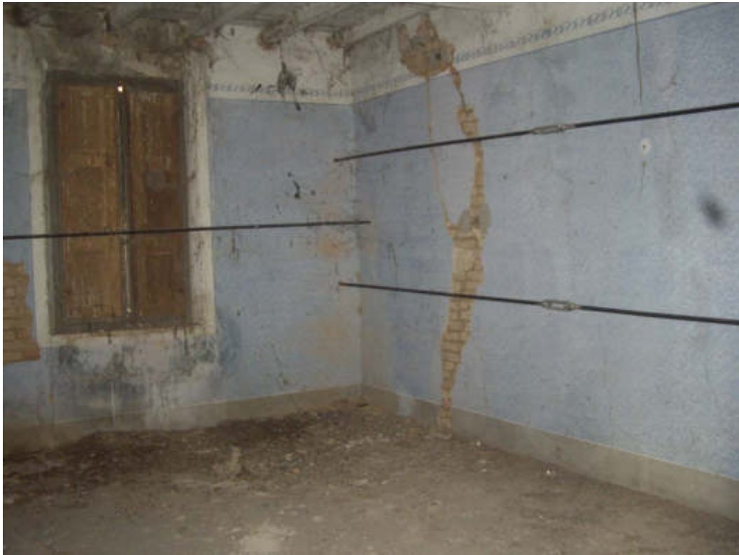
CAMERA 1 CON EVIDENZIATI I TIRANTI DI SICUREZZA
