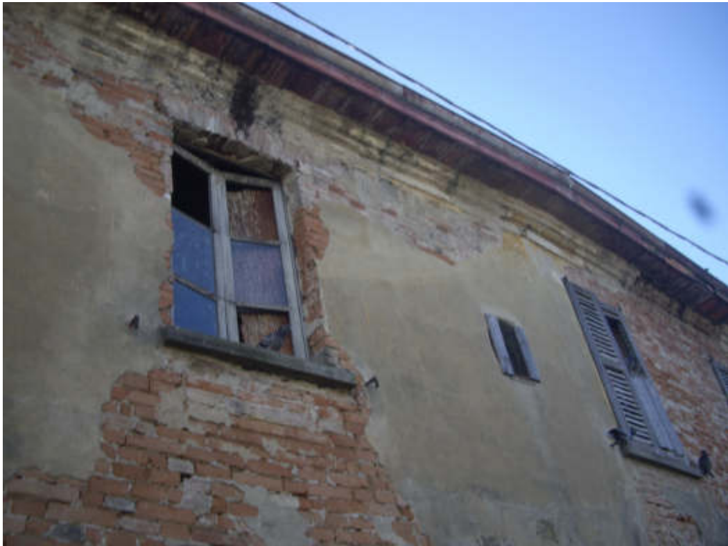
PARTICOLARE STATO CONSERVATIVO FACCIATA E SERRAMENTI
