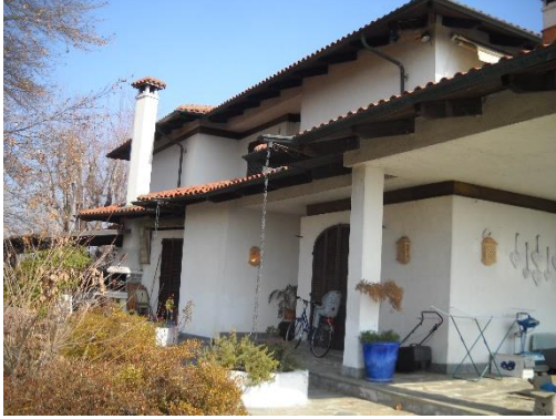
Porzione di casa bifamiliare
