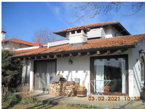
Porzione di casa bifamiliare
