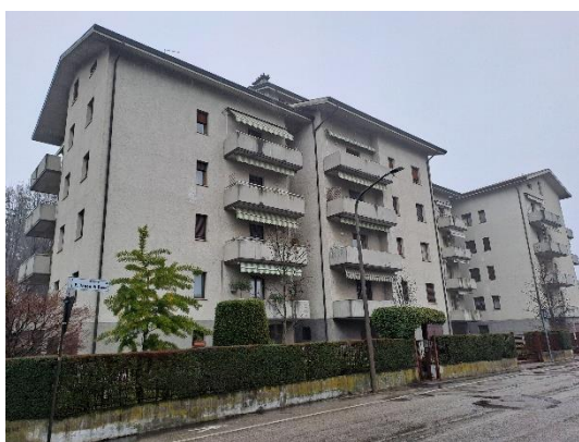
Vista generale da Sud-Ovest
