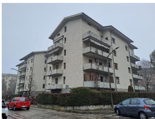
Vista generale da Sud-Est
