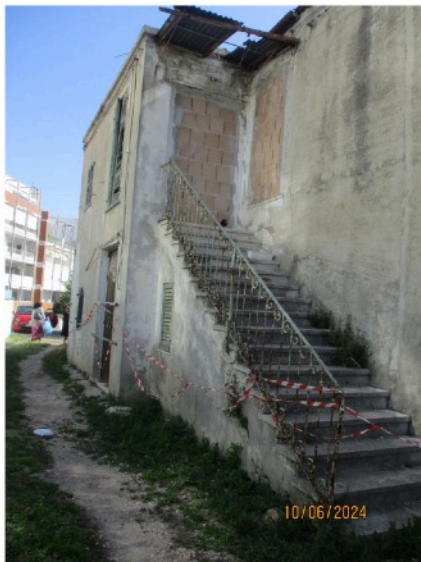
1 – Prospetto esterno – p.primo
