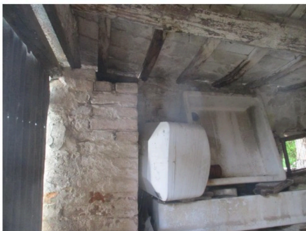
12 – Interno – p.terra - sub.9 – locale legnaia
