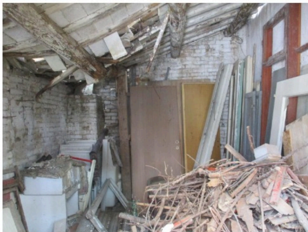
11 – Interno – p.terra - sub.9 – locale legnaia
