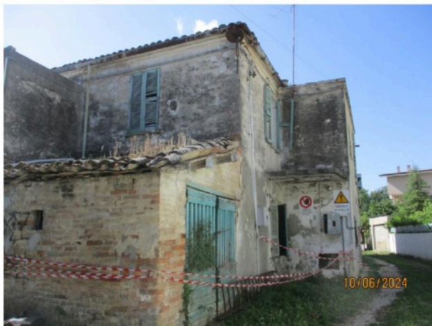
2 – Prospetto esterno – p.primo
