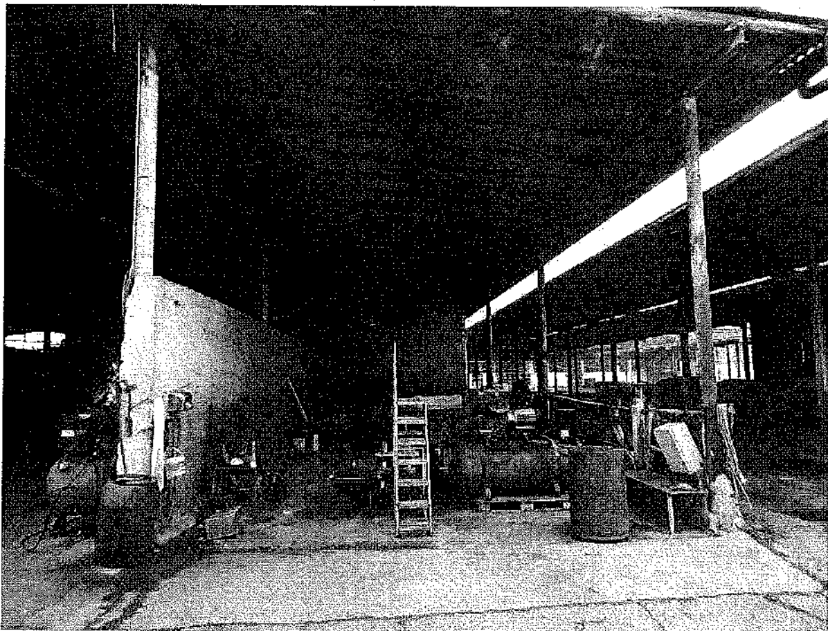
MAGAZZINO PER MANUTENZIONI
