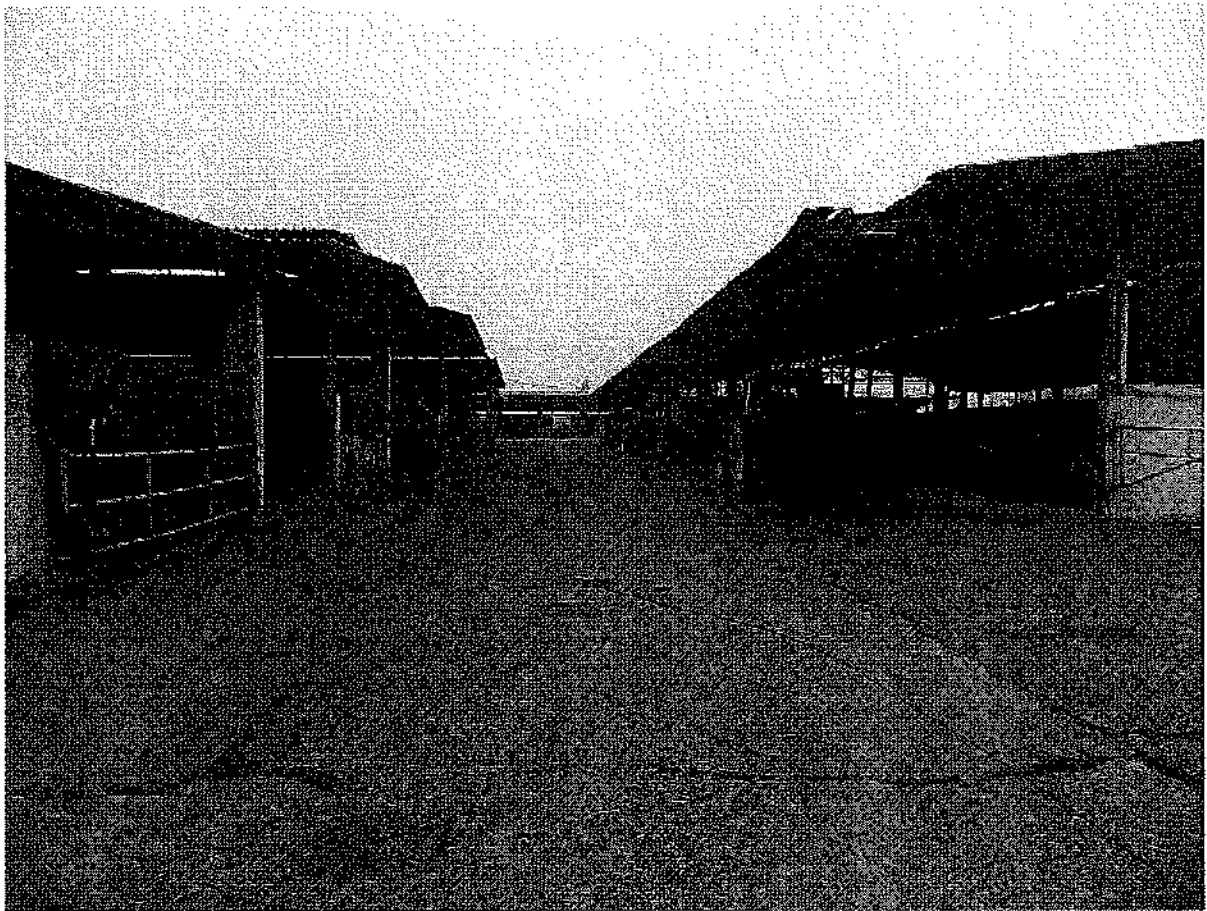
ZONA CENTRALE FRA LE DUE STALLE IN FERRO (SUD-NORD)
