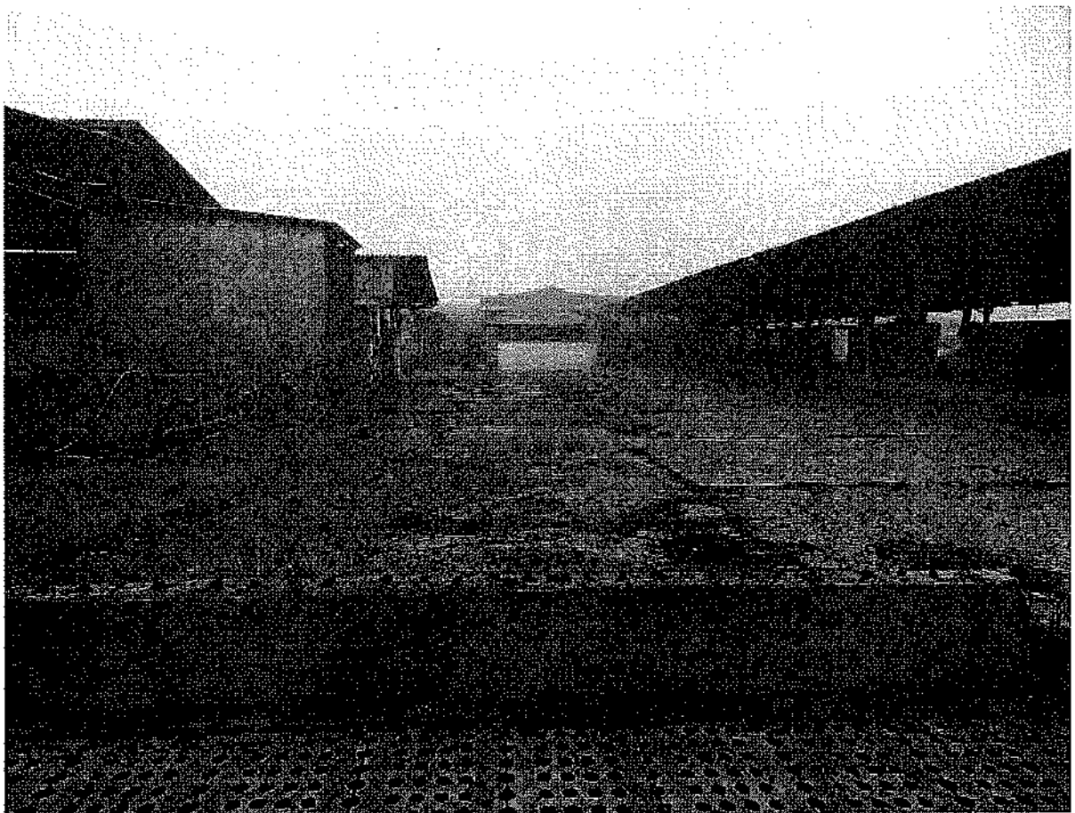
ZONA A FRONTE DELLA STALLA APERTA
