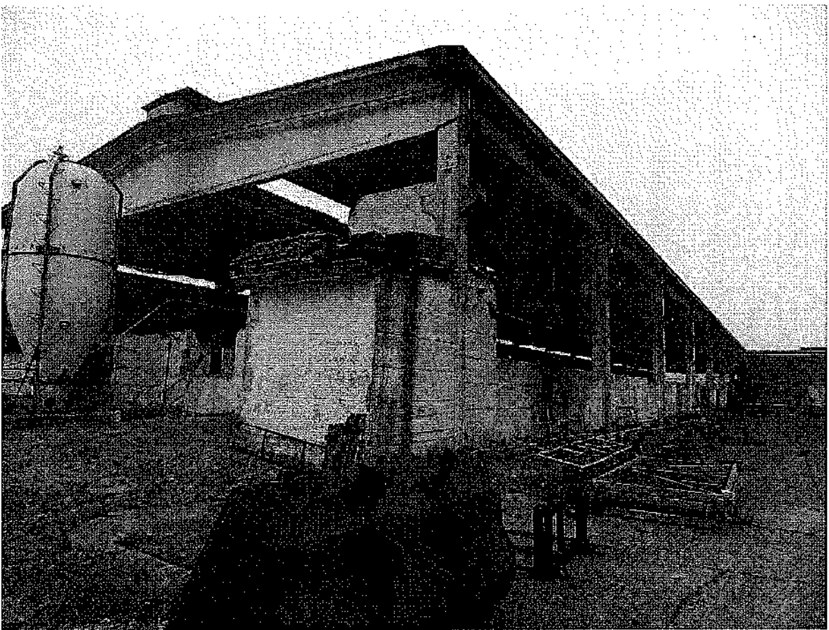
VISTA ESTERNA DELLA STALLA IN C.A.
