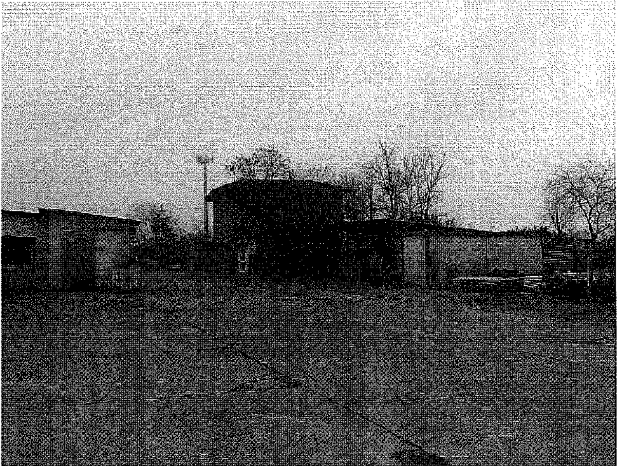
PIAZZALE ZONA D'INGRESSO CON CASA AGRICOLA
