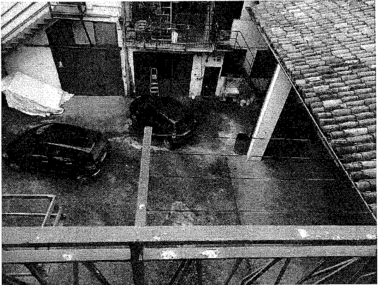
VISTA DEL CORTILE DAL TERRAZZO
