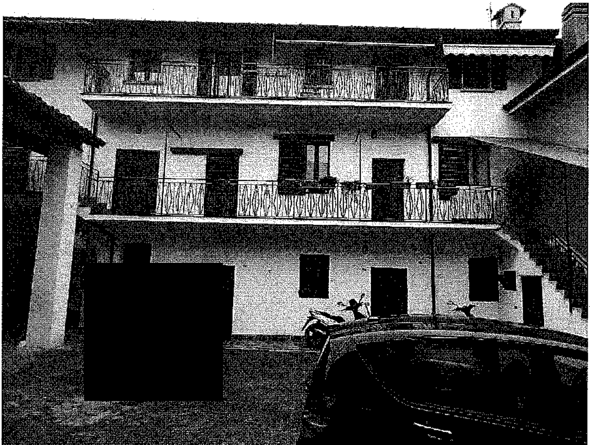
VISTA DEL FRONTE DEL FABBRICATO DAL CORTILE
