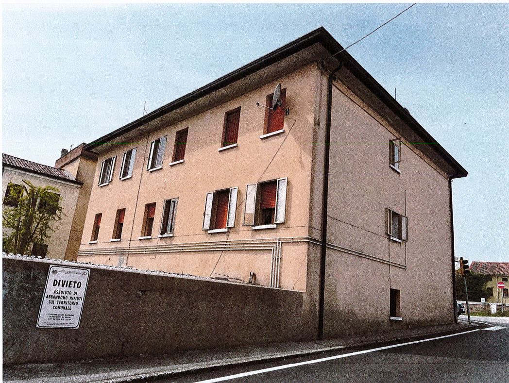
Vista del Fabbricato oggetto di E.I.
