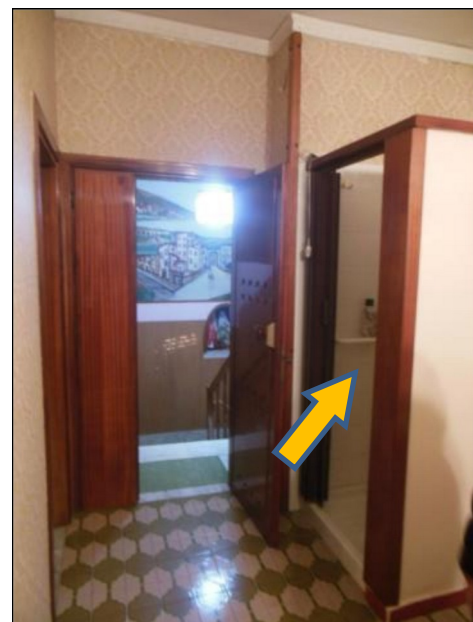
Vano doccia realizzato nel disimpegno all'ingresso del primo piano
