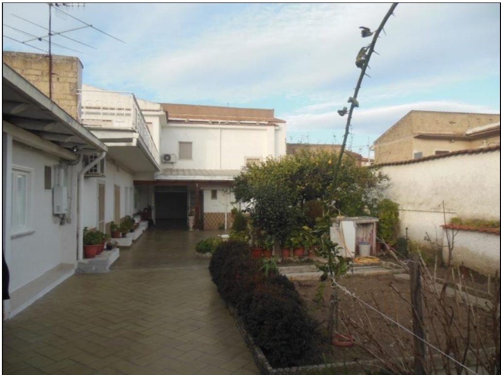
Cortile interno visto dal lato sud
