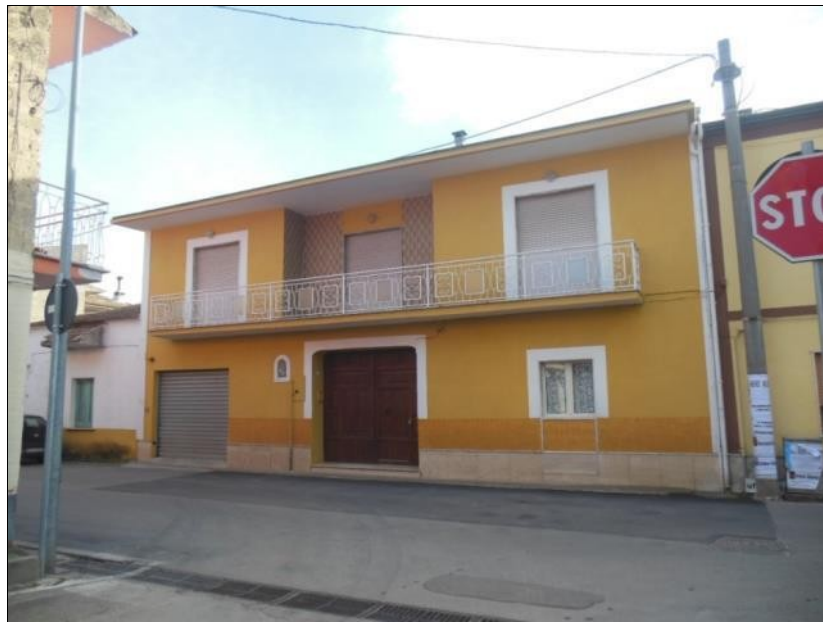
Prospetto su Via Fiume Savone – stato di fatto al 2019
