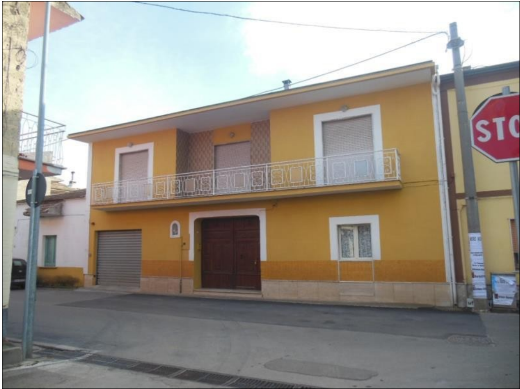
Prospetto su Via Fiume Savone
