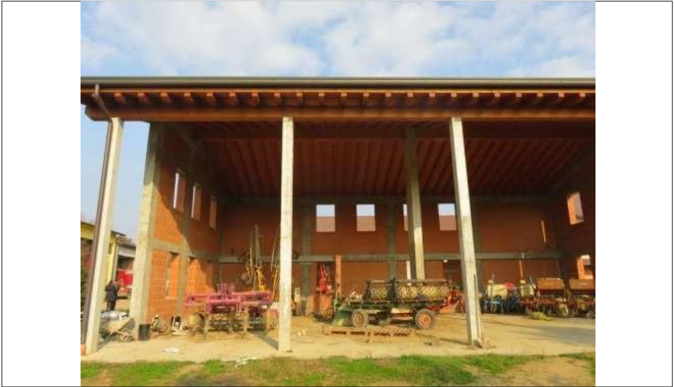
49 Vista del fronte Sud dell'immobile 3;
