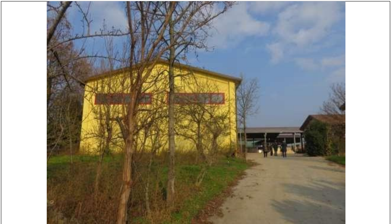
52 Vista del fronte Sud dell'immobile 4 adibito a deposito foraggi e mangimi;
