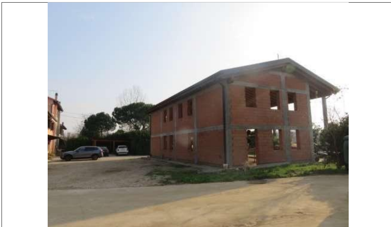
47 Vista dell'annesso rustico, angolo Nord-Ovest si notano le differenti forometrie;
