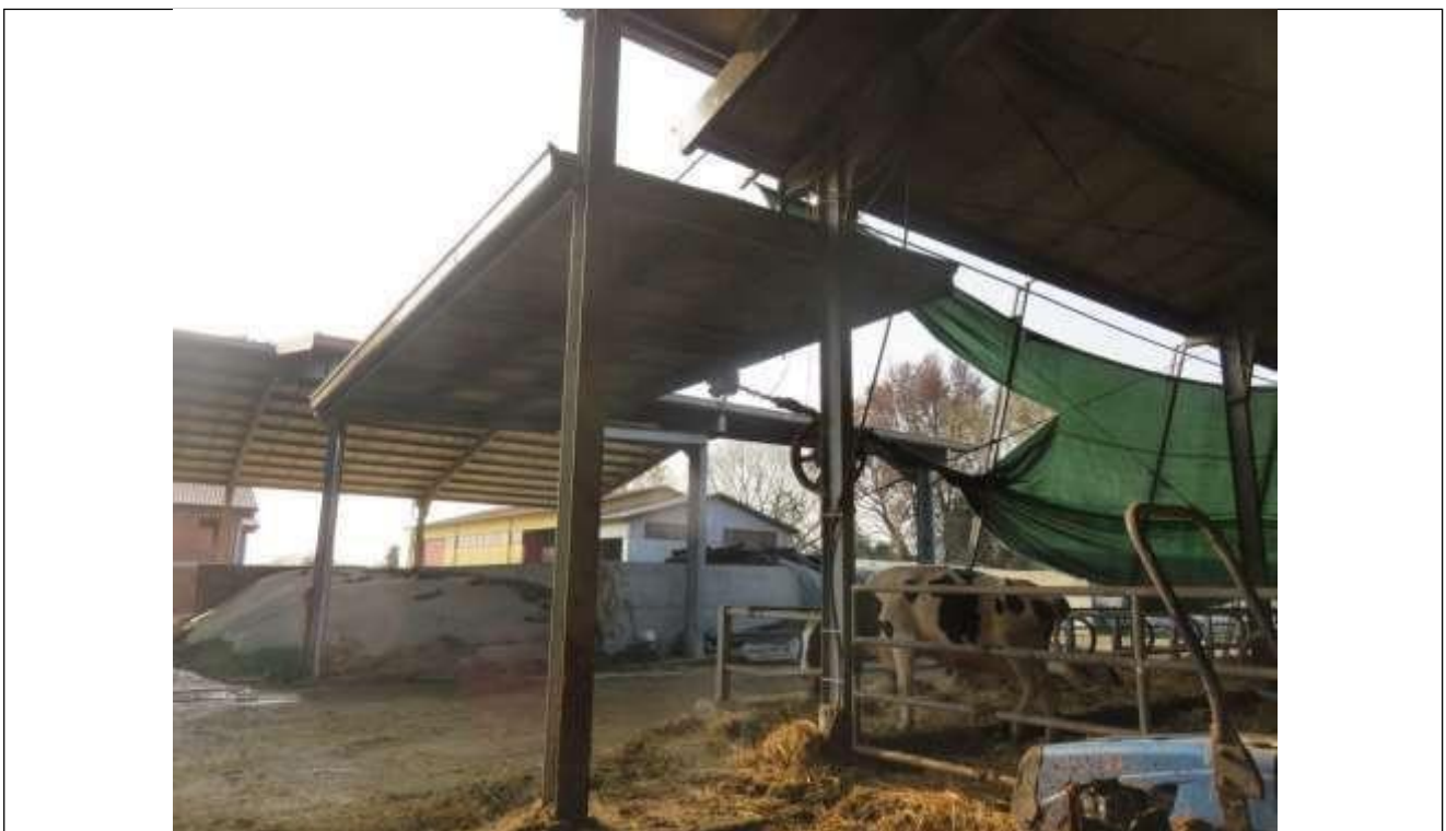
82 Vista della tettoia aperta sui quattro lati, di collegamento tra l'immobile 5 e l'immobile 6;
