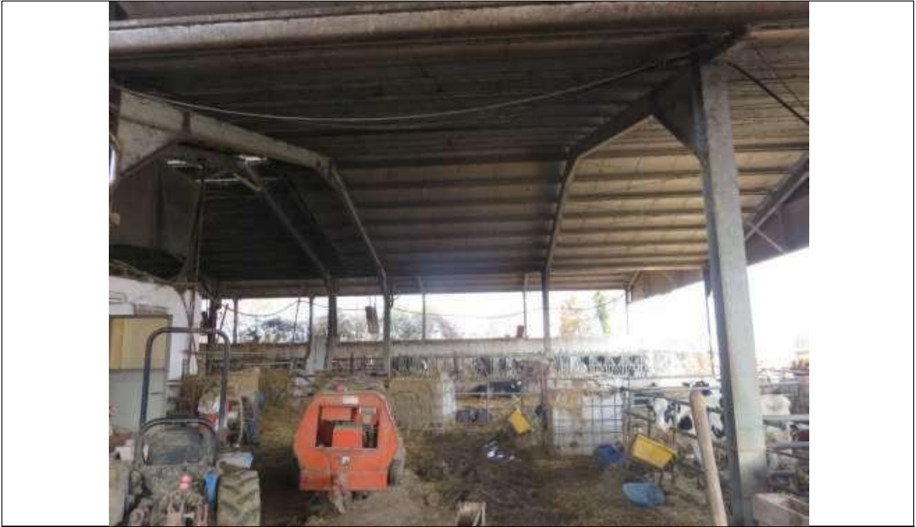
87 Vista della porzione in ampliamento del deposito foraggi-scorte ed attrezzi;
