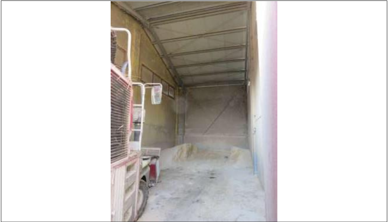
57 Vista interna della porzione in ampliamento;
