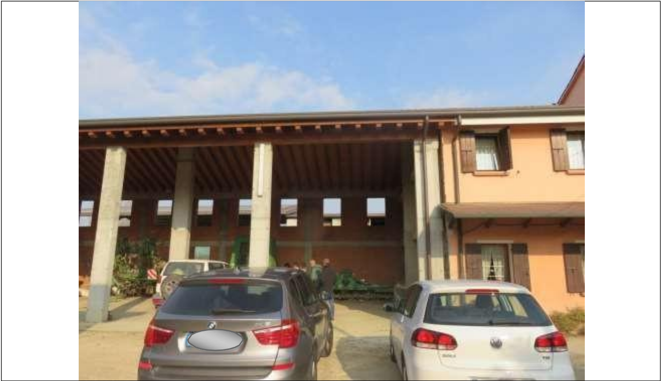
41 Vista dell'annesso rustico costruito in aderenza all'abitazione ed attualmente allo stato di grezzo;
