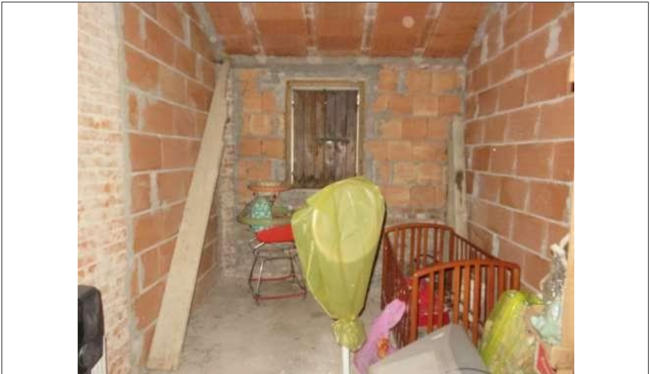
31 Vista della camera allo stato grezzo;
