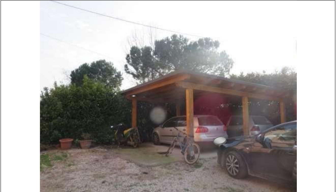
11 Vista della tettoia abusiva ed oggetto di demolizione;
