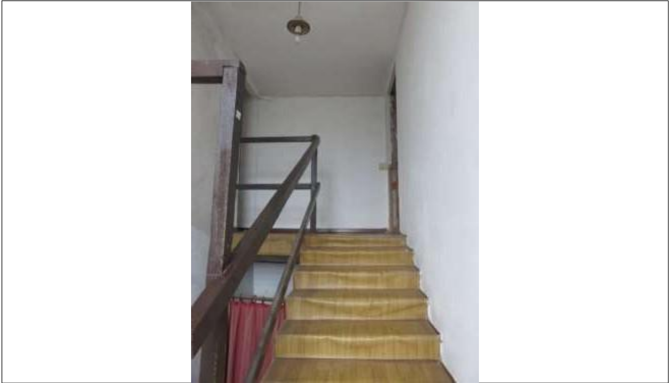
25 Vista della scala verso il piano primo;
