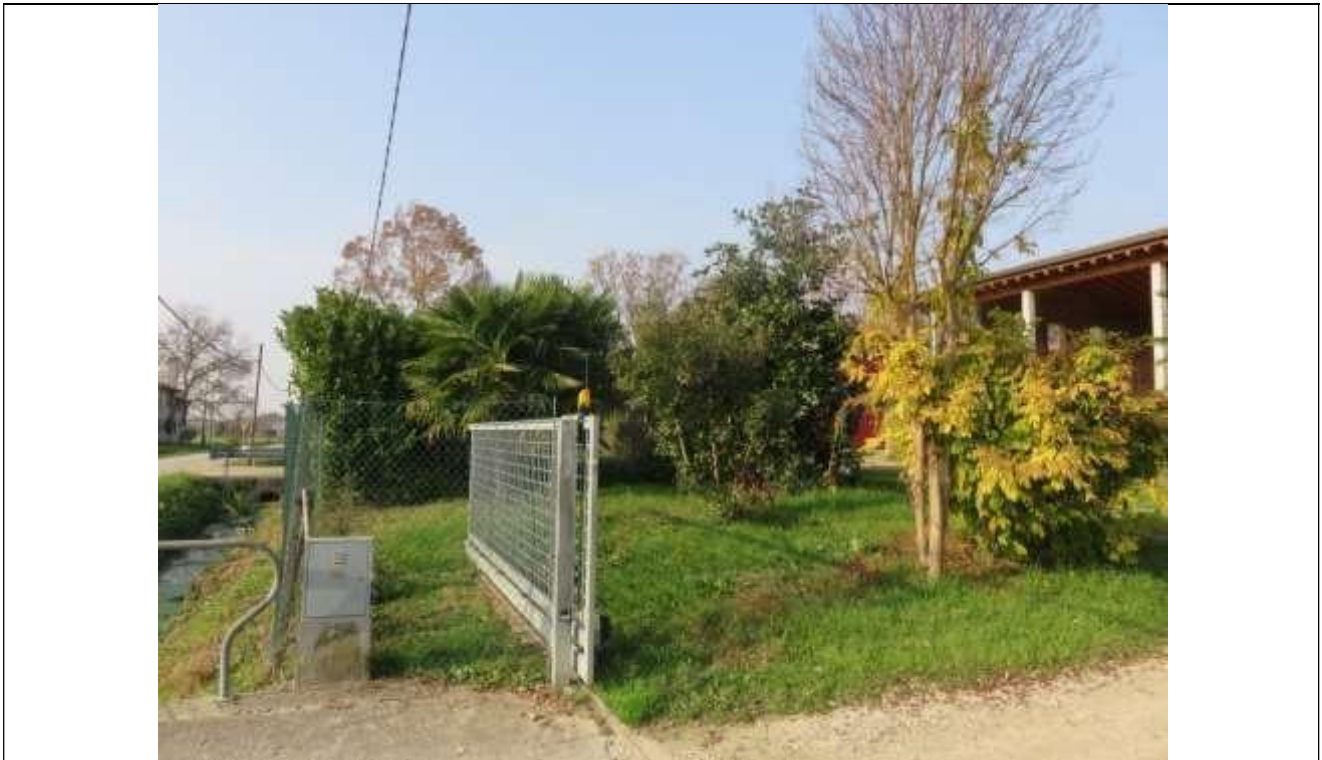
07 Altra vista del cancello carraio di accesso, posto nell'angolo Sud-Est della proprietà;
