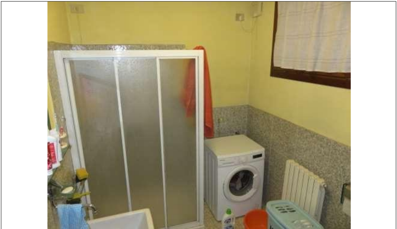
23 Vista del secondo bagno – a destra si nota la finestra aperta verso il locale centrale termica;
