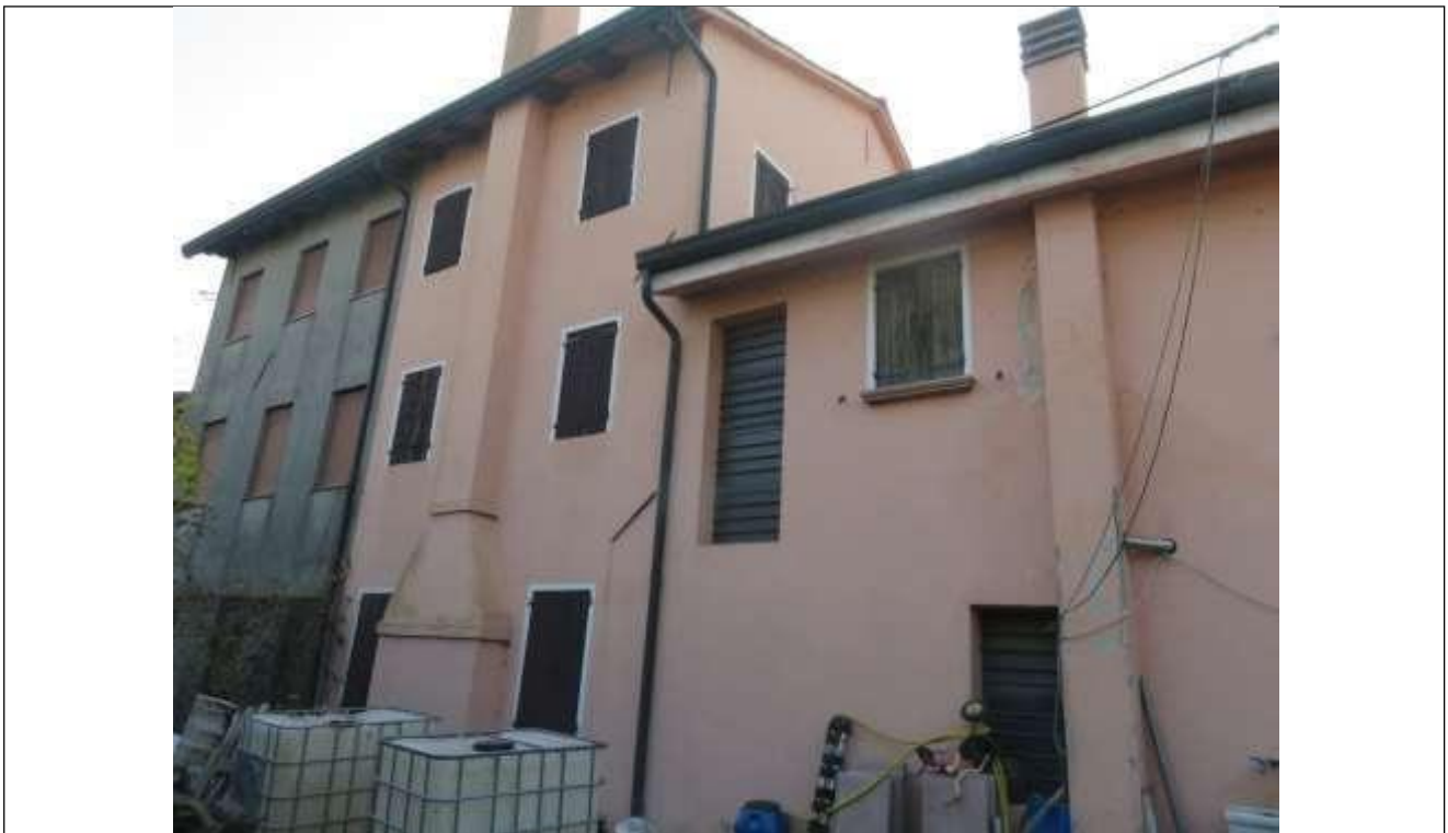
66 Vista del fronte Nord dell'immobile 1 -abitazione;
