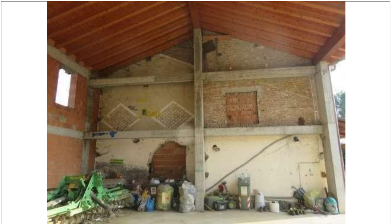
43 Particolare della parete divisoria posta tra l'abitazione e l'annesso rustico;
