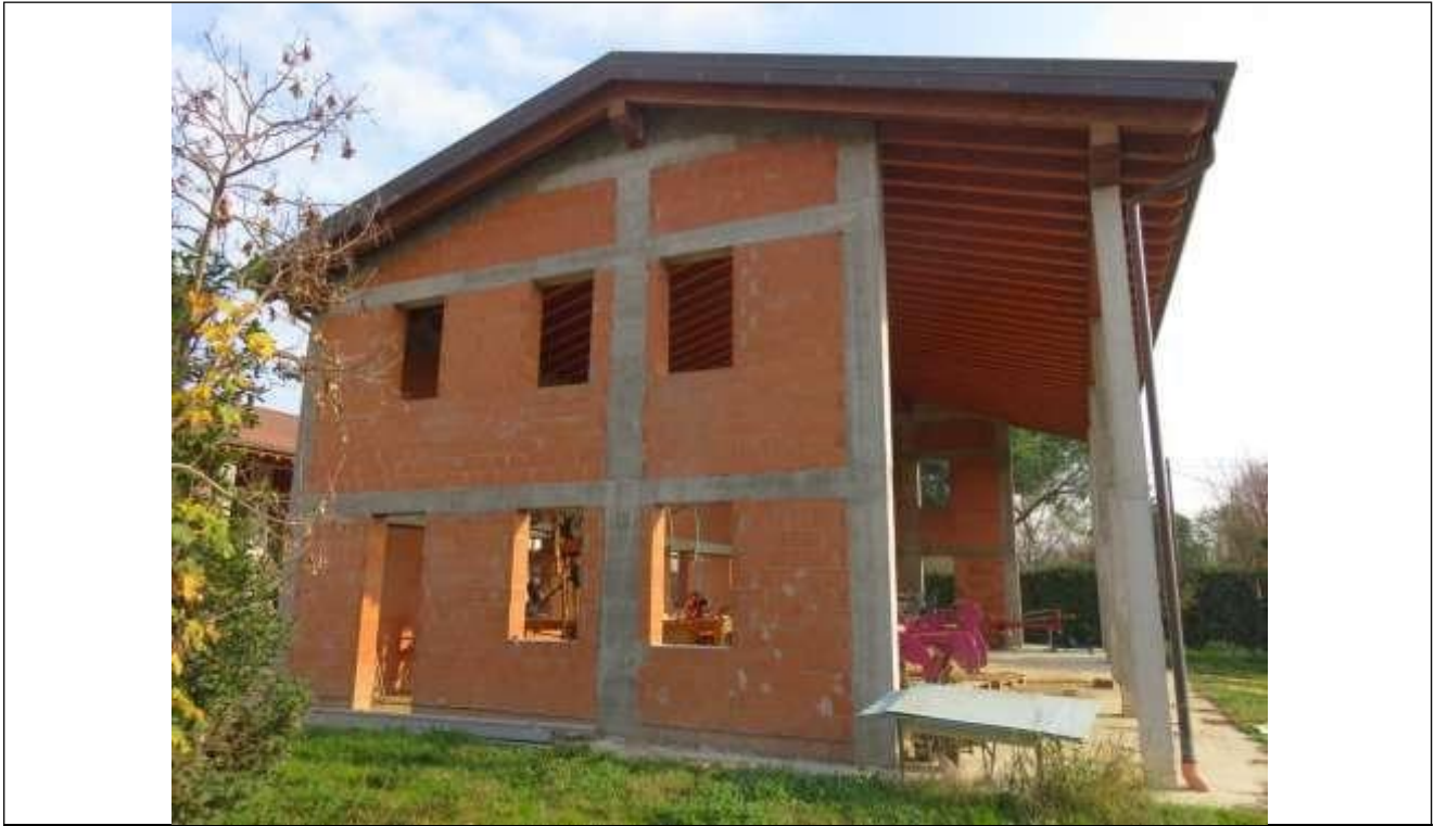
51 Vista del fronte Ovest dell'immobile 3;
