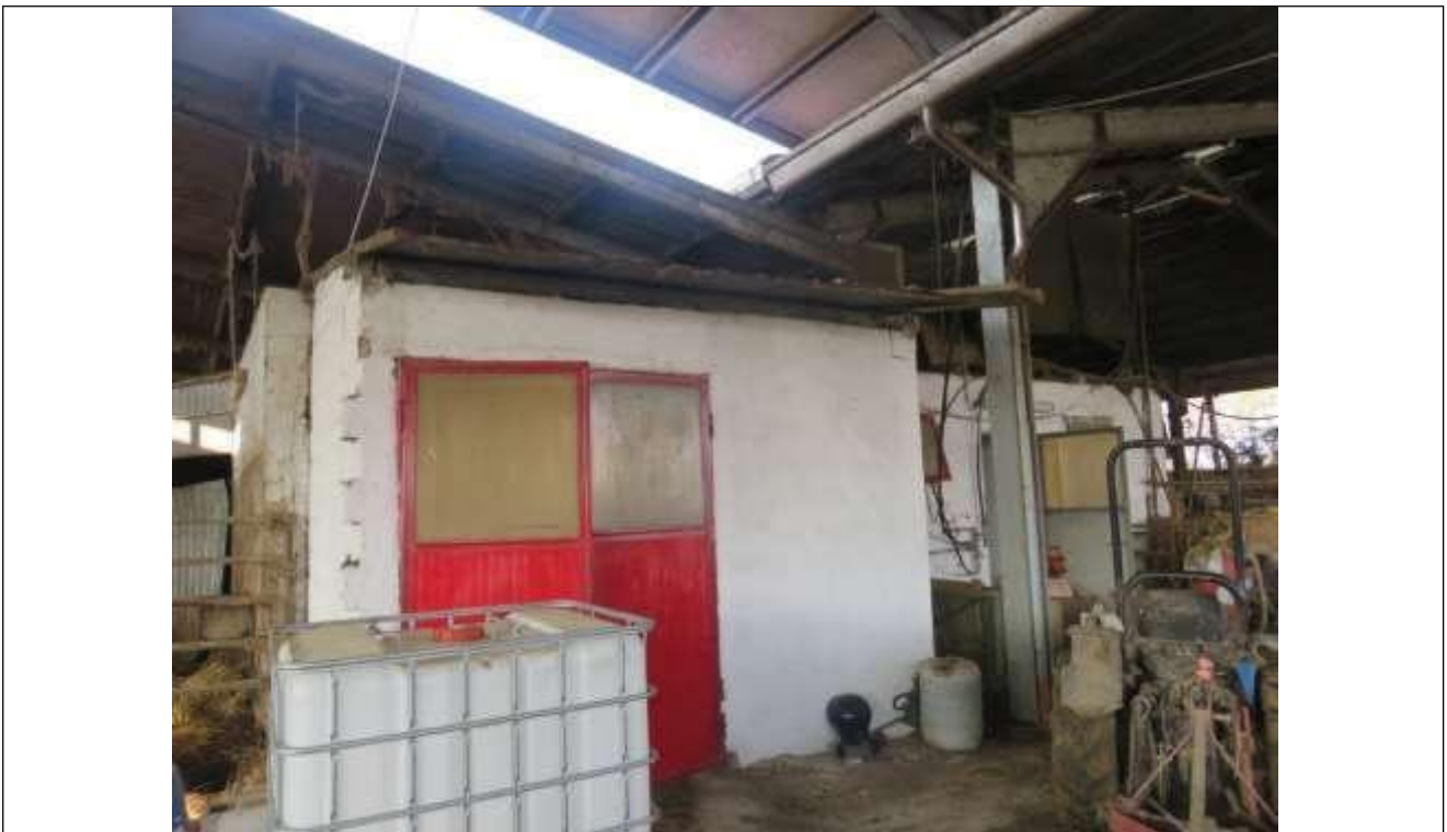
88 Vista dell'ingresso alla sala macchine;
