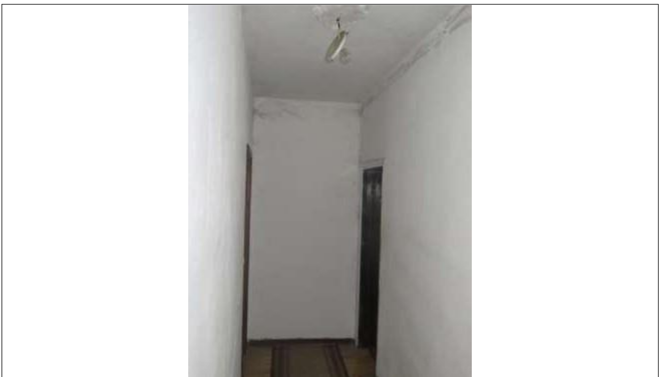
36 Vista del secondo disimpegno verso le due camere ad oggi non utilizzate e non ristrutturate;
