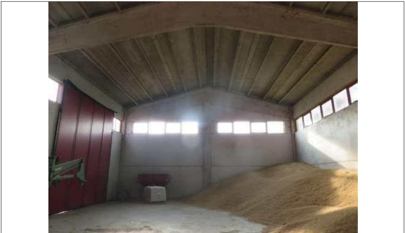
54 Vista interna dell'immobile 4;
