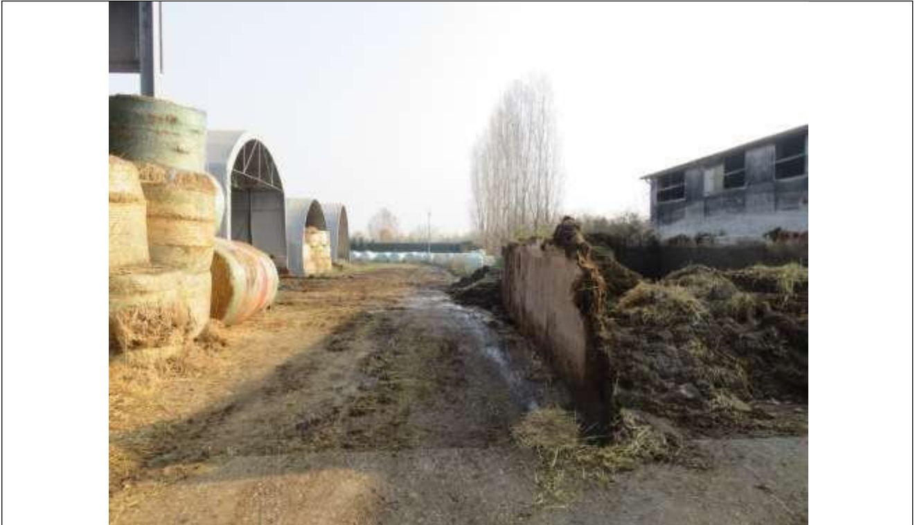
75 Particolare della concimaia, posta a confine della proprietà;
