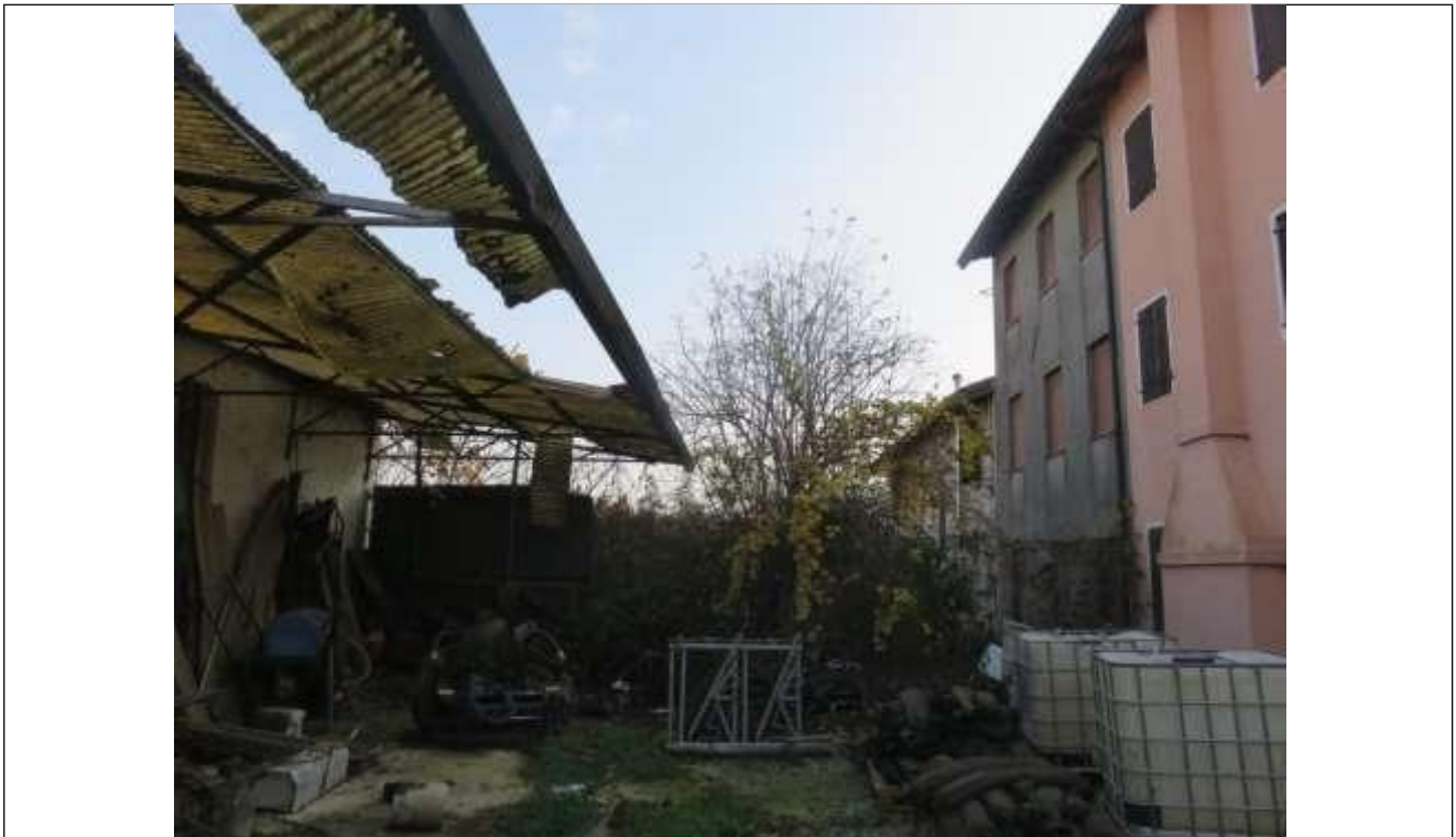
63 Vista del confine Est della proprietà esecutata, tra l'immobile 1 e l'immobile 5;
