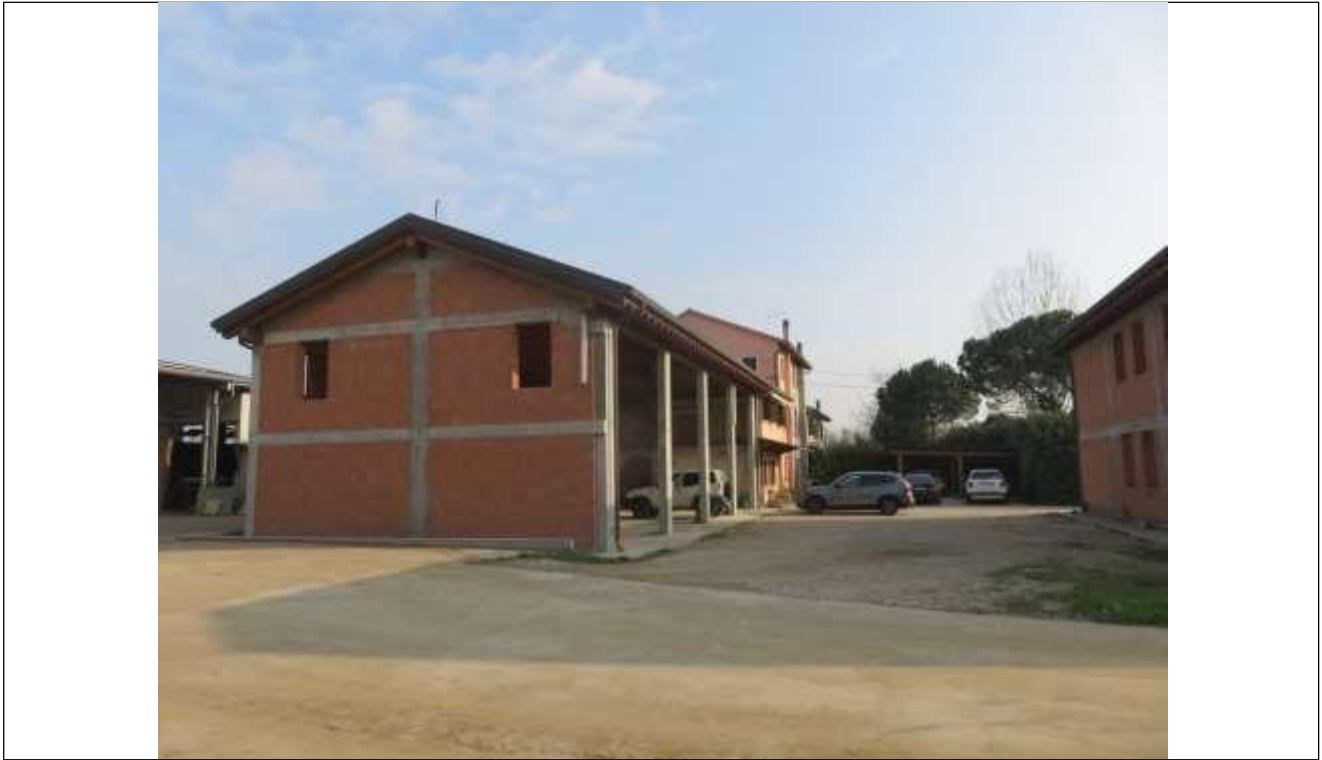
45 Vista della proprietà dalla corte esclusiva;
