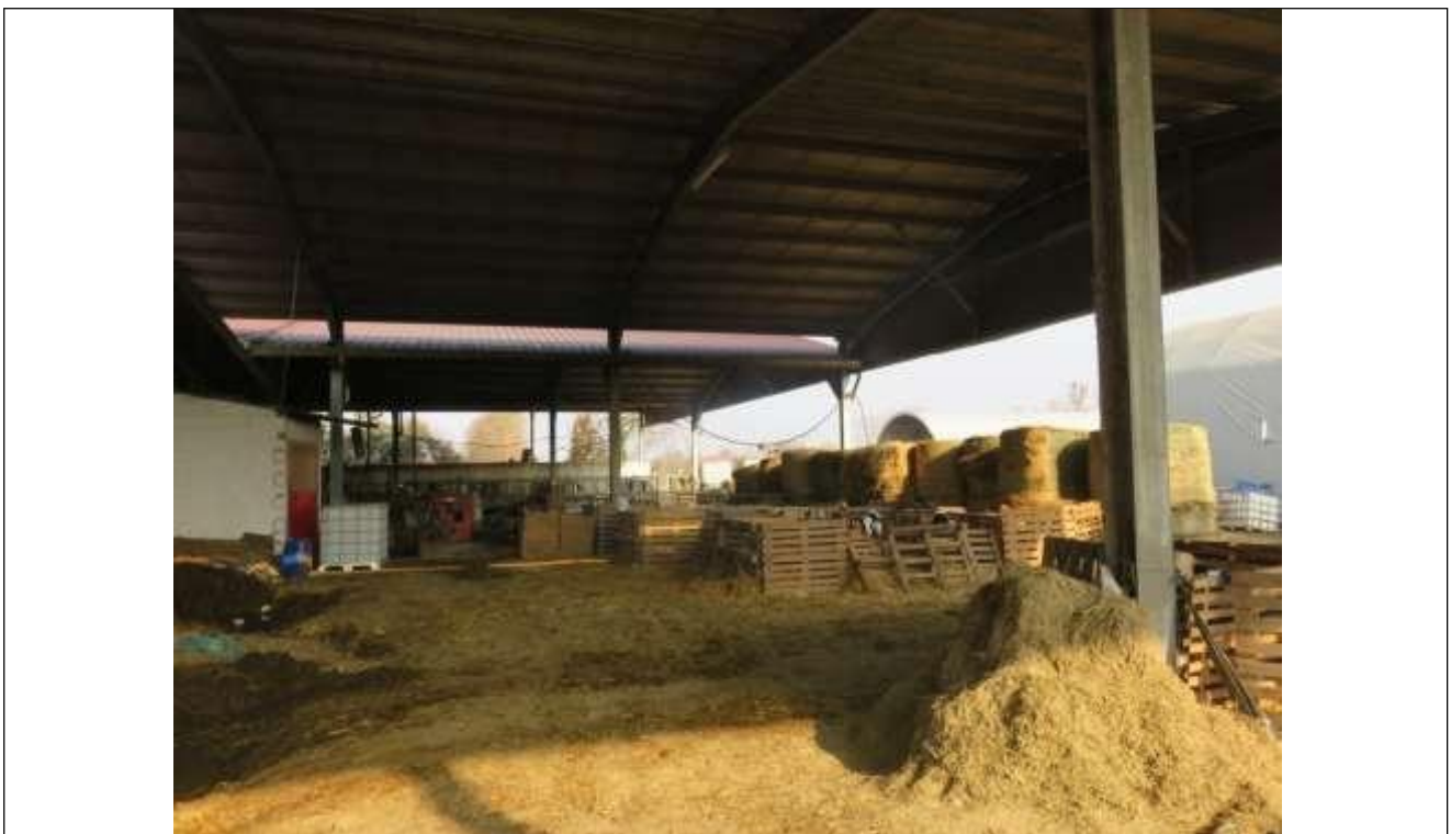
84 Vista della porzione in ampliamento dell'immobile 6, adibita a deposito foraggi e ricovero attrezzi;
