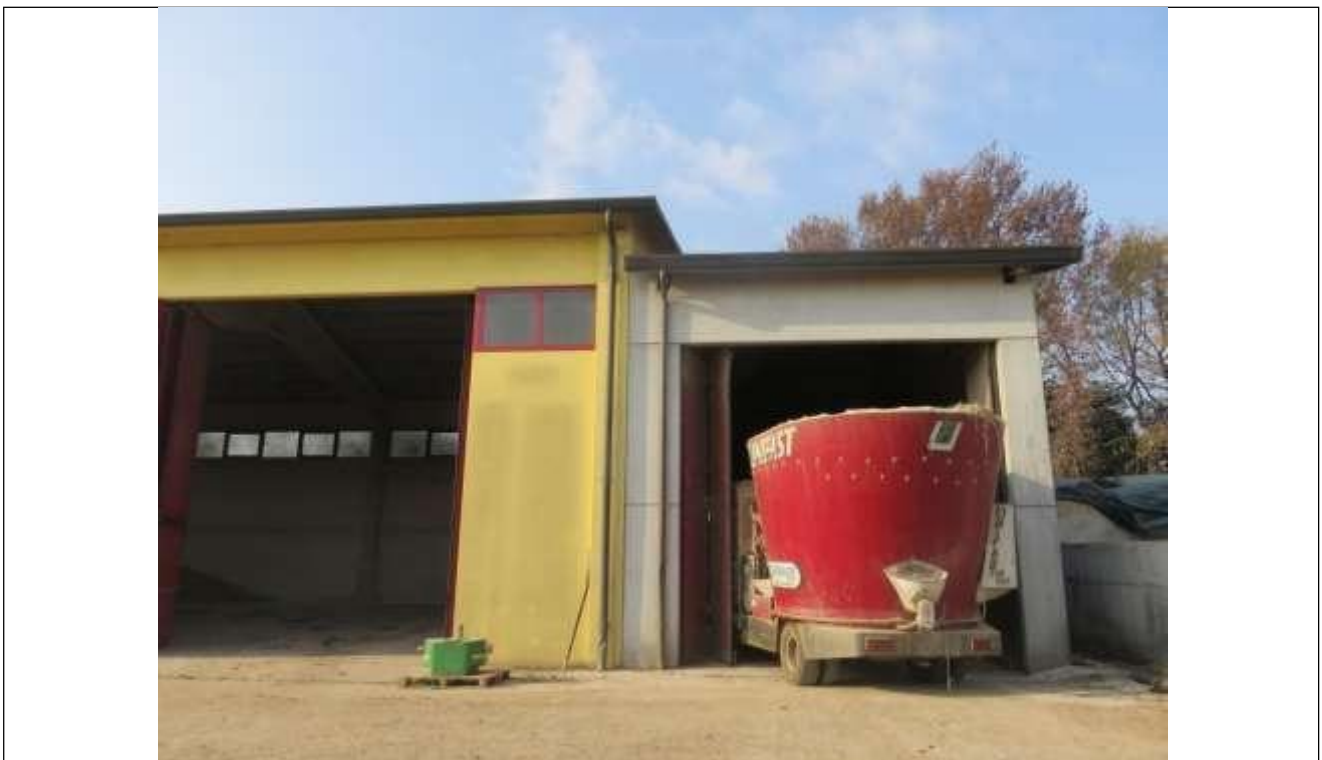
56 Vista di parte del deposito posto in aderenza all'ampliamento adibito a ricovero attrezzi;
