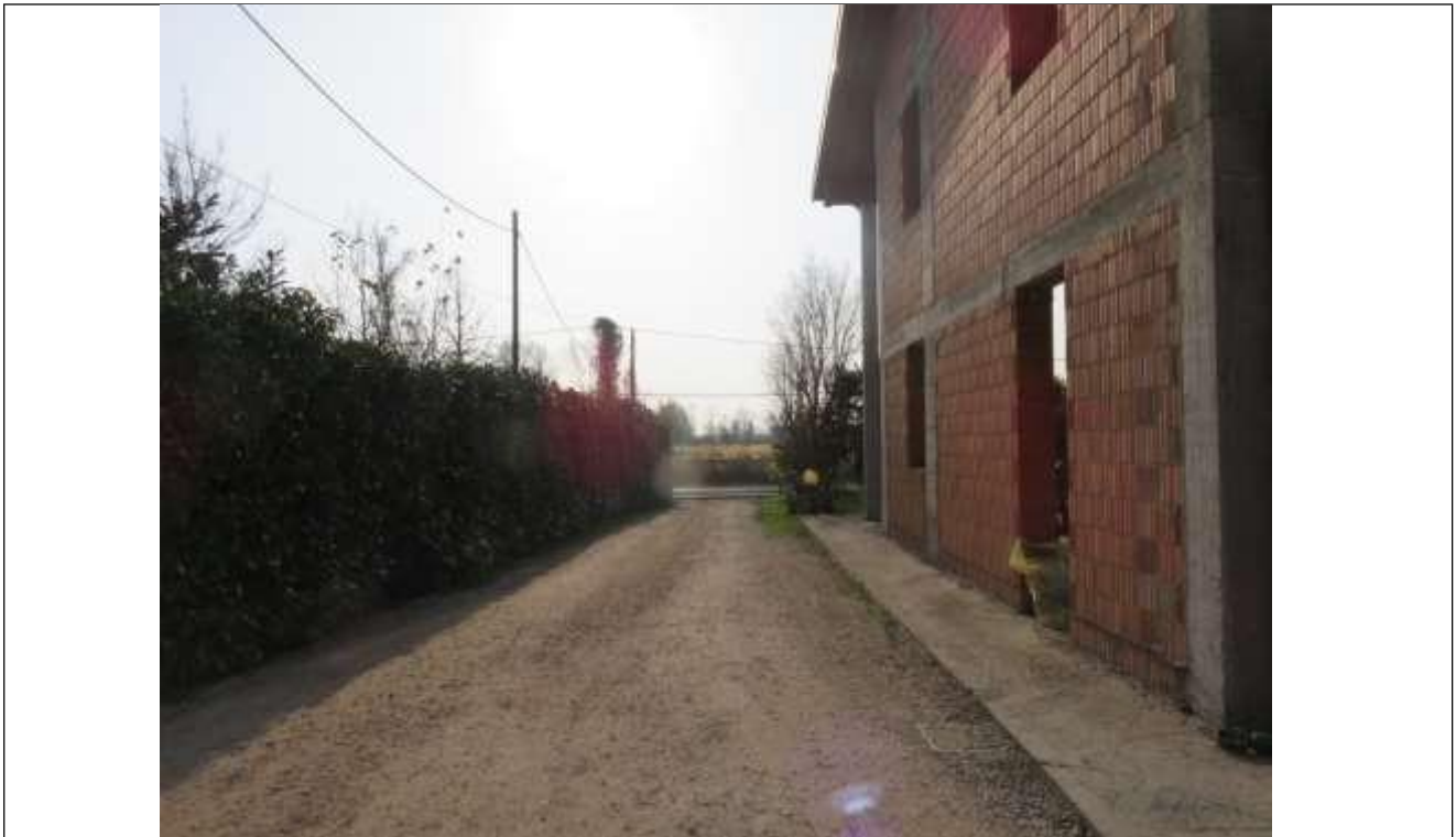
09 Vista dall'interno della proprietà verso il cancello d'ingresso;
