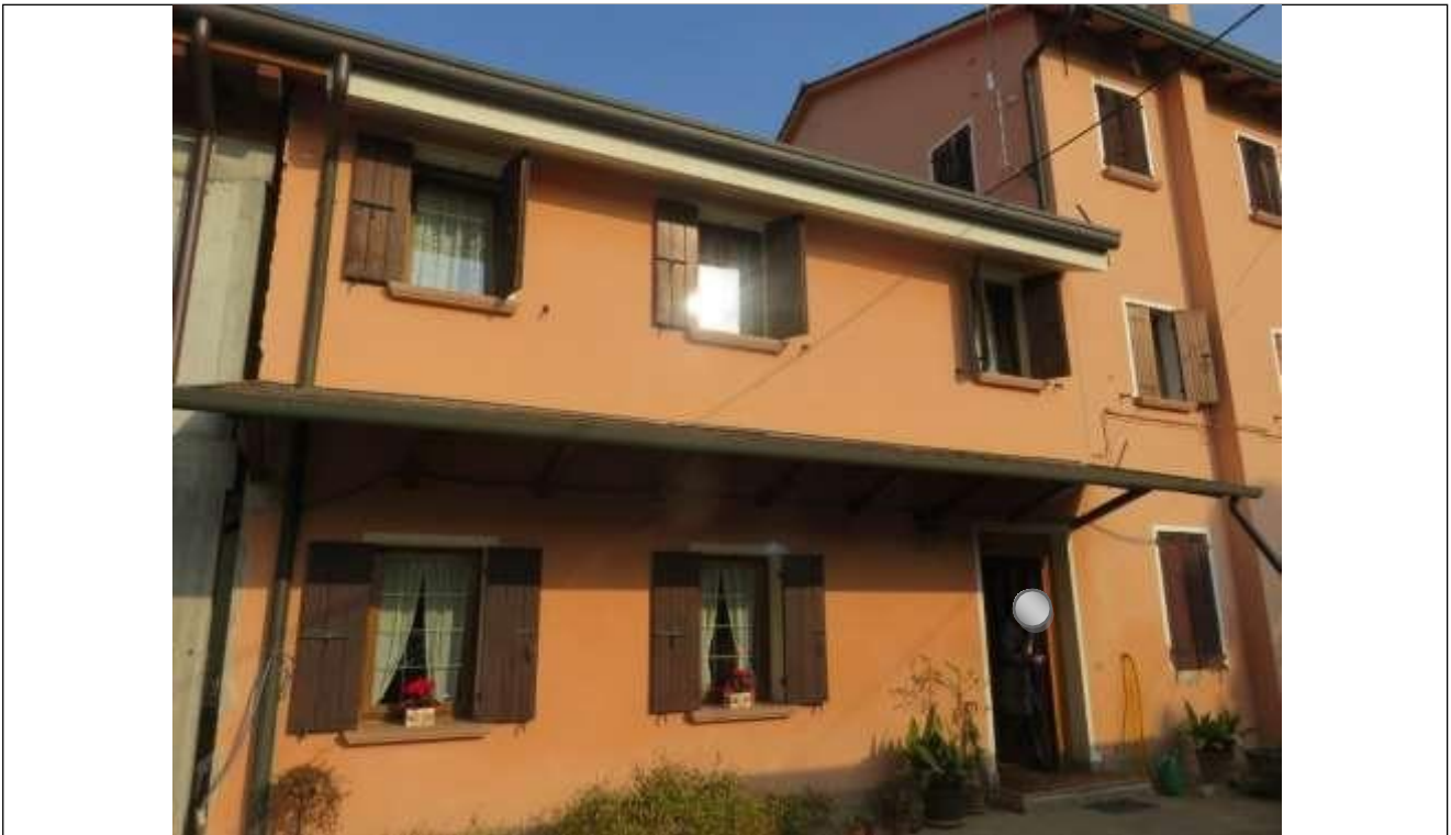
12 Vista del fronte sud dell'immobile residenziale;
