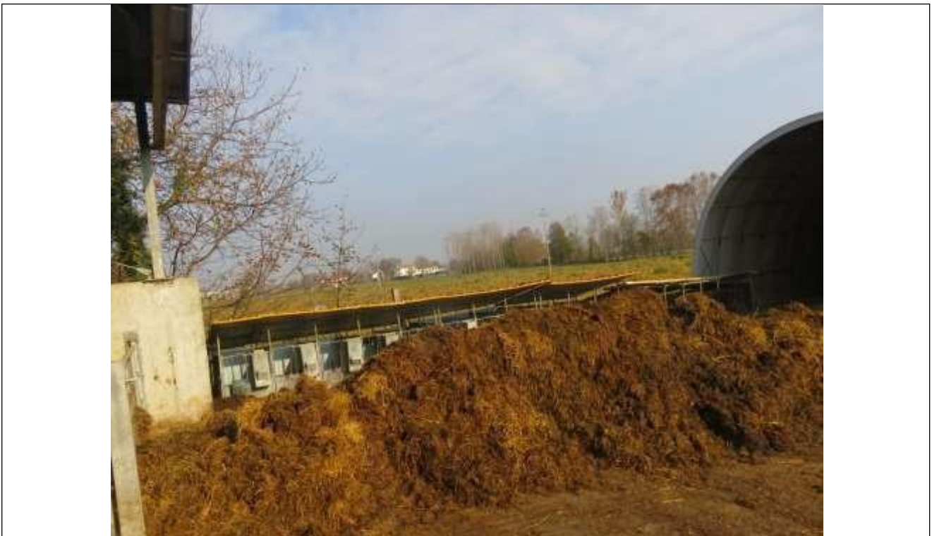
102 Vista di alcuni manufatti posti lungo il confine nord ed oggetto di demolizione.
