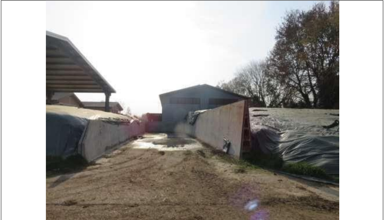
79 Vista della concimaia abusiva ed oggetto di demolizione;
