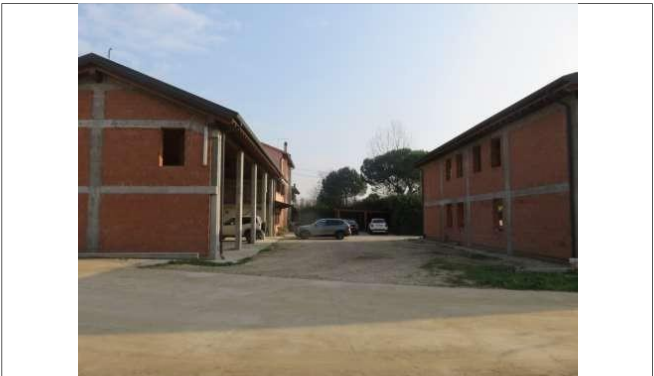
46 Vista dalla corte esclusiva: a sinistra l'immobile 2 e a destra l'immobile 3;
