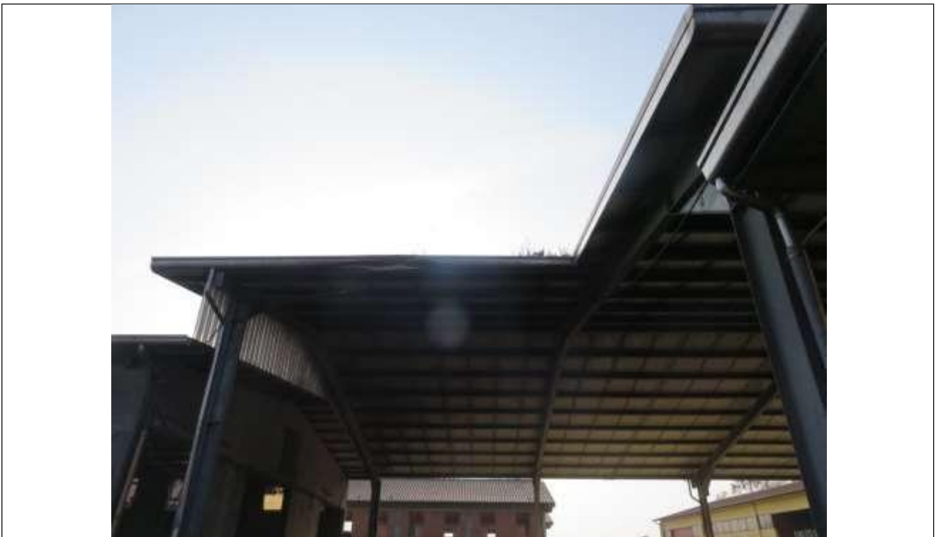
76 Vista lato Nord, della tettoia aperta (immobile 5);
