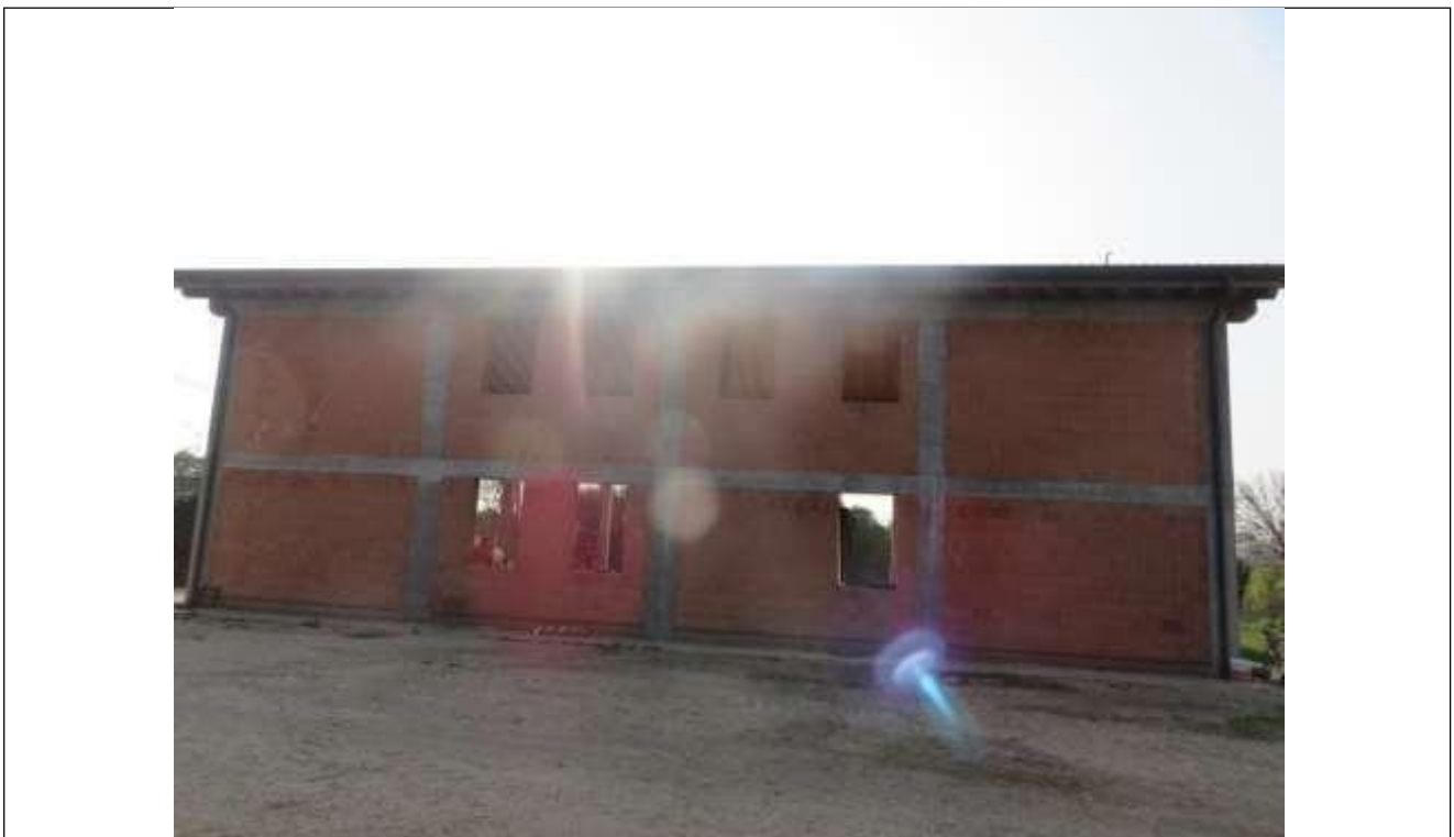
50 Vista del fronte Nord dell'immobile 3;
