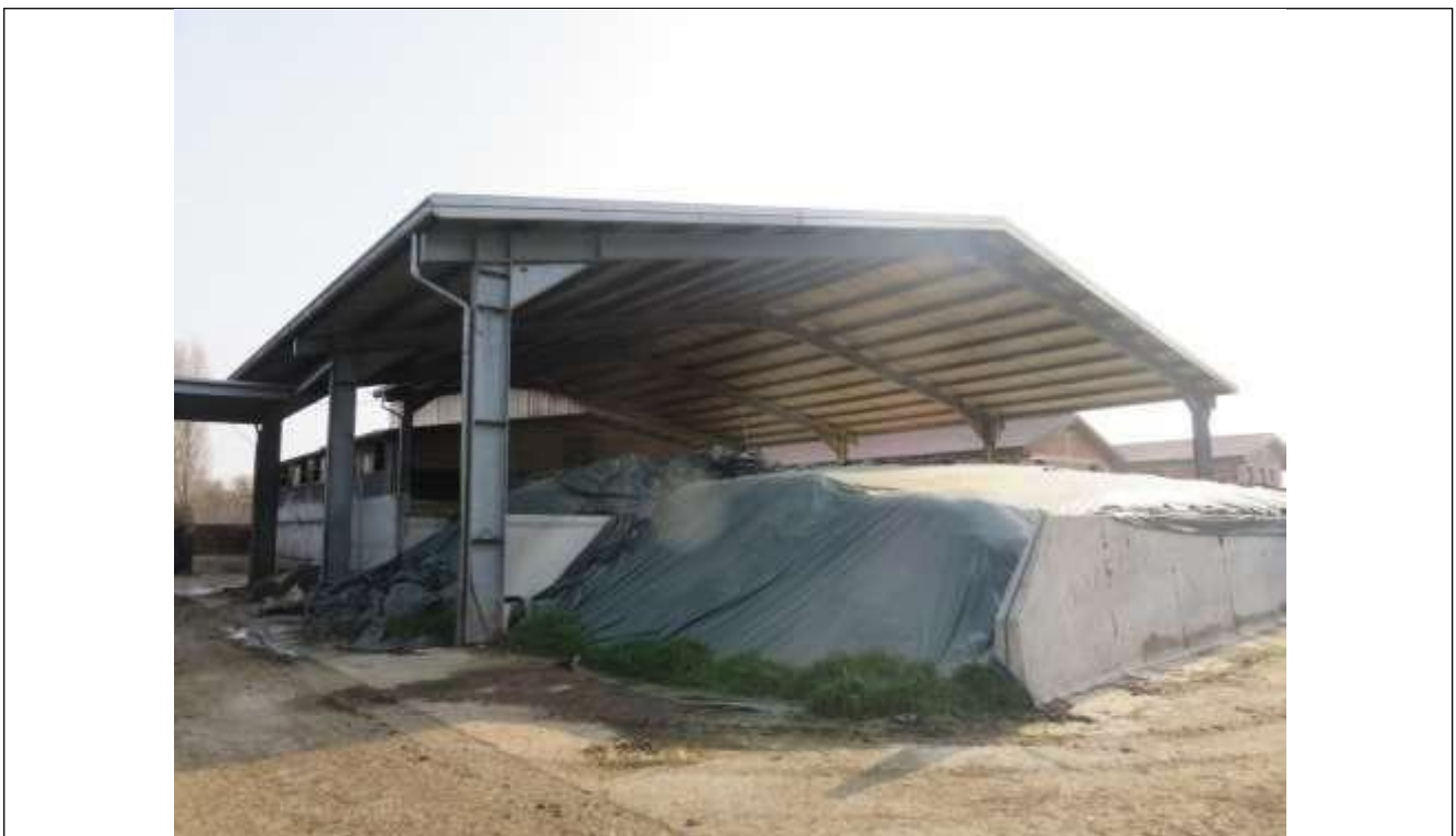
78 Vista dell'immobile 5; particolare della concimaia in parte autorizzata ed in parte oggetto di demolizione;
