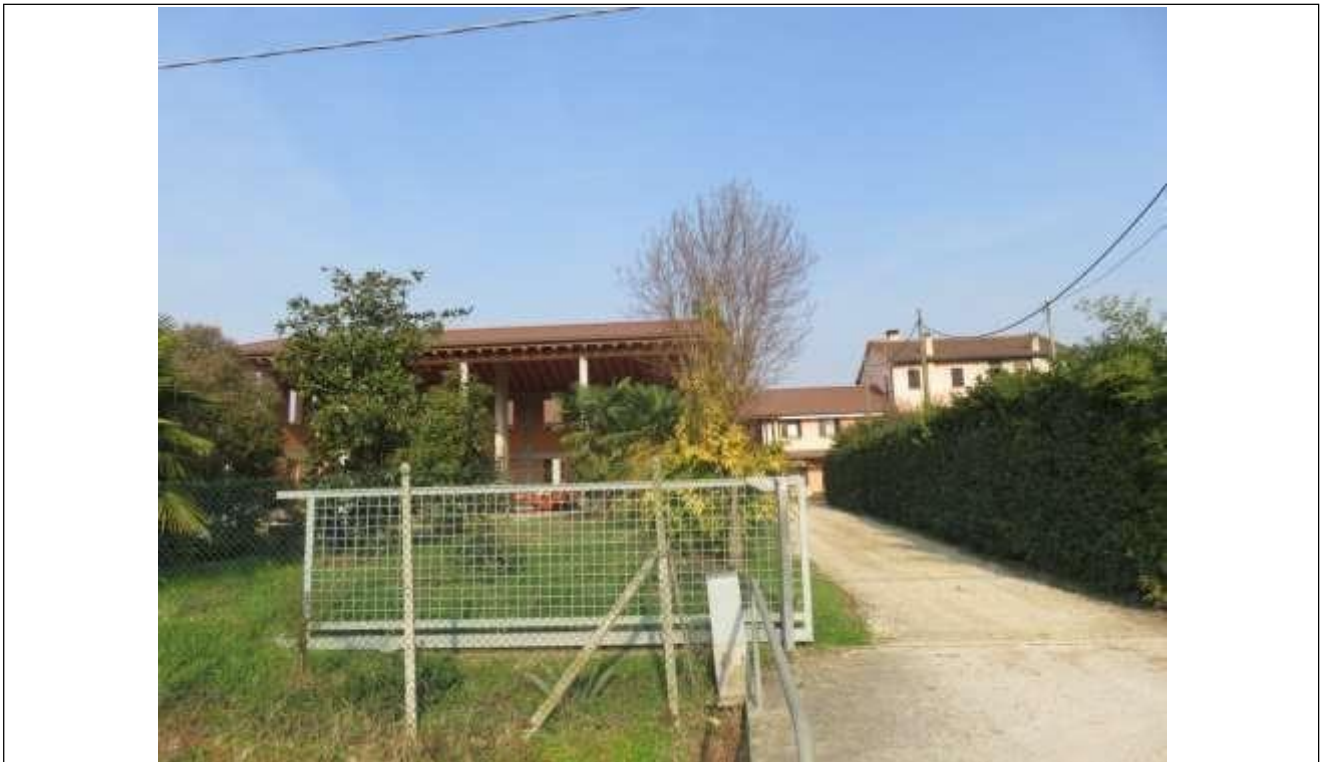
06 Vista dell'accesso carraio ad apertura automatizzata;
