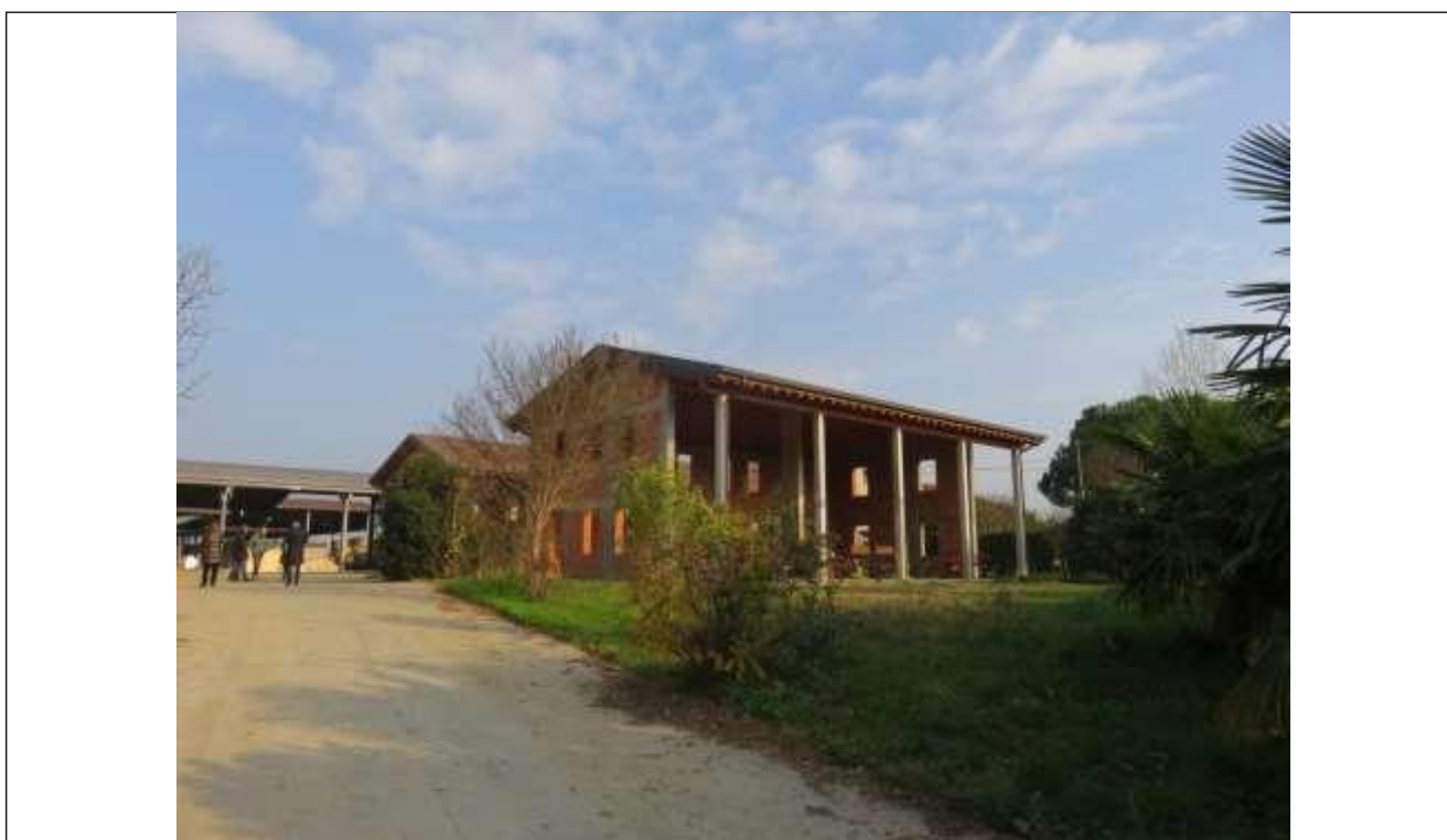
48 Vista dell'immobile 3, angolo Sud-Ovest;
