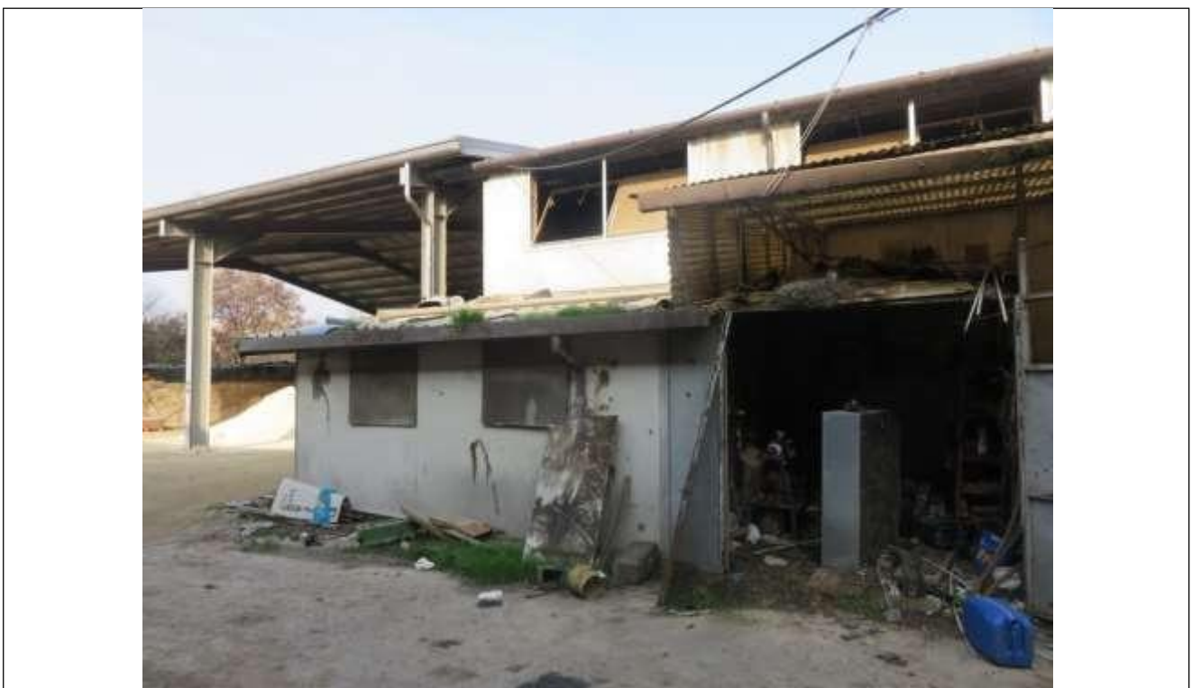
64 Particolare dei manufatti oggetto di demolizione, addossati a sud dell'immobile adibito a ricovero attrezzi e attualmente adibito a stalla;
