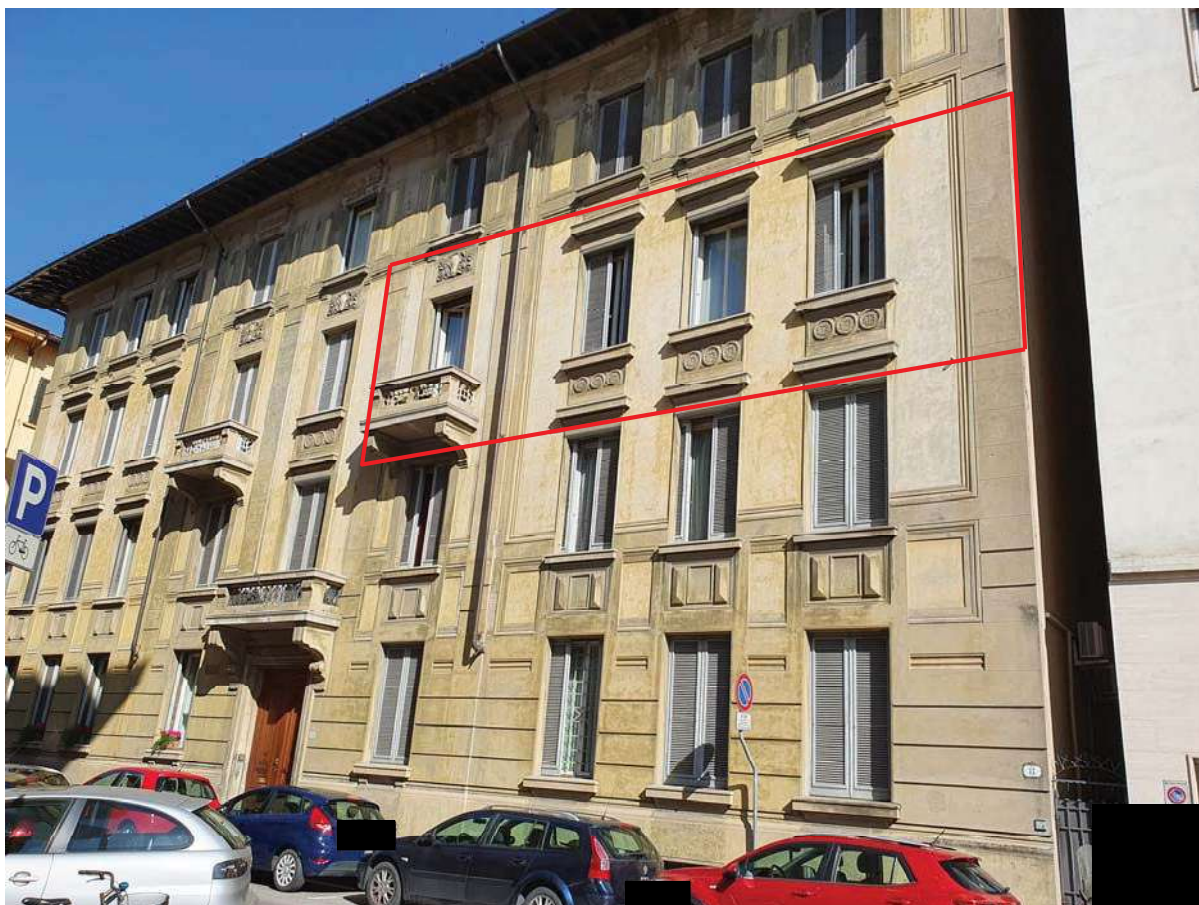
Foto 02 – Vista da Via J. Nardi del condominio di cui fa parte il bene oggetto di perizia
