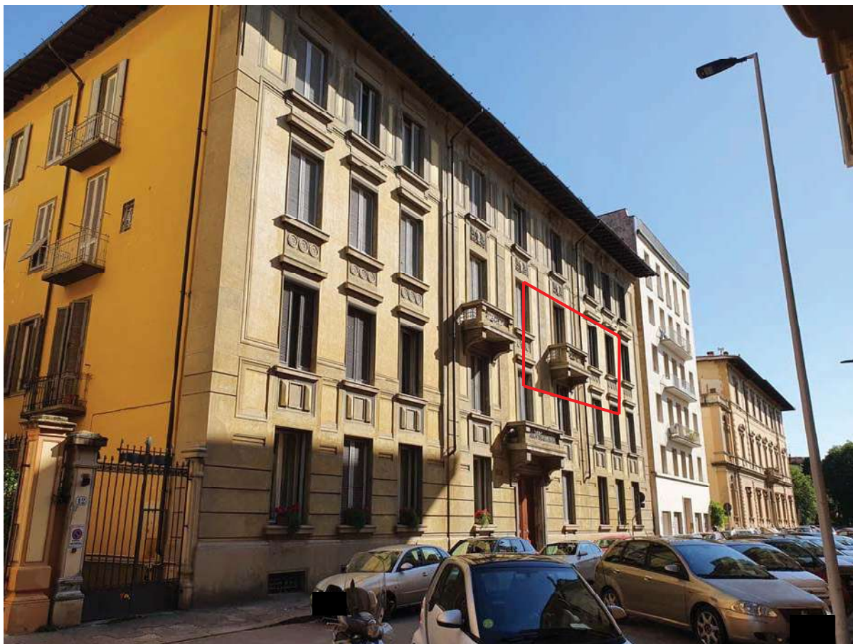
Foto 01 – Vista da Via J. Nardi del condominio di cui fa parte il bene oggetto di perizia
