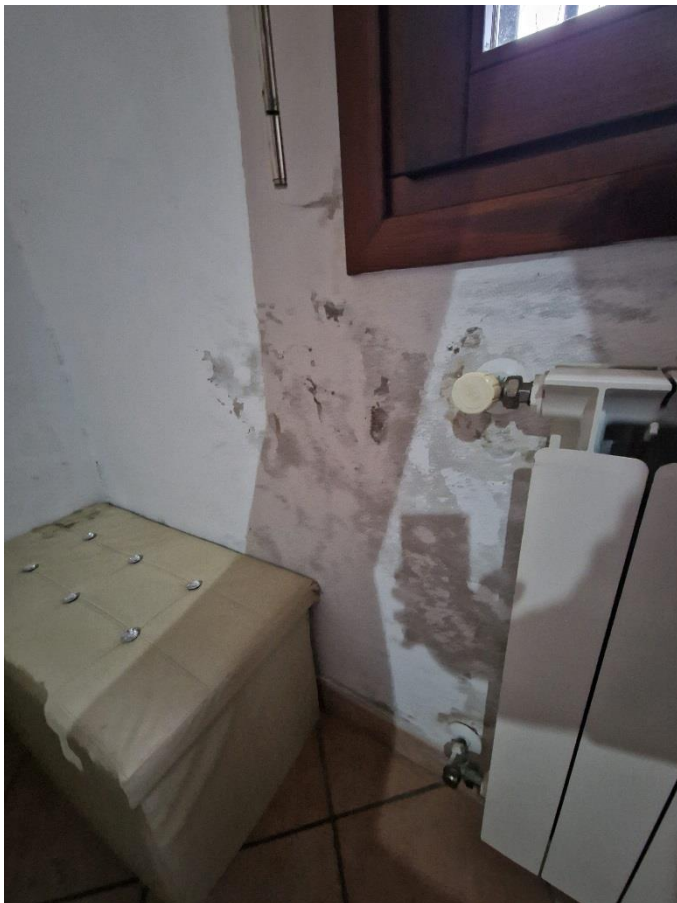
Foto 11- Finestra camera matrimoniale su resede esterna
