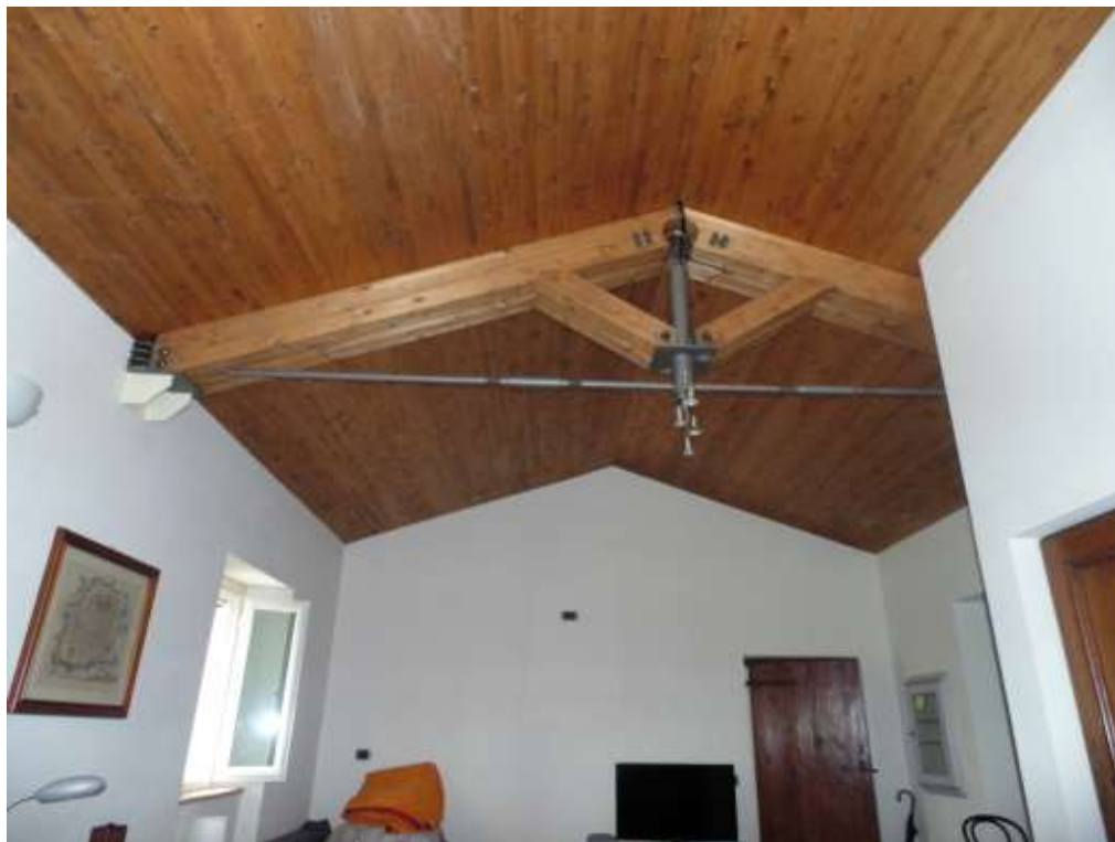
Foto n° 76 Interno Piano Primo - vista copertura lignea vano ingresso
