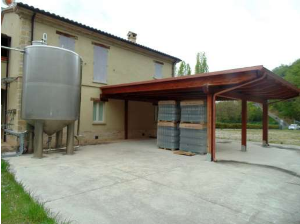
Foto n° 30 Esterno - vista prospetto Sud - Est
