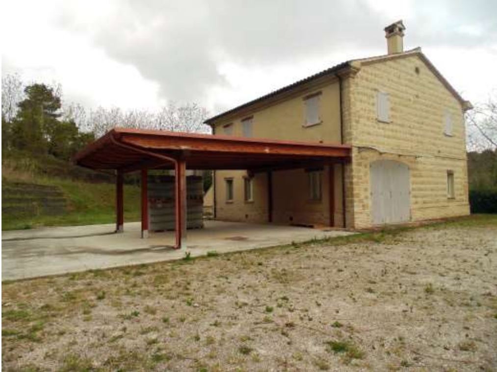
Foto n° 27 Esterno - vista prospetti Nord - Est e Sud - Est
