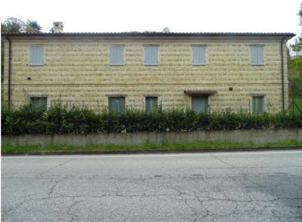
Foto n° 18 Esterno - vista prospetto Nord - Ovest
