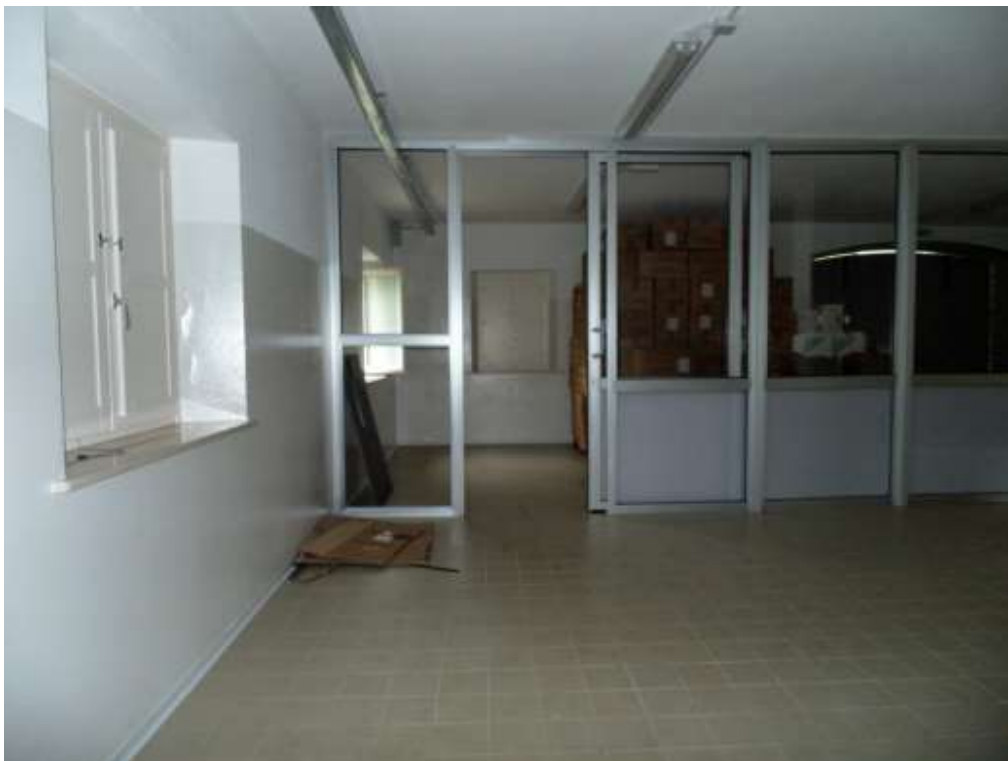
Foto n° 54 Interno Piano Terra - vista laboratorio
