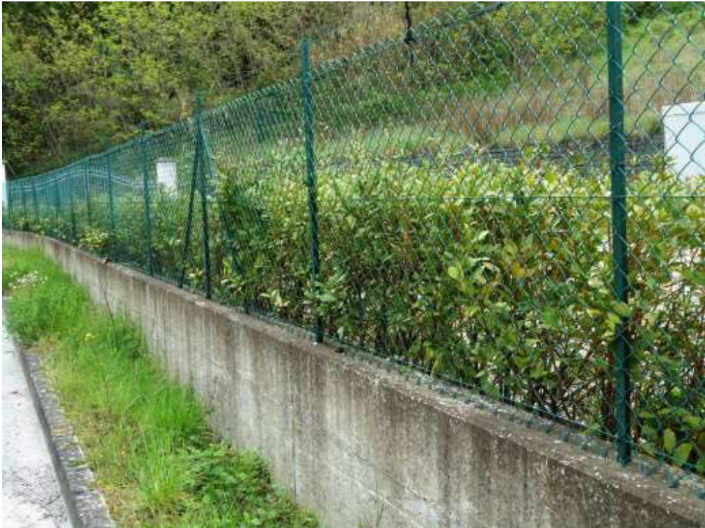
Foto n° 17 Esterno - vista particolare recinzione lato SP 32
