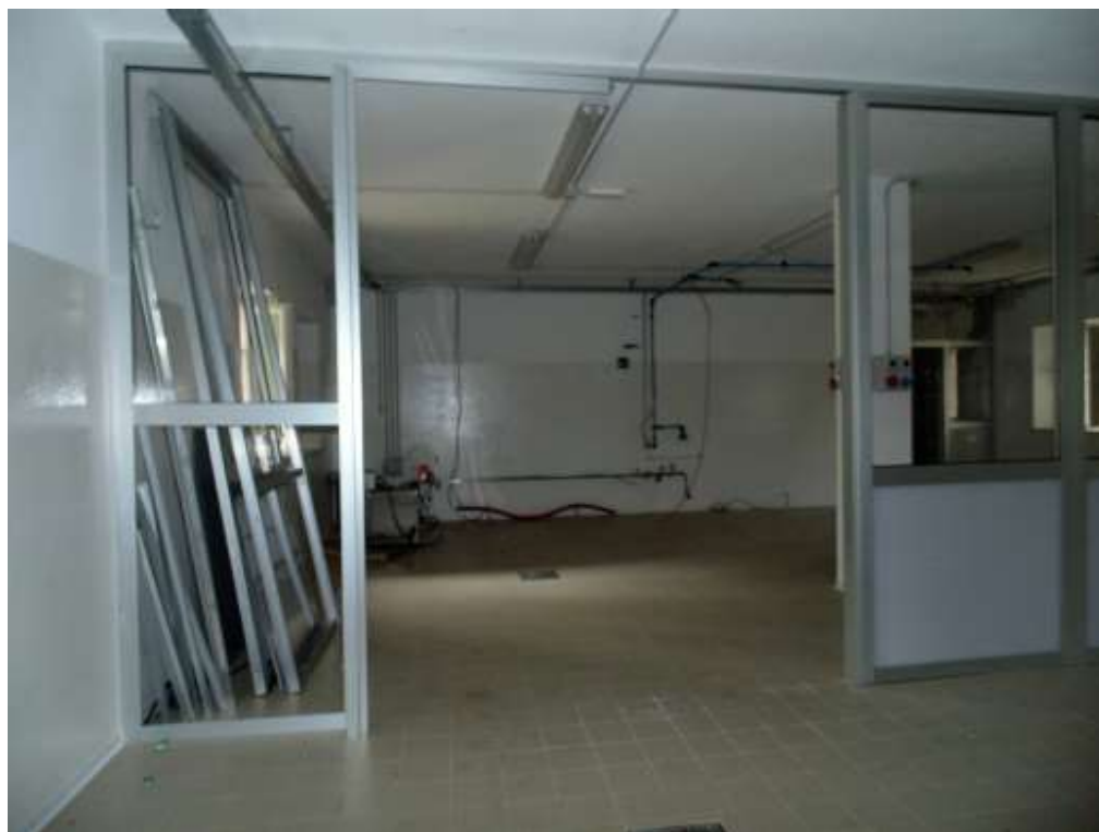
Foto n° 52 Interno Piano Terra - vista laboratorio
