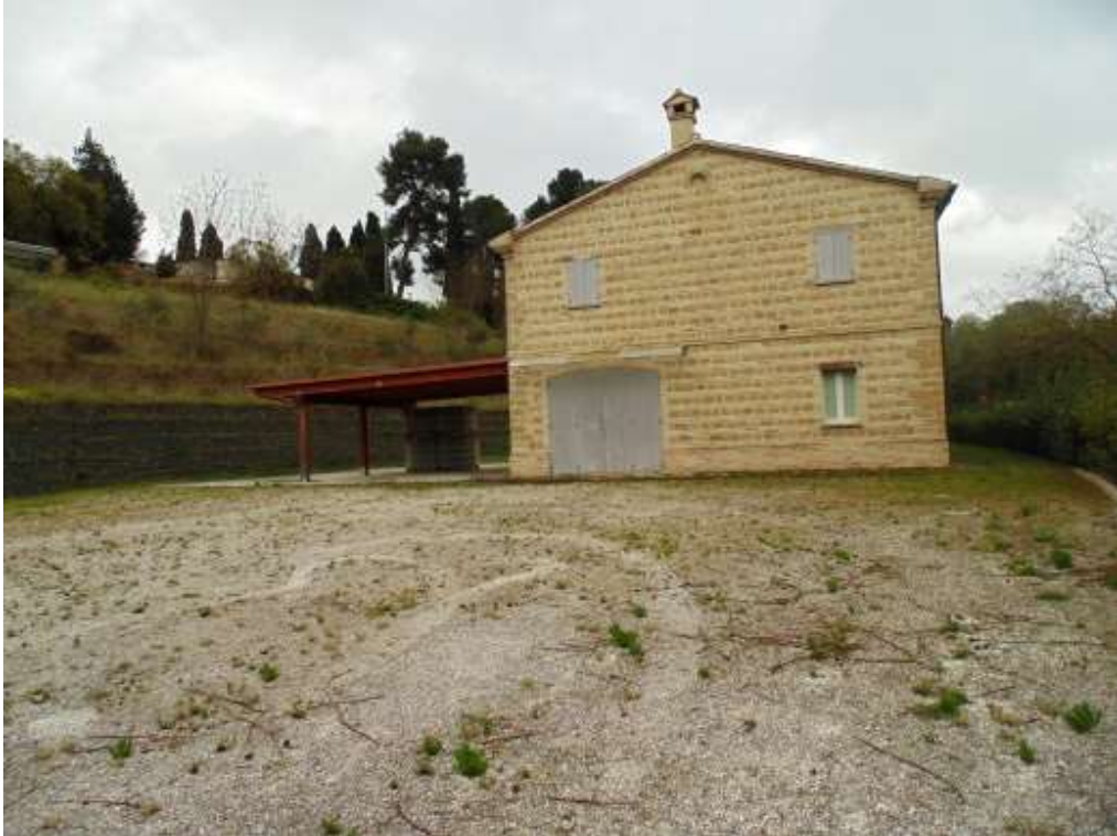
Foto n° 25 Esterno - vista prospetto Nord - Est
