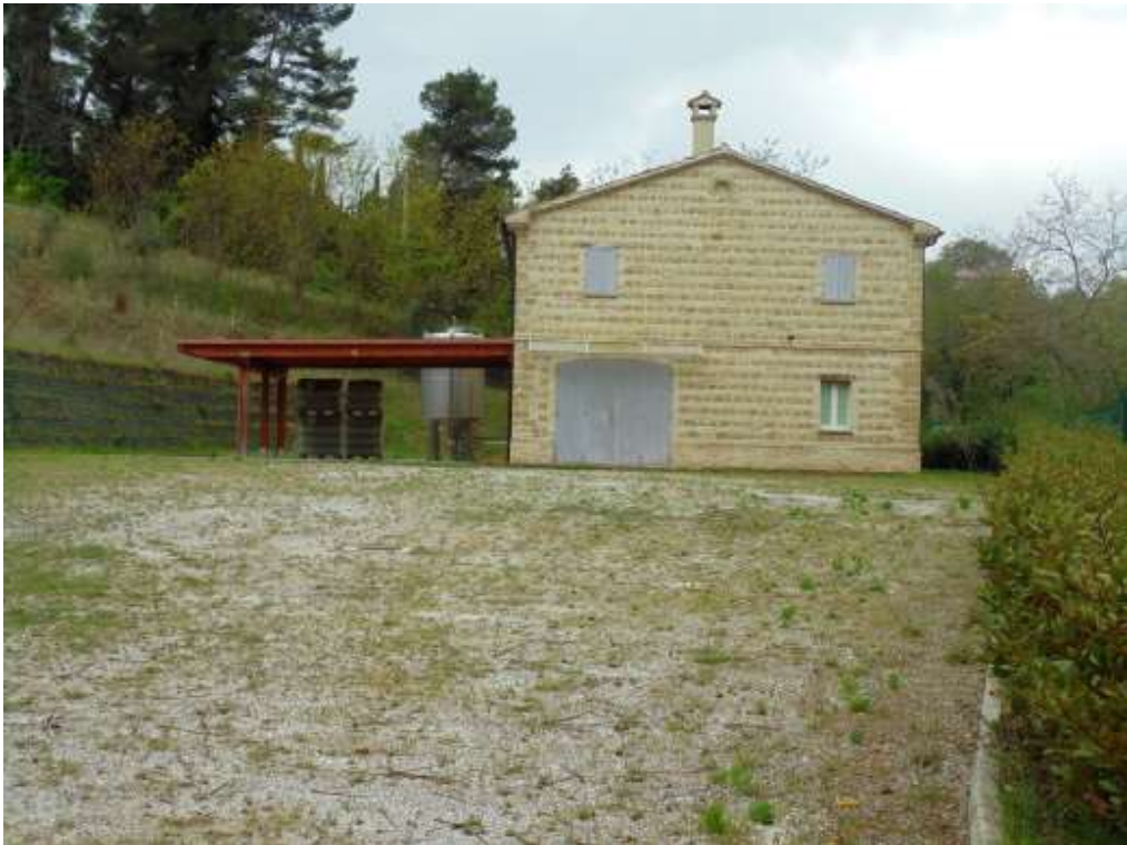
Foto n° 10 Esterno - vista prospetto Nord - Est
