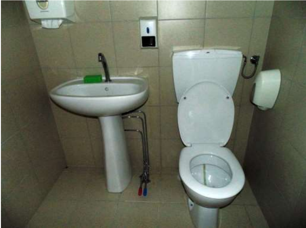
Foto n° 38 Interno Piano Terra - vista WC laboratorio analisi
