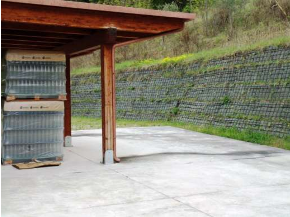
Foto n° 29 Esterno - vista del sistema di contenimento della scarpata
