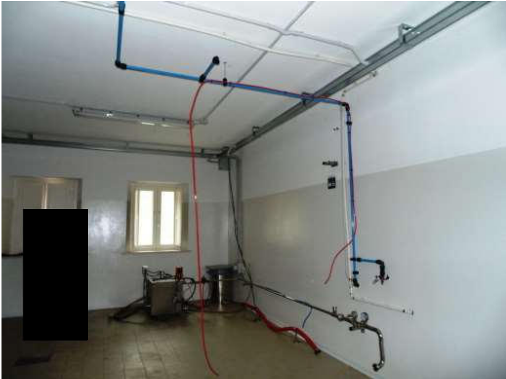
Foto n° 49 Interno Piano Terra - vista laboratorio
