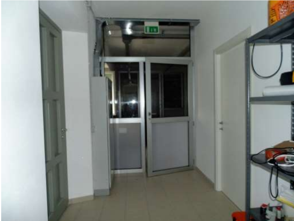
Foto n° 40 Interno Piano Terra - vista zona ingresso principale
