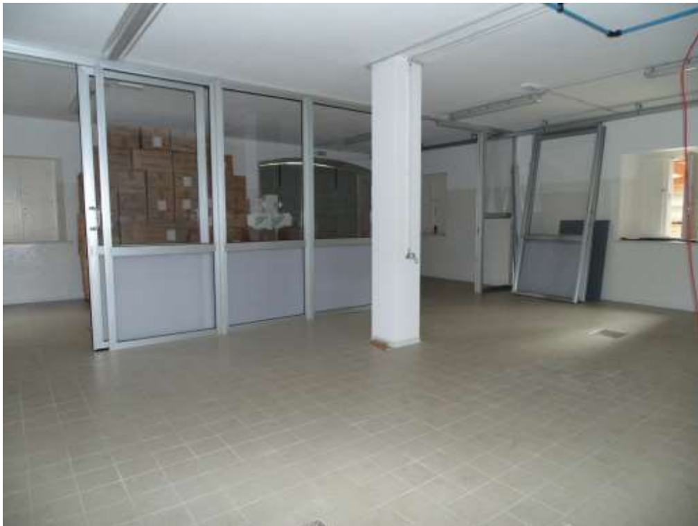
Foto n° 55 Interno Piano Terra - vista laboratorio
