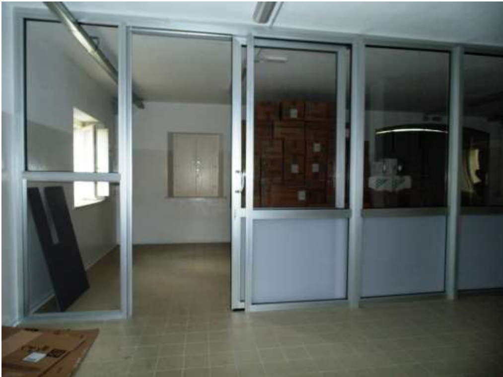
Foto n° 48 Interno Piano Terra - vista laboratorio
