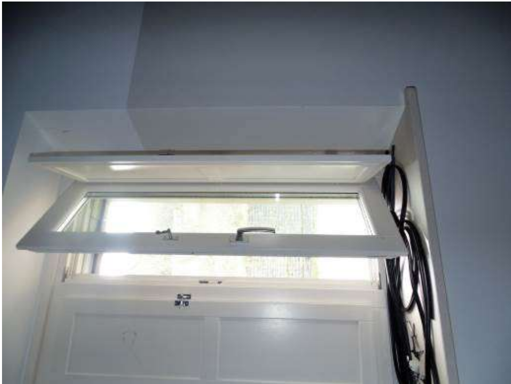
Foto n° 60 Interno Piano Terra - vista particolare infisso
