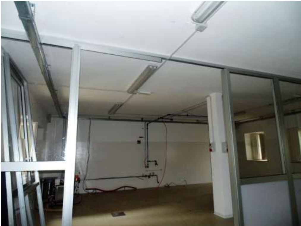
Foto n° 50 Interno Piano Terra - vista laboratorio
