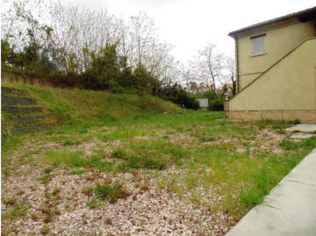
Foto n° 28 Esterno - vista area di pertinenza dell'unità immobiliare e del sistema di contenimento della scarpata
