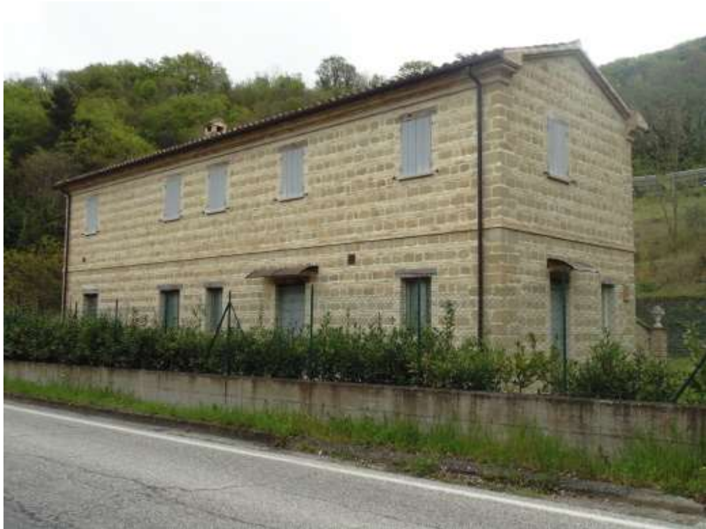
Foto n° 13 Esterno - vista prospetti Nord - Ovest e Sud - Ovest
