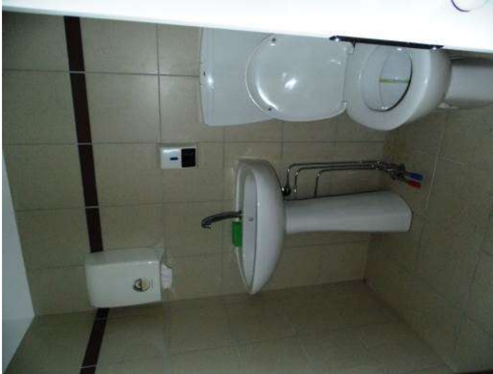
Foto n° 39 Interno Piano Terra - vista WC laboratorio analisi
