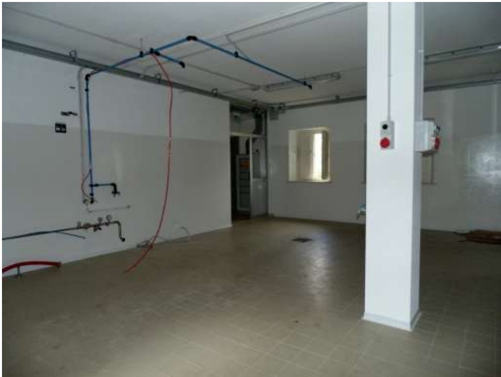
Foto n° 53 Interno Piano Terra - vista laboratorio
