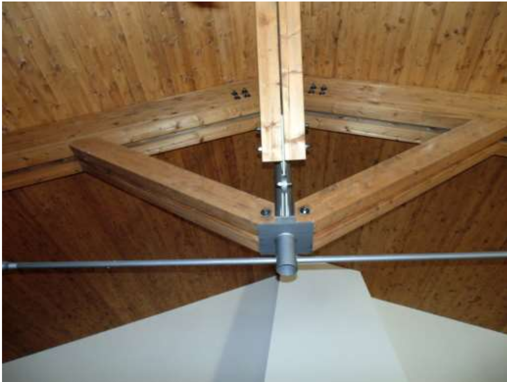
Foto n° 70 Interno Piano Primo - vista particolare copertura lignea dell'ampio ambiente uffici
