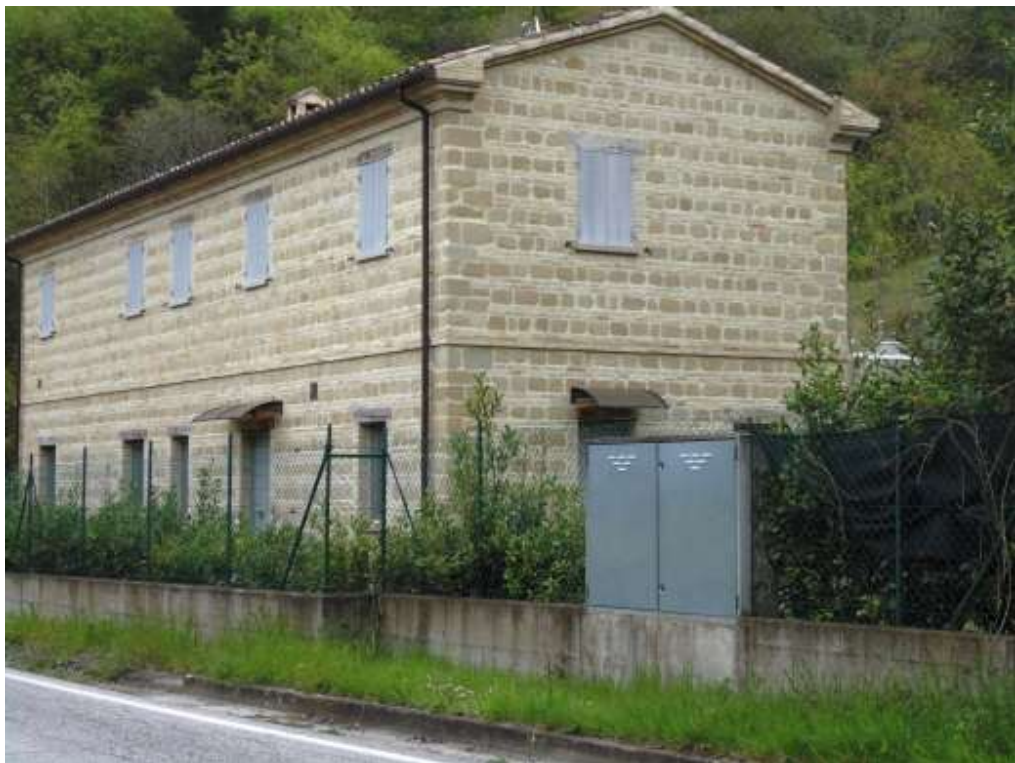
Foto n° 14 Esterno - vista prospetti Nord - Ovest e Sud - Ovest
