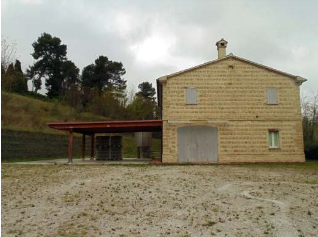
Foto n° 26 Esterno - vista prospetto Nord - Est
