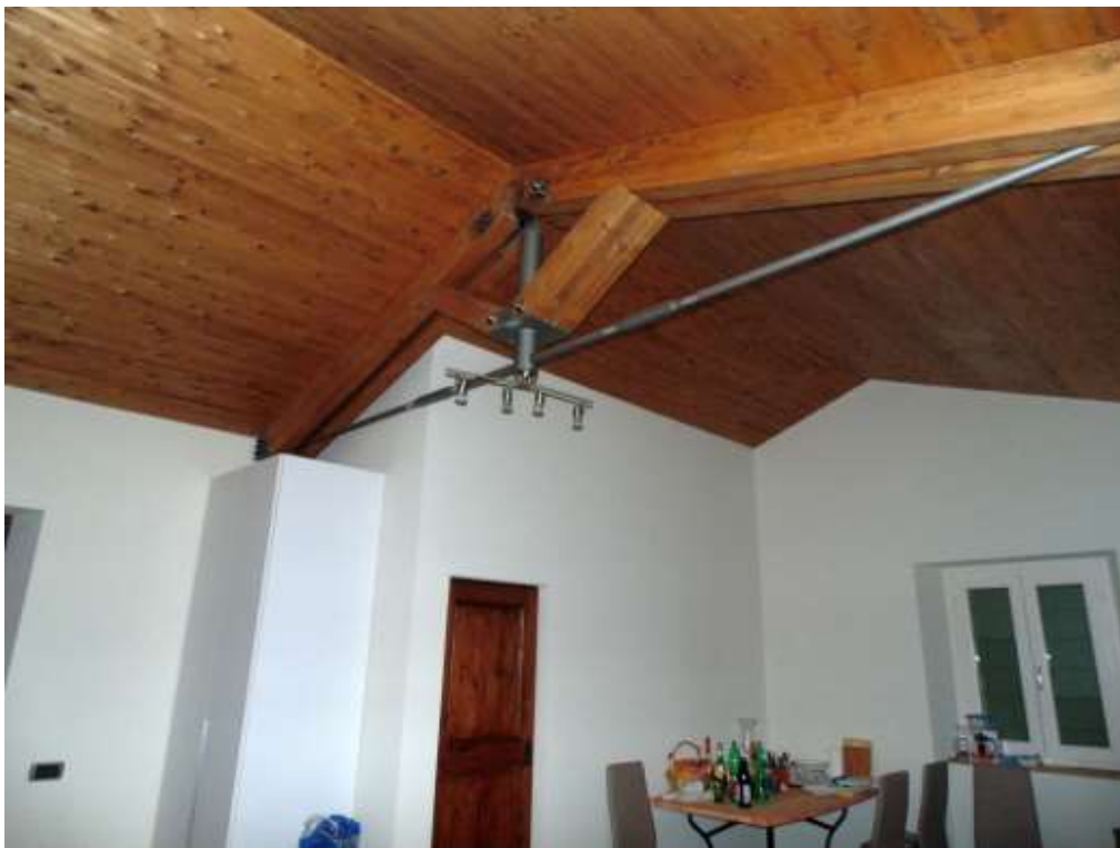
Foto n° 78 Interno Piano Primo - vista ufficio a ridosso del vano ingresso
