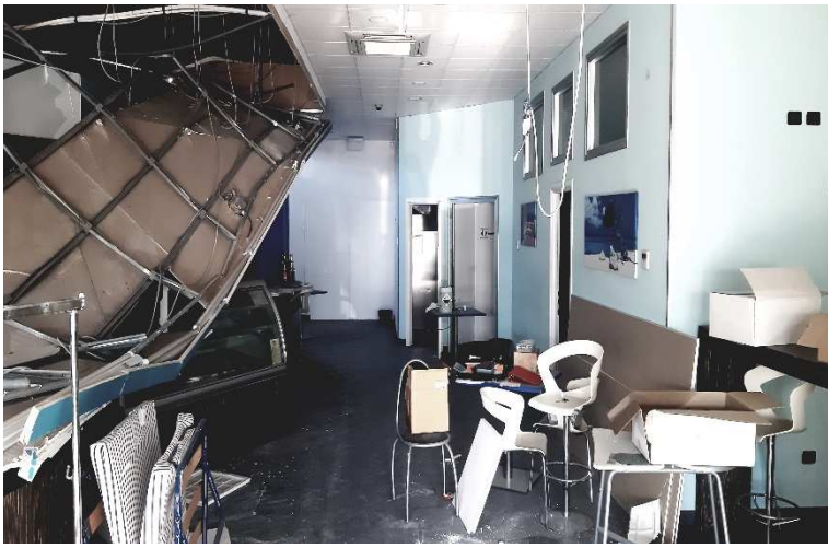
Parte della controsoffittatura ceduta
