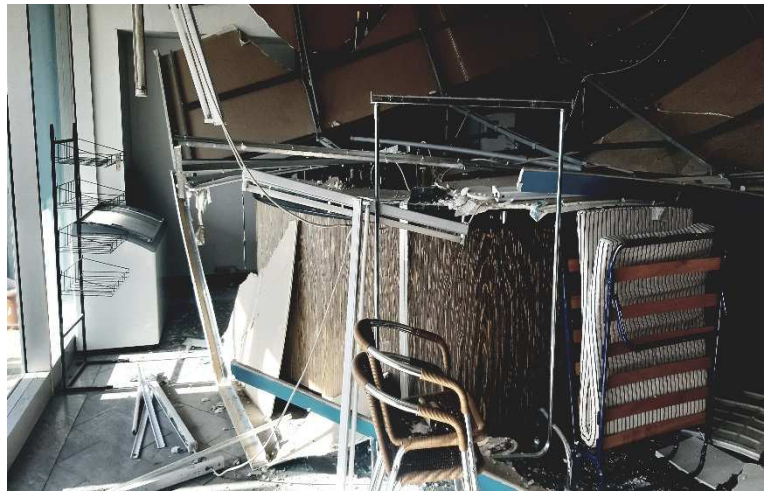
Parte della controsoffittatura ceduta
