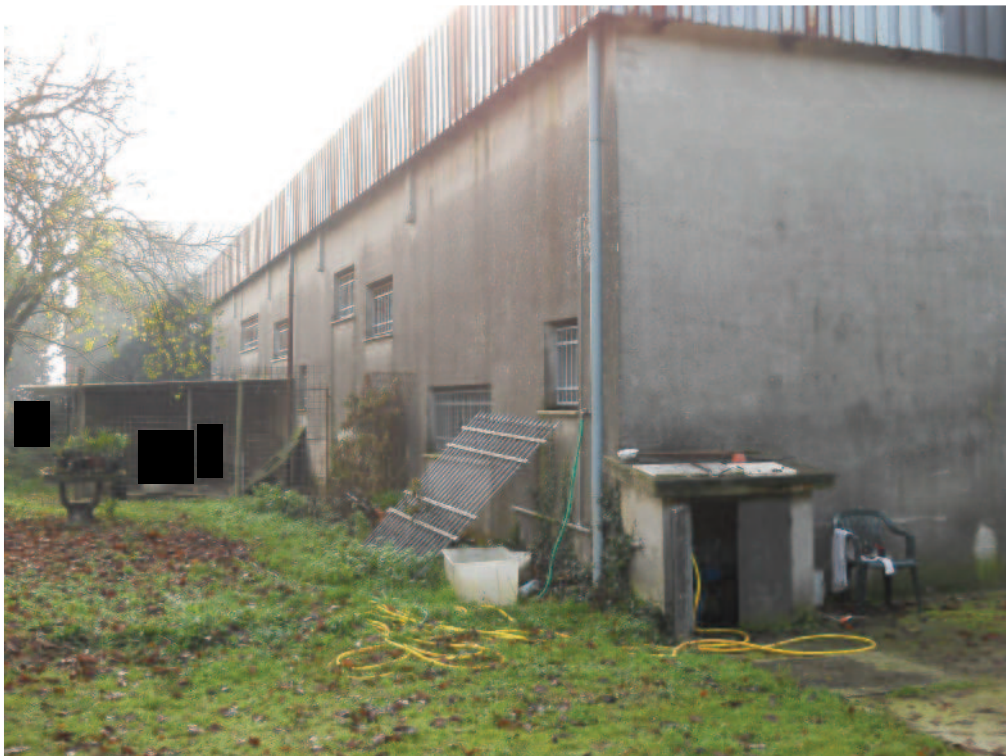
FOTOGRAFIA N.16 - particolare prospetto capannone
