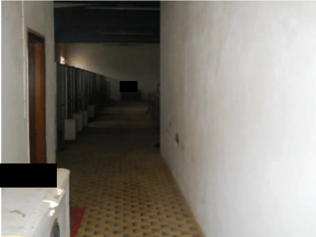
FOTOGRAFIA N.17 - particolare interno capannone
