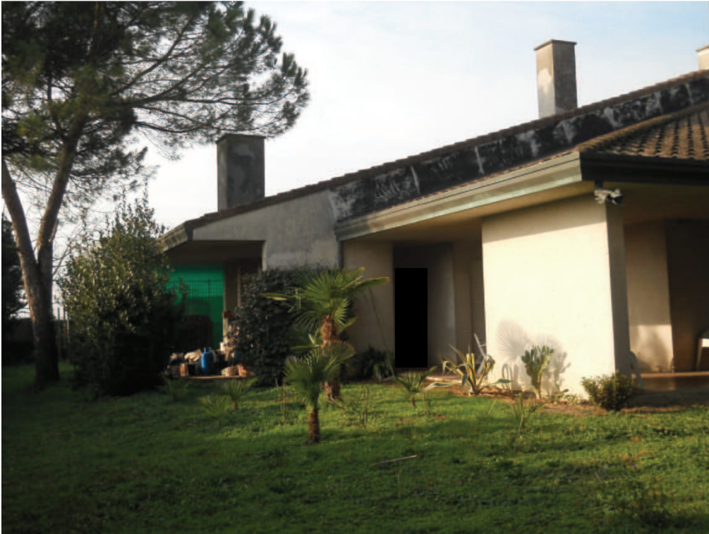
FOTOGRAFIA N.5 - particolare prospetto fabbricato residenziale
