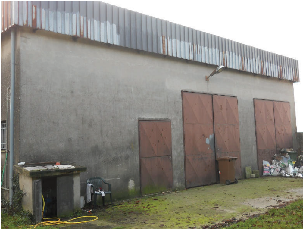
FOTOGRAFIA N.15 - particolare prospetto capannone
