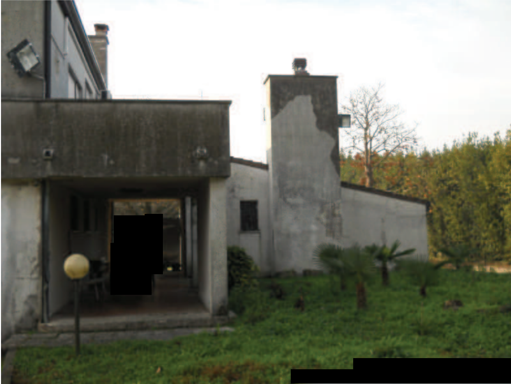
FOTOGRAFIA N.13 - particolare prospetto accessorio esterno
