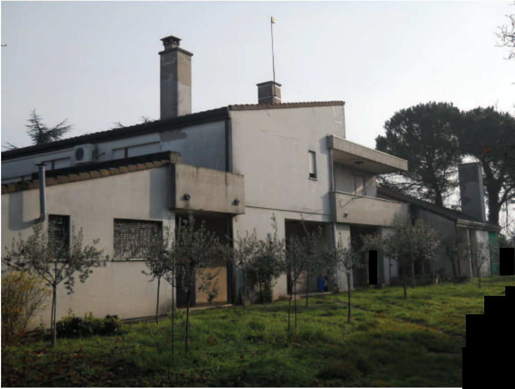
FOTOGRAFIA N.3 - particolare prospetto fabbricato residenziale
