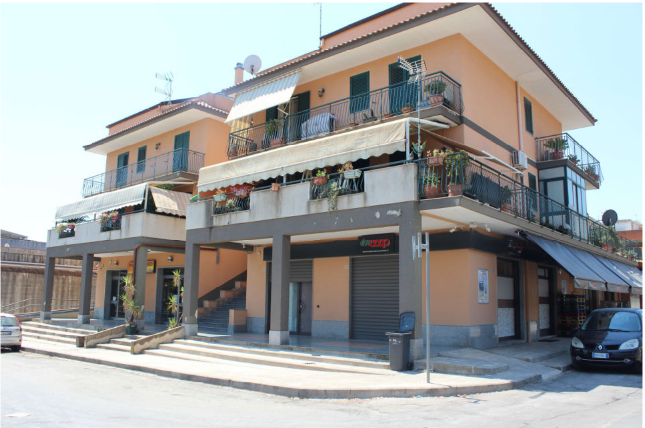
Foto n. 2 – Vista fabbricato in condominio
