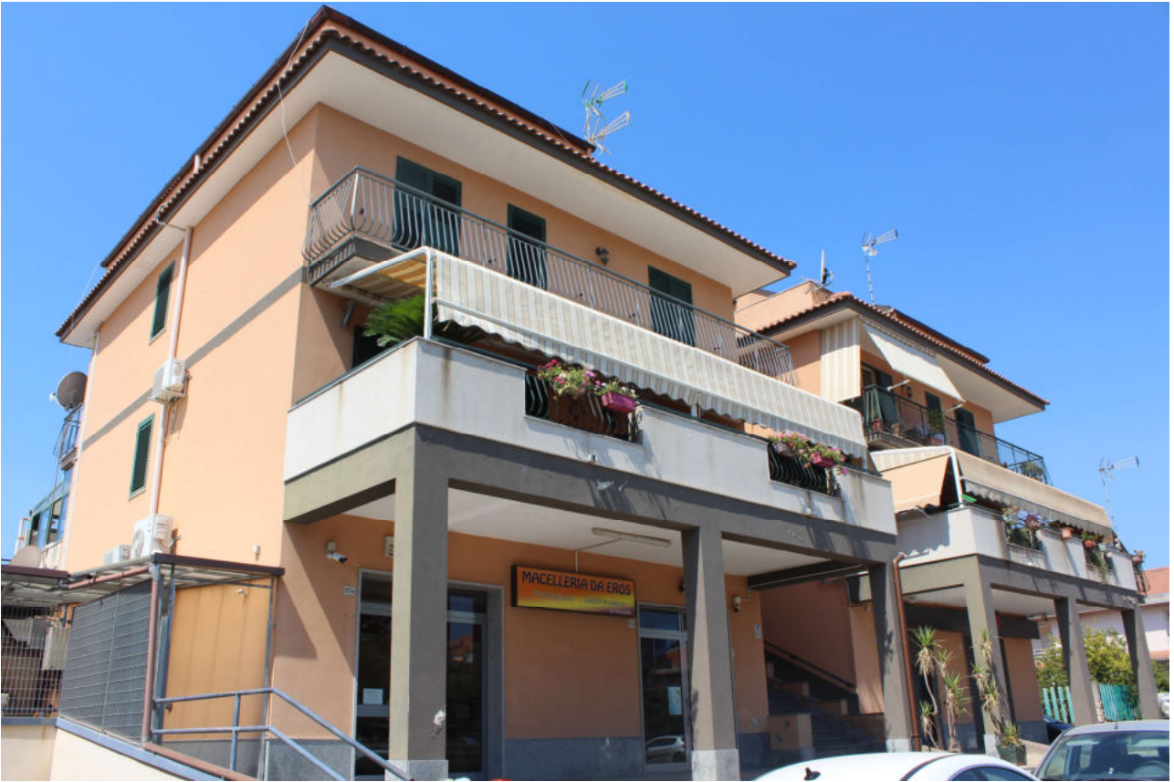
Foto n. 1 – Vista fabbricato in condominio
