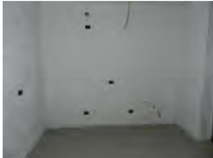
ed al bagno attrezzato con piatto doccia ed impianti idraulici , mancano le piastrelle sia a pavimento che a rivestimento e le tinteggiature
