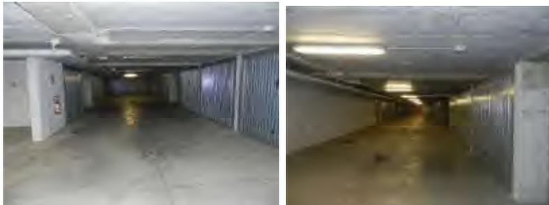
I serramenti sono costituiti da basculanti in ferro zincate (tranne il map 900/507 dove manca) , le autorimesse hanno prevalentemente l'aerazione tramite bocche di lupo .
