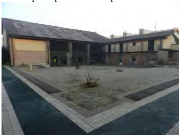
La struttura portante verticale del fabbricato è di tipo tradizionale in muratura e cemento armato , gli orizzontamenti sono in laterocemento e il sottotetto e la copertura in legno e ferro . Caratterizzano l'immobile il porticato verso la corte comune mapp. 911 la cui facciata in sfondato è stata mantenuta in mattoni faccia a vista
