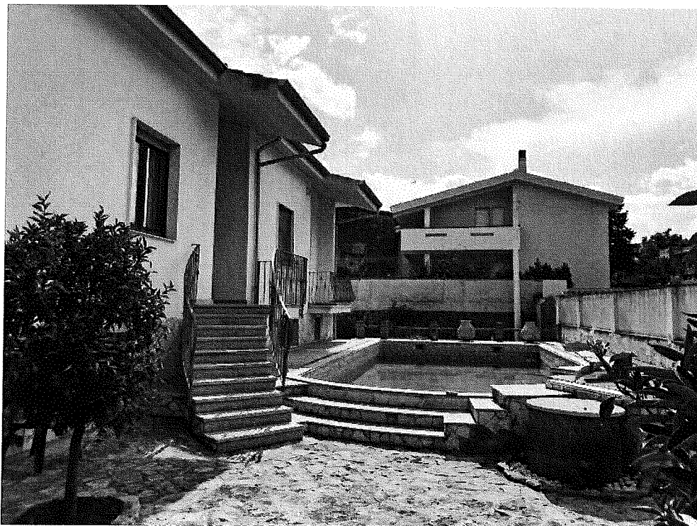
Foto 1 – Prospetto principale – Via Delle Camelie
