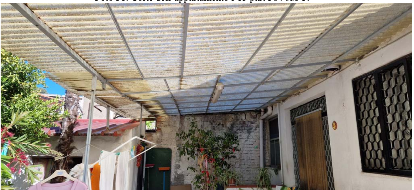
Foto 32: Tettoia realizzata nella zona ingresso da demolire.
