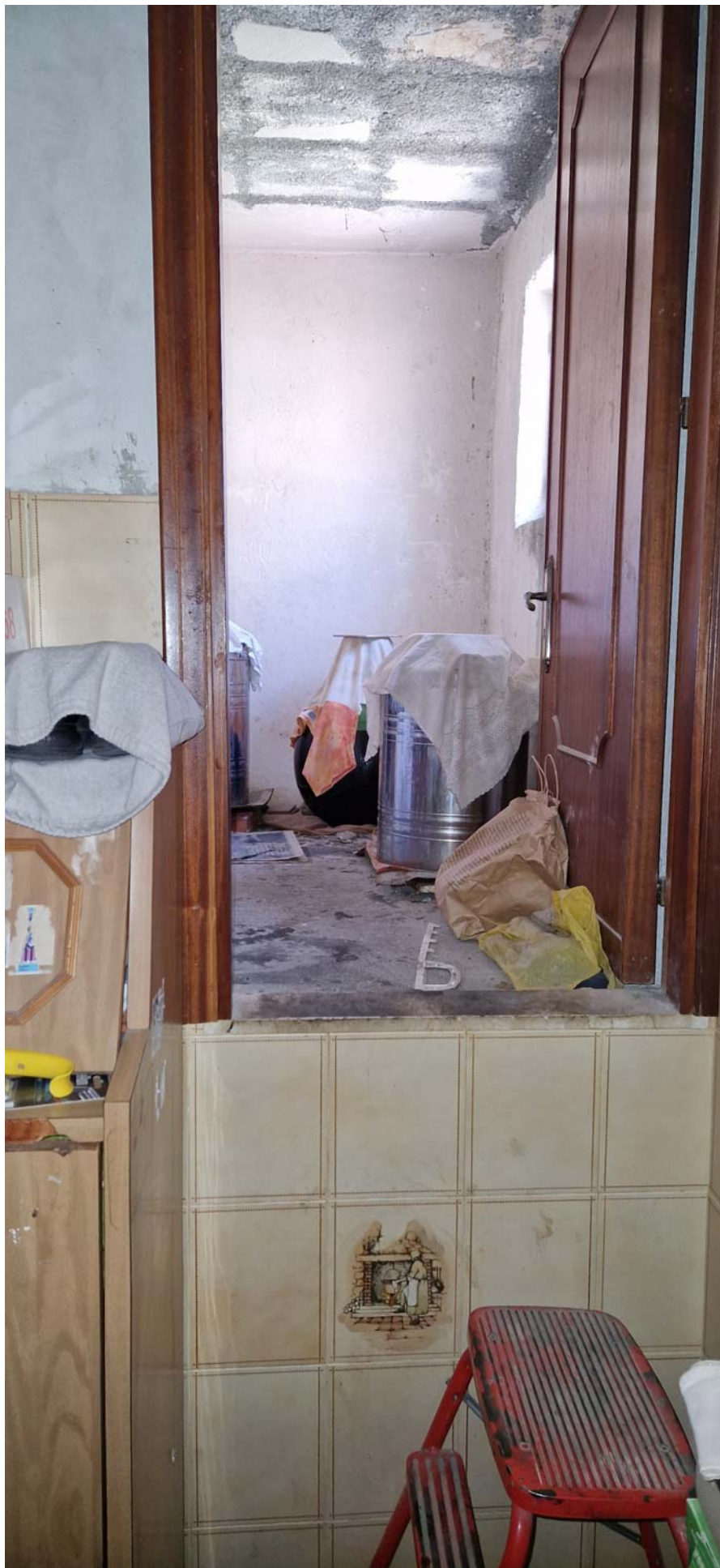
Foto 28: Appartamento censito al foglio di mappa 15 particella 564 sub 5 (ex sub 2 e 3)
