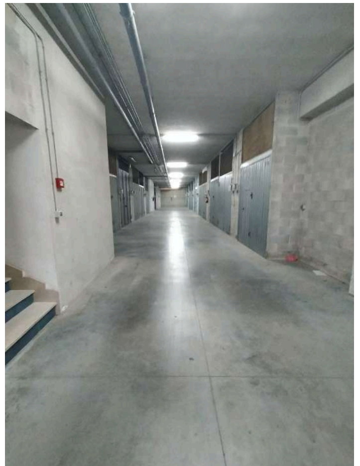
Corsia di manovra dell'autorimessa
