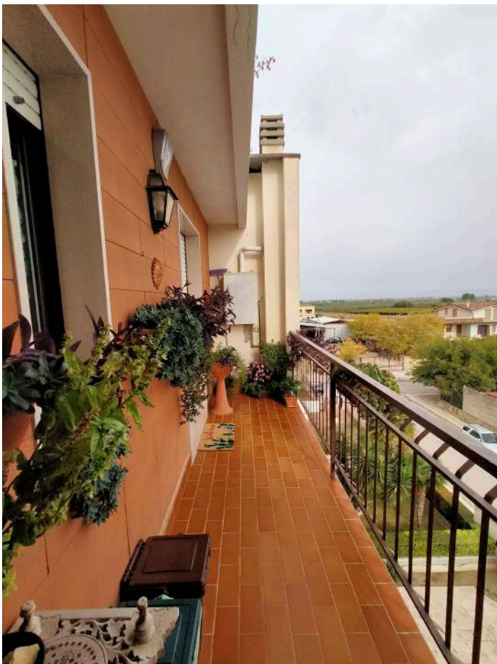
Balcone (lato est)
