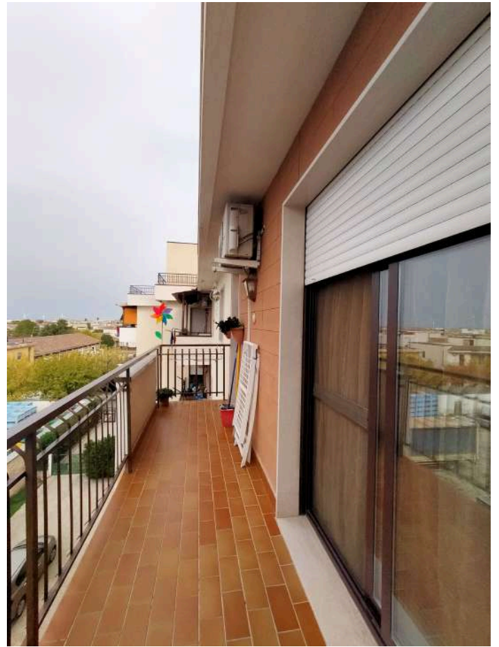
Balcone (lato ovest)
