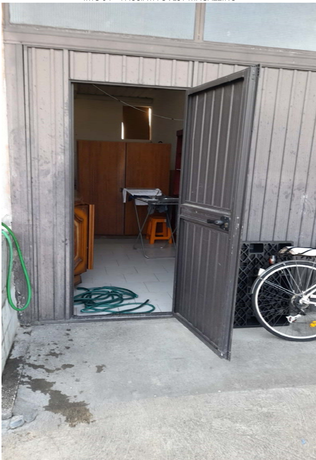
IMG 04 – FACCIATA OVEST MAGAZZINO
