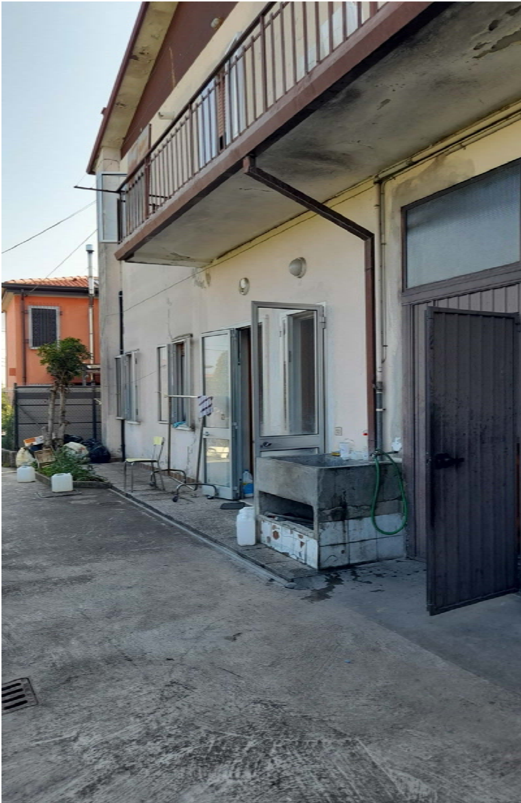
IMG 03 – ESTERNI FACCIATA OVEST
