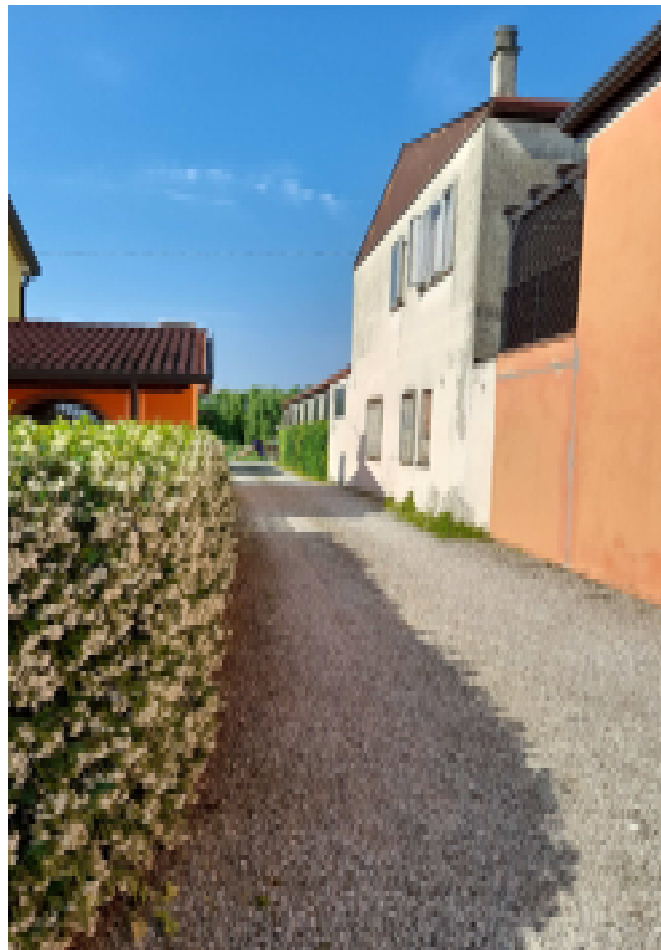
IMG 06 – ESTERNI FACCIATE EST
