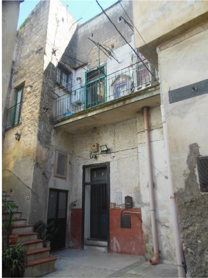
Foto 3 – Vista esterna fabbricato dal cortile comune
