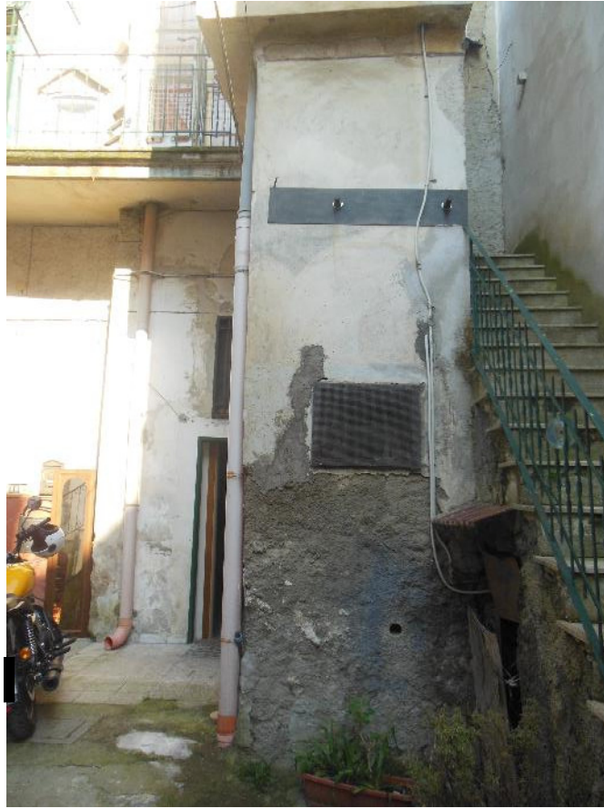
Foto 13 – Vista esterna: Piano Terra – scala di accesso al piano primo
