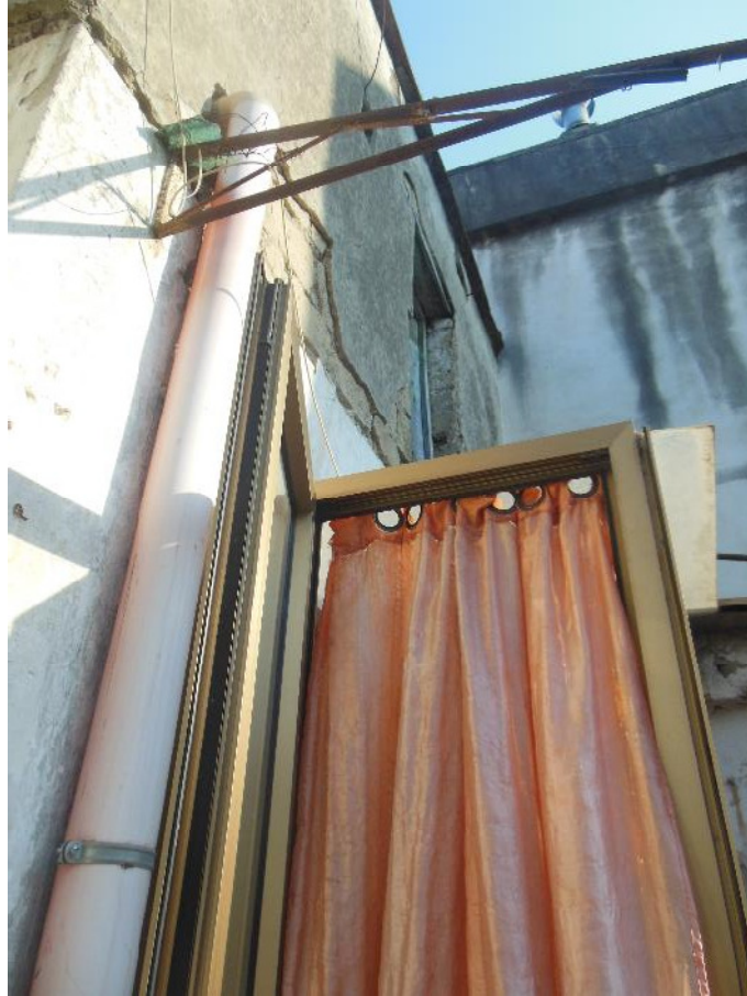
Foto 23 - Vista esterna: Piano Primo – balcone verandato
