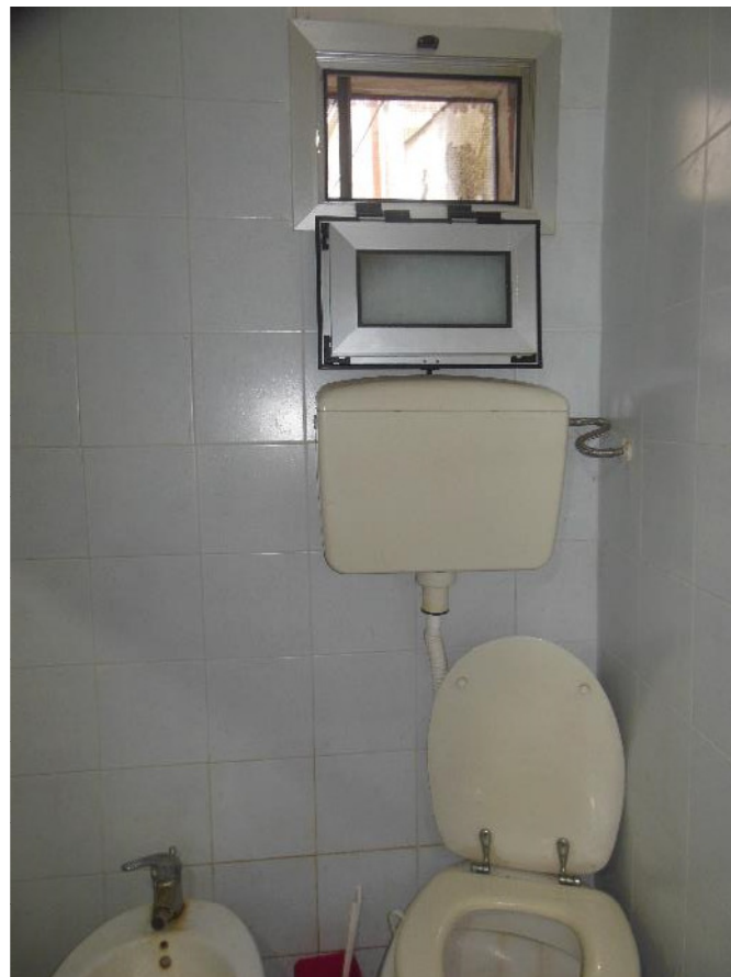
Foto 12 – Vista interna: Piano Terra – w.c. annesso al monovano con cucina
