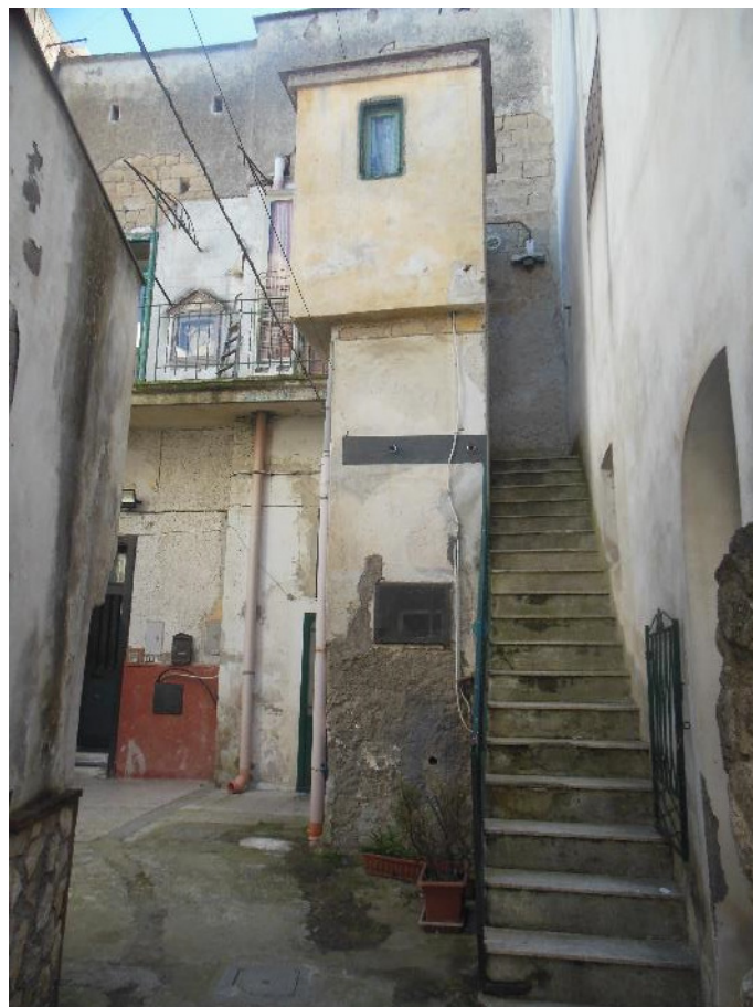
Foto 2 – Vista esterna fabbricato dal cortile comune
