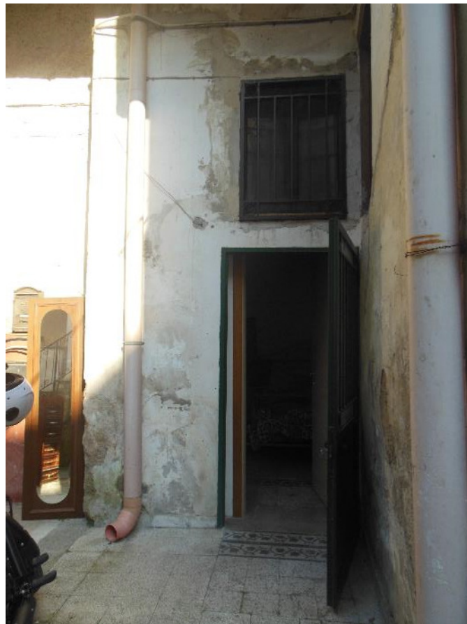
Foto 8 – Vista esterna: Piano Terra – porta di ingresso al monovano con cucina
