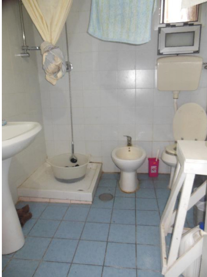
Foto 11 – Vista interna: Piano Terra – w.c. annesso al monovano con cucina
