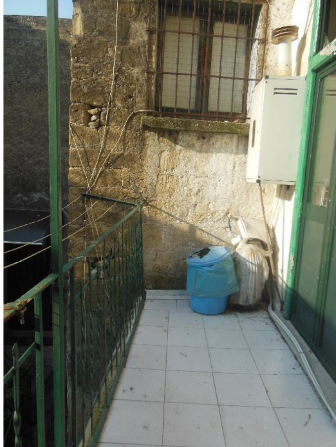
Foto 21 - Vista esterna: Piano Primo – balcone
