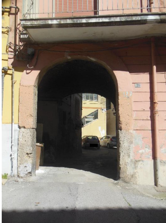
Foto 1 – Vista esterna fabbricato civico n. 120 di Via Roma: portale di accesso al borgo
