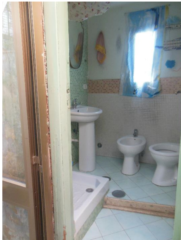
Foto 18 - Vista interna: Piano Primo - w.c.
