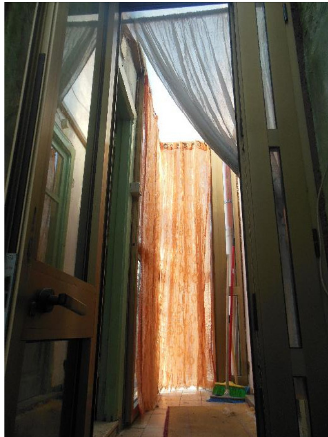
Foto 20 - Vista interna: Piano Primo – balcone verandato
