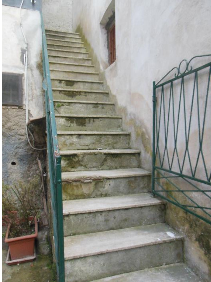
Foto 15 – Vista esterna: Piano Primo - scala di accesso
