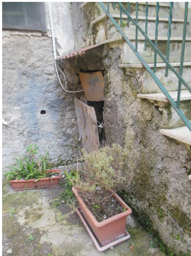
Foto 14 – Vista esterna: Piano Terra – ripostiglio sottoscala
