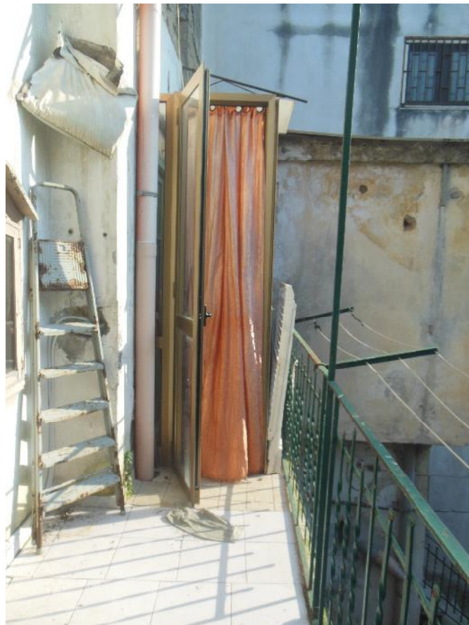
Foto 22 - Vista esterna: Piano Primo – balcone
