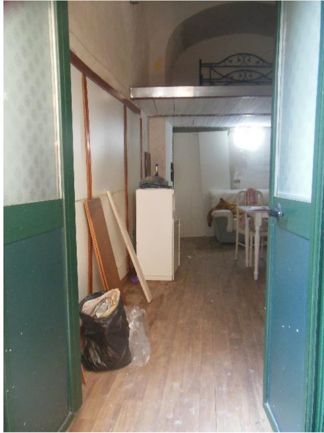
Foto 5 - Vista interna: Piano Terra - monovano soppalcato
