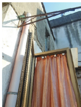
Finestra sottotetto piano secondo
