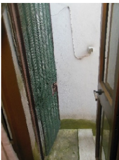
Porta di ingresso al piano primo
