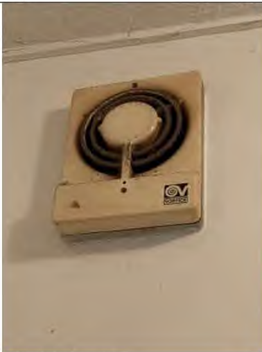
Aerazione artificiale bagno
