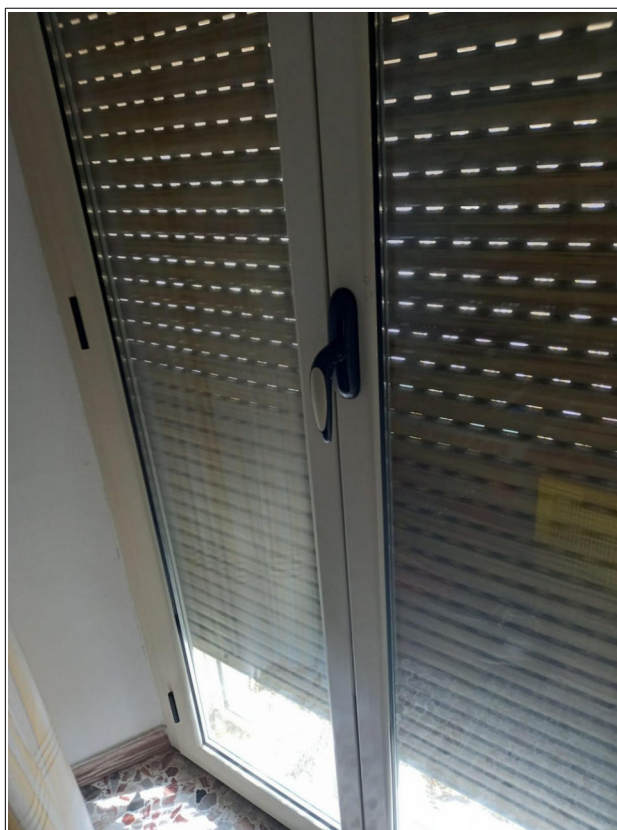
Infisso esterno al piano primo
