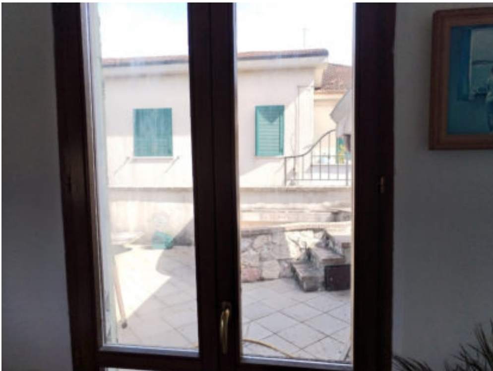
Foto n°17: porta di accesso al terrazzo
