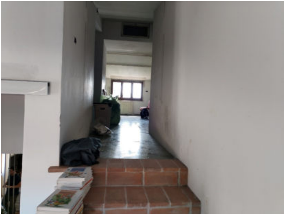
Foto n°19: scala di accesso alla soffitta
