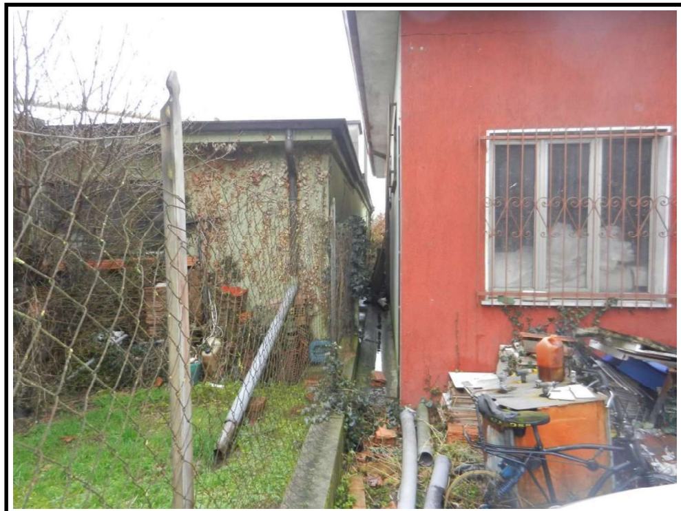
Foto 2 Particolare distanza dal confine
