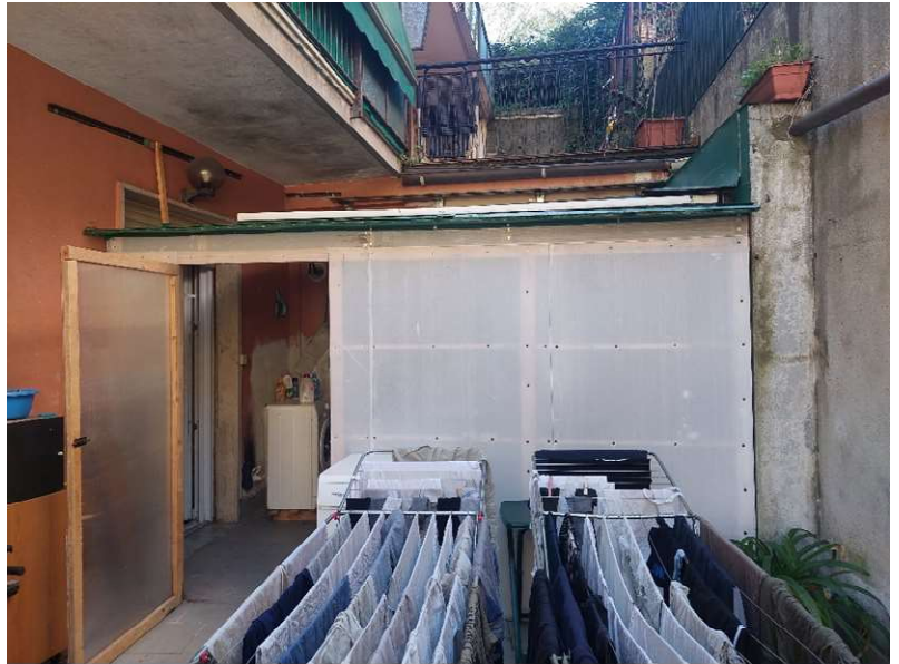
FOTO 16: Struttura lignea posta a schermare frontalmente la tenda da sole in modo da costituire una sorta di veranda a protezione dell'accesso al vano allo stato attuale annesso all'u.i., non oggetto della presente procedura
