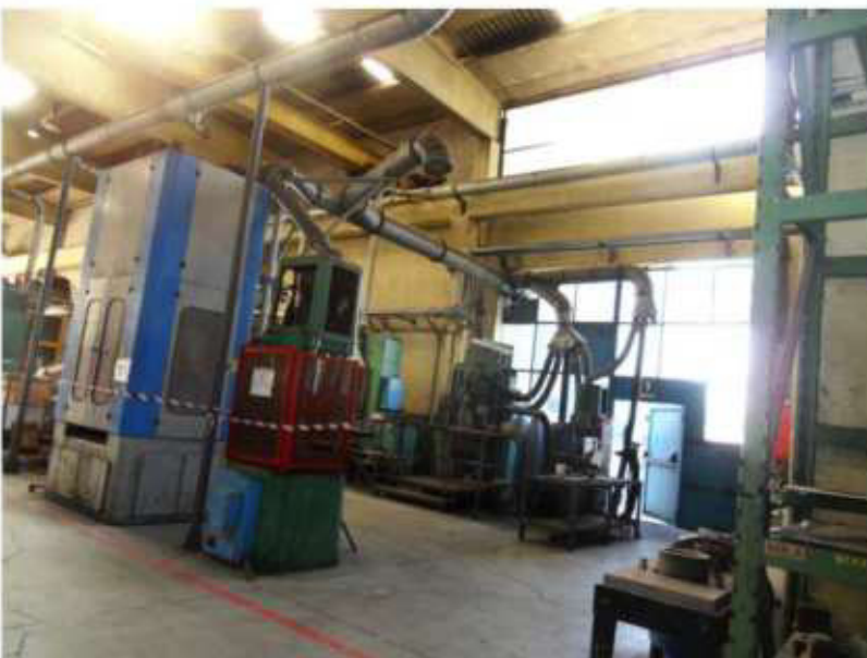
Foto 23A: Capannone - Zona lavorazione
