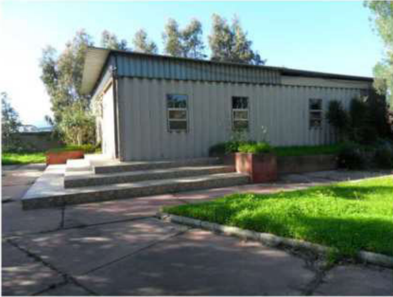
Foto 30A: Fabbricato uffici
