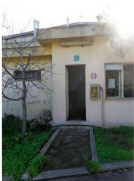
Foto 8A: Prospetto Nord - Ingresso
