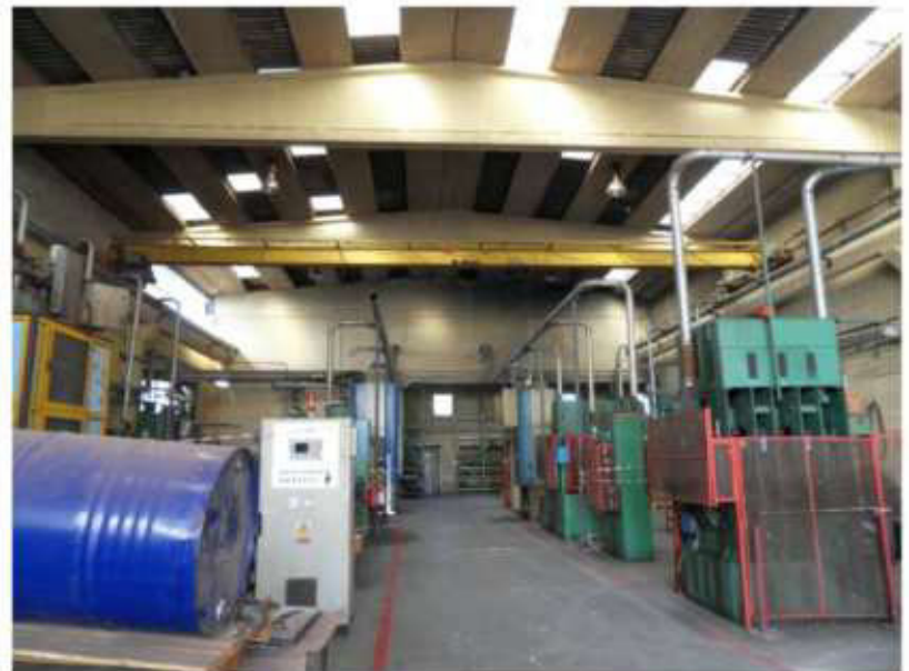
Foto 22A: Capannone - Zona lavorazione
