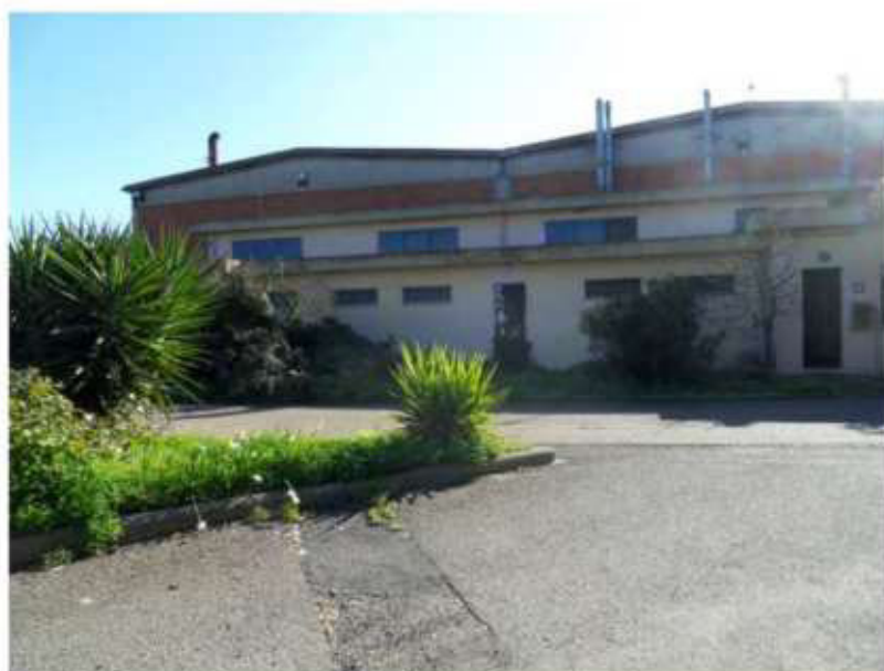
Foto 7A: Prospetto Nord
