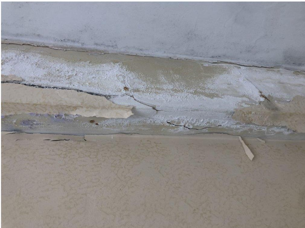
Foto n.17 Vista della trave della camera esposta a nord-ovest interessata da degrado dovuto ad infiltrazioni d'acqua.
