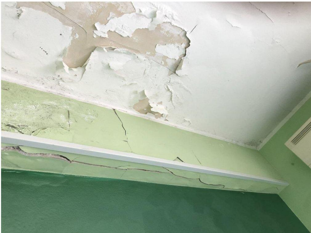
Foto n.19- Vista della trave della camera esposta a nord-est interessata da degrado dovuto ad infiltrazioni d'acqua..
