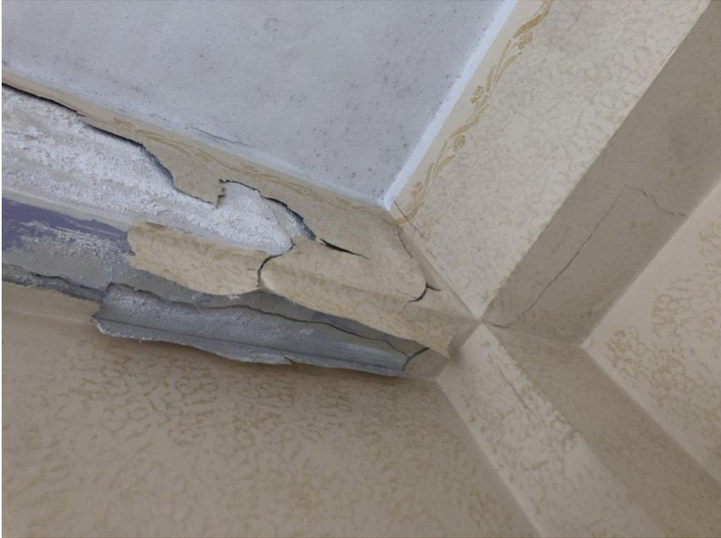
Foto n.18 Vista della trave della camera esposta a nord-ovest interessata da degrado dovuto ad infiltrazioni d'acqua.
