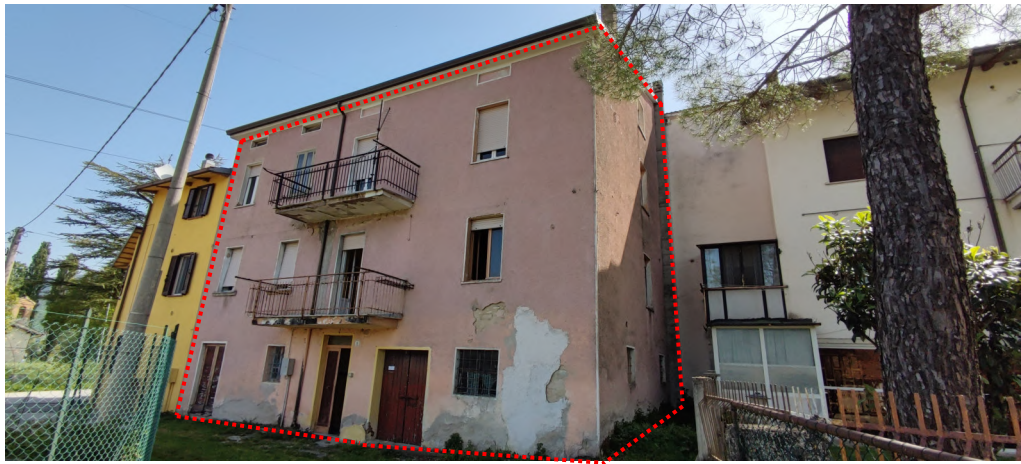
Foto 1 prospetto ovest (ingresso)
