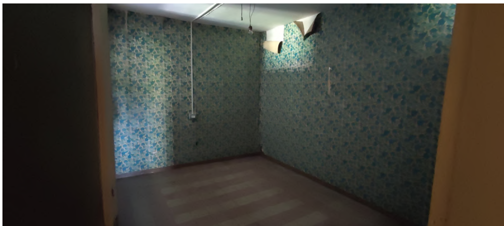
Foto 12 locale di sgombero 2° p.
