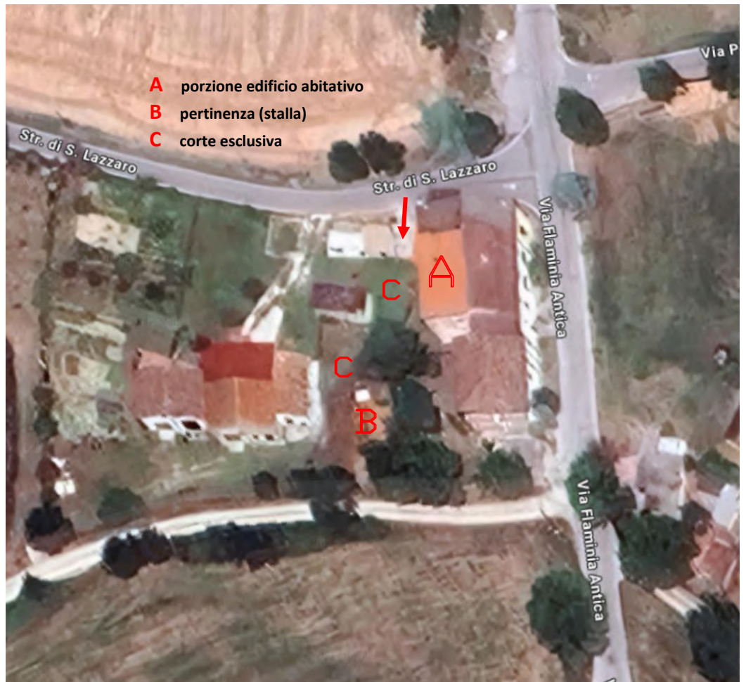
B) FOTO AEREA CON INDICAZIONE DEGLI IMMOBILI IN OGGETTO
