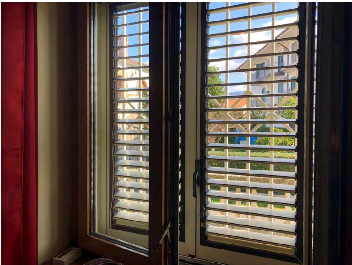
Foto 18 - Immobile sub.2 - Infisso esterno.
