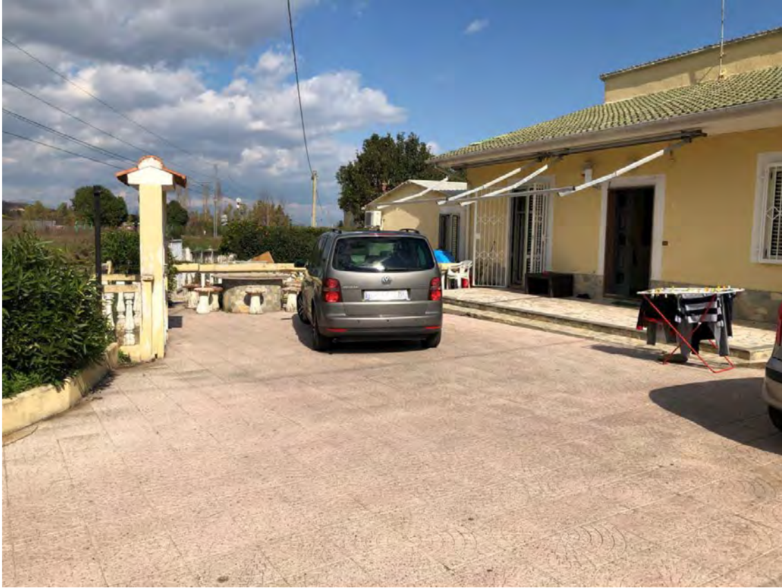
Foto 1 - Corte esterna sub.8 e immobile sub.2.
