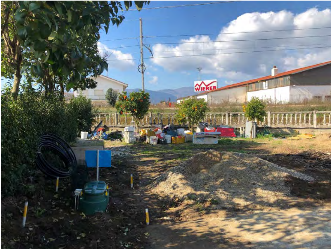
Foto 5 - Corte esterna sub.7 e serbatoio GPL interrato.
