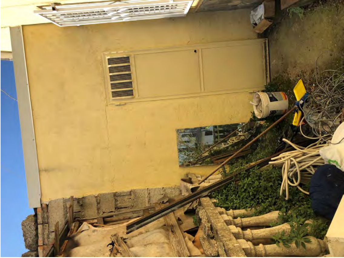
Foto 21 - Immobile sub.5 - Box.
