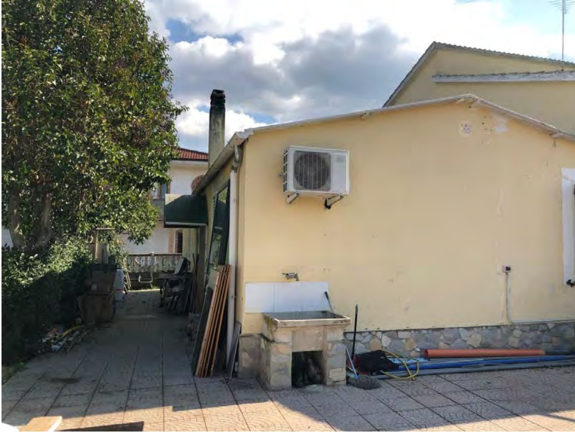
Foto 3 - Corte esterna sub.7 e immobile sub.6.
