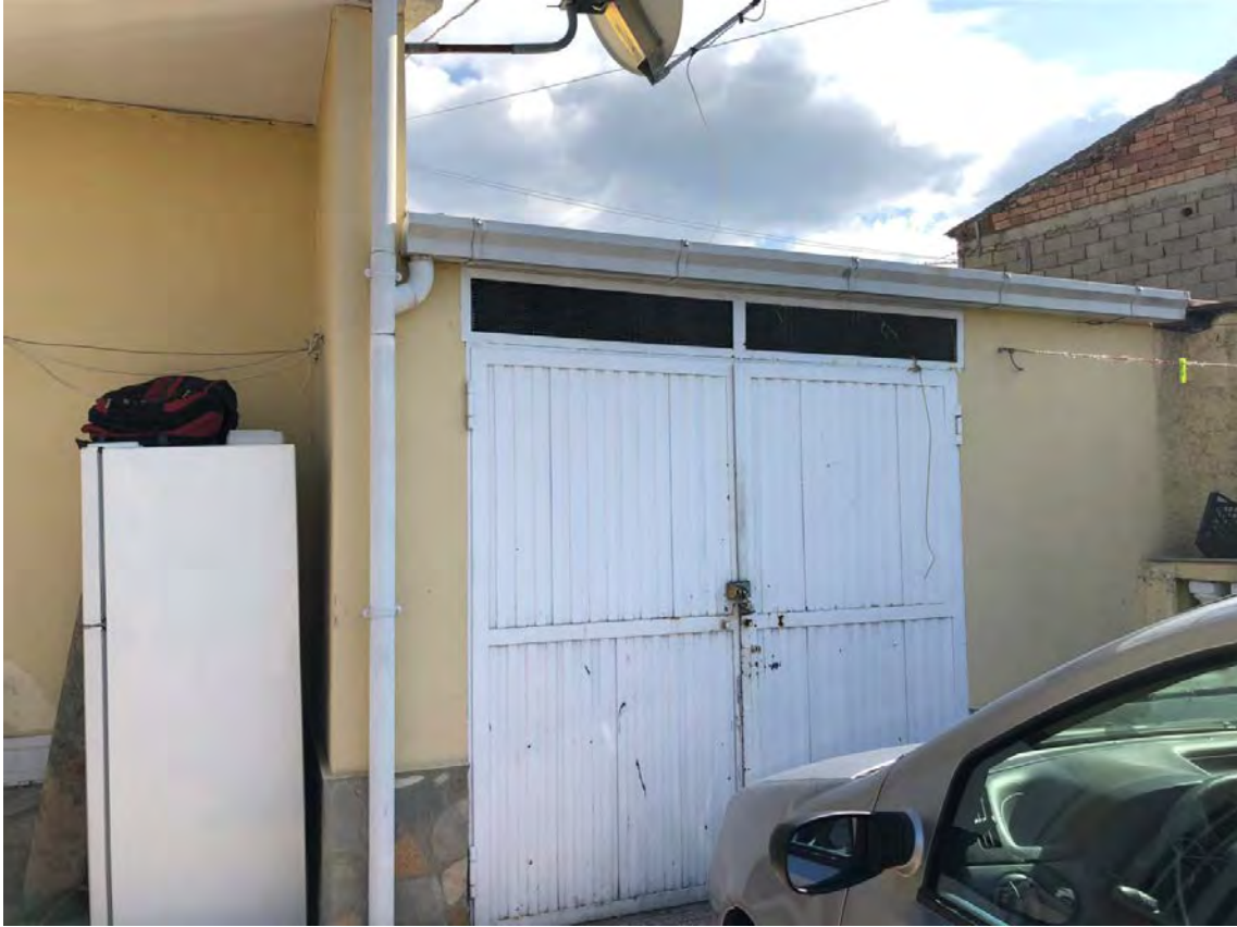
Foto 19 - Immobile sub.4 - Box.
