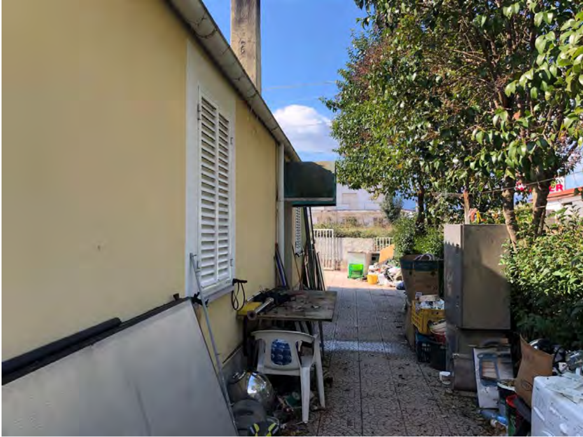
Foto 23 - Immobile sub.6 - Esterno.
