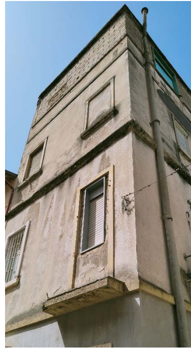
Foto 2 prospetto lato nord
