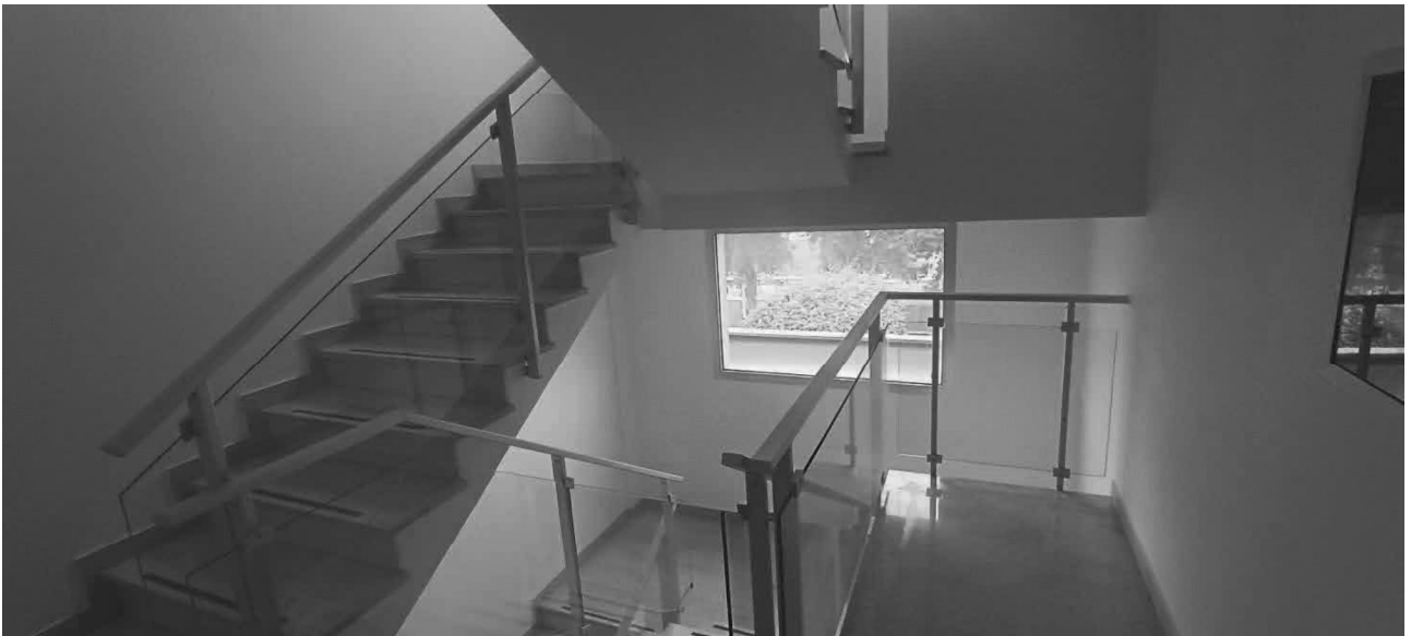
Foto n. 8 rampe scale al piano primo
