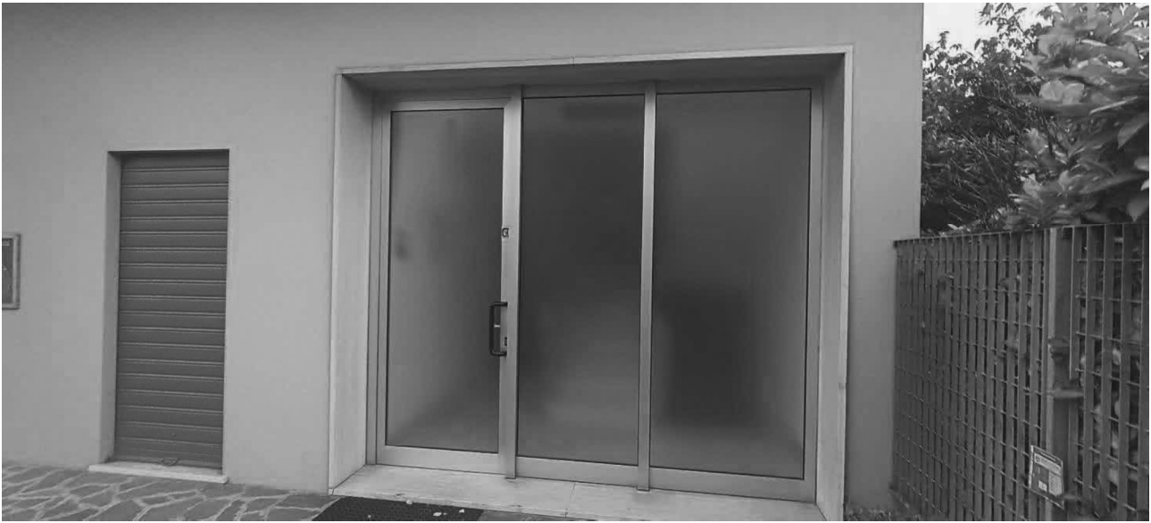
Foto n. 5 Portone di ingresso allo stabile su via cappelletto
