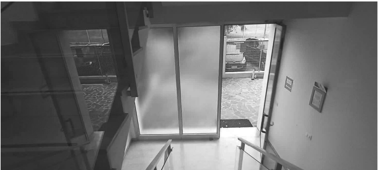
Foto n. 6 Portone di ingresso allo stabile su via cappelletto
