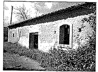
Fabbricato rurale, C.da Catanese - Augusta
