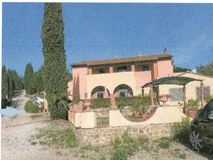
Foto 1 – vista del fabbricato del resede a comune e dell'accesso
