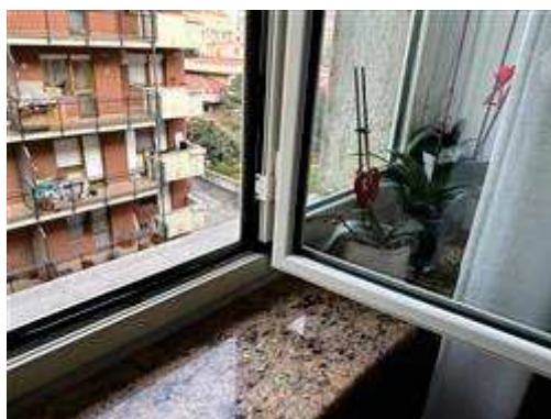
Particolare dei serramenti esterni.
